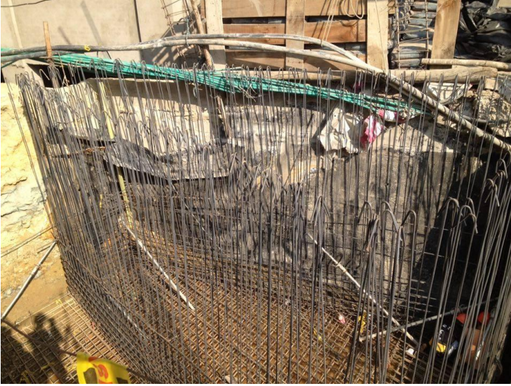
Foto 7. Acero de refuerzo
