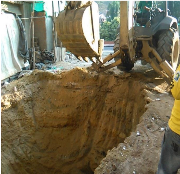
Foto 2. Excavación mecánica
