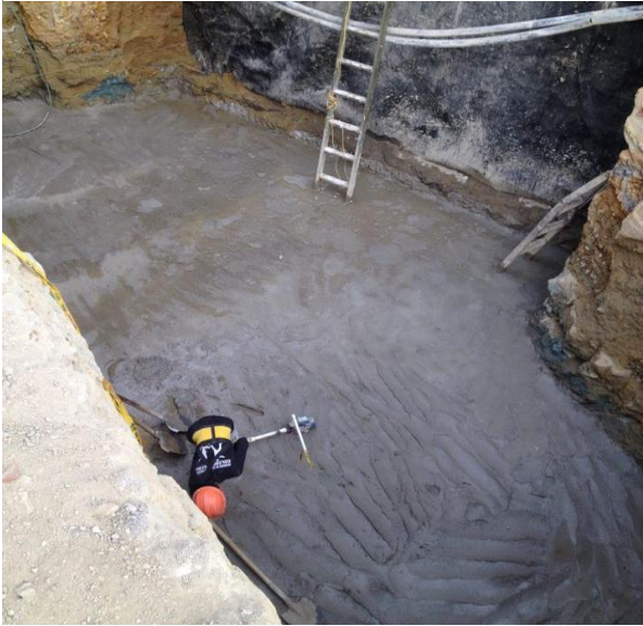
Foto 5. Concreto de limpieza
