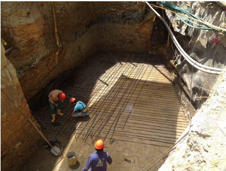
Foto 6. Acero de refuerzo
