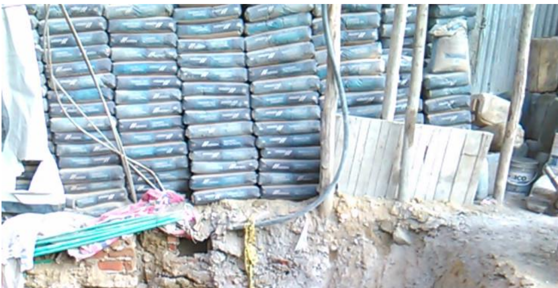
Figura 4. Almacenamiento de cemento
