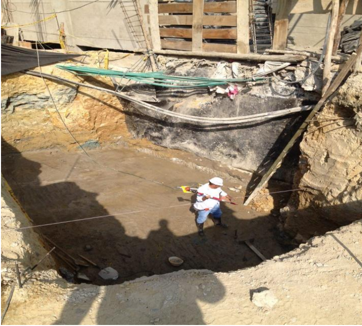
Foto 3. Localización y replanteo
