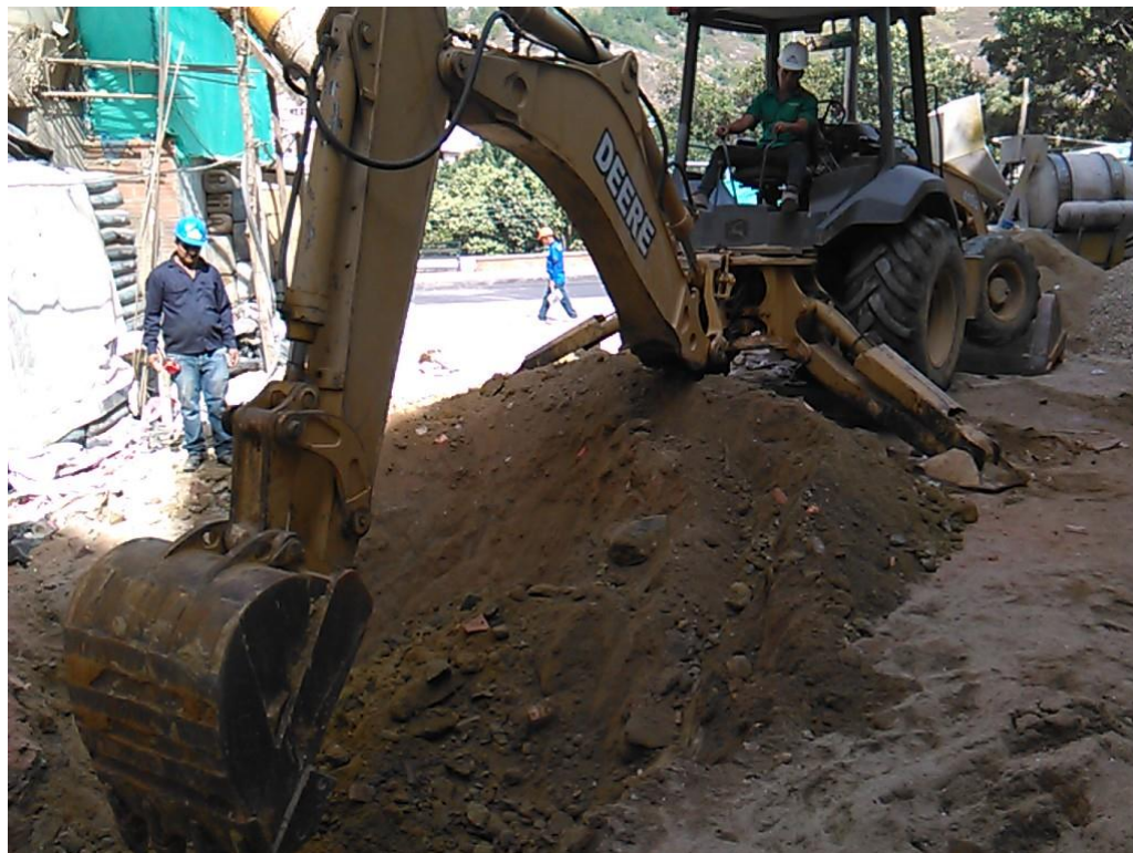
Figura 1. Maquinaria y movimiento de tierra
