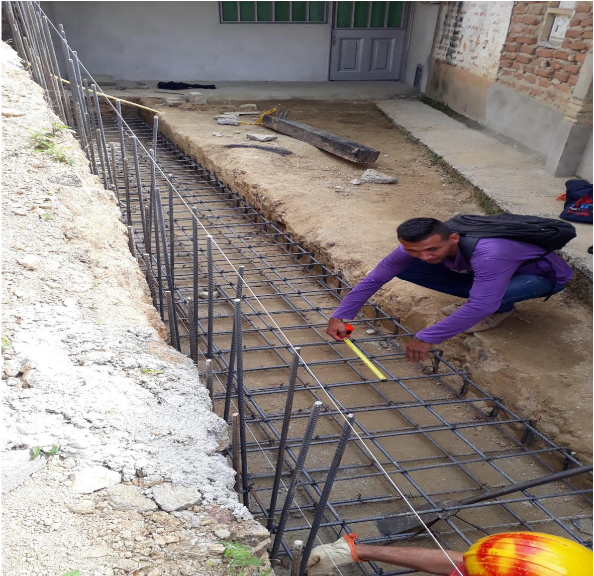
Figura 21. Verificación de espaciamiento del acero.
