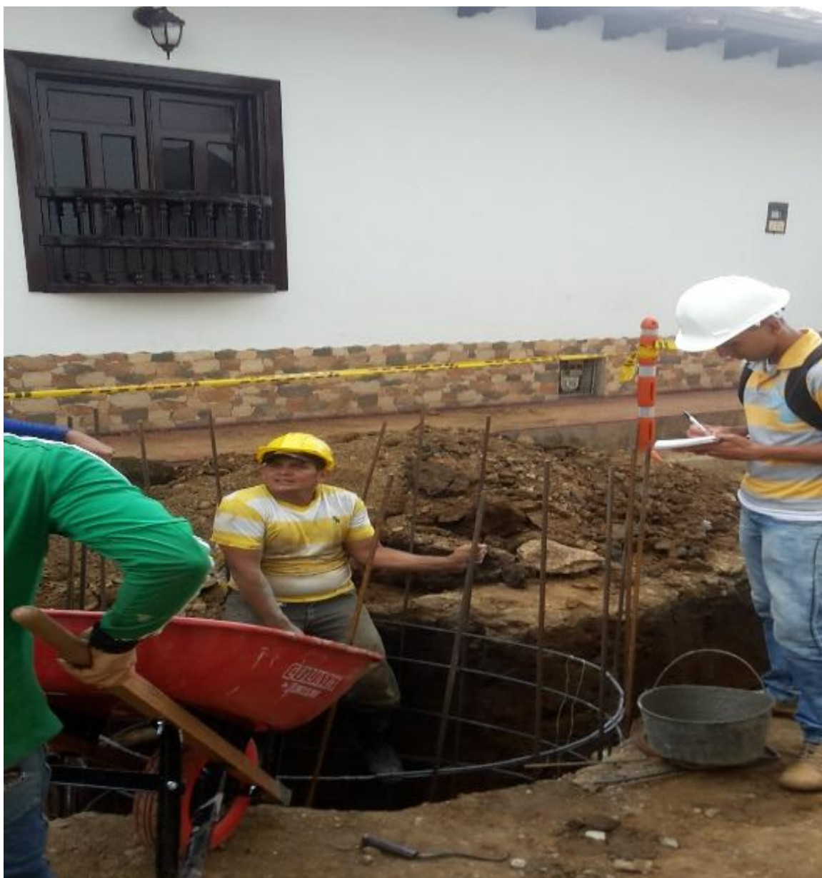
Figura 33. Trabajadores con los equipos de seguridad en la construcción del pozo.
