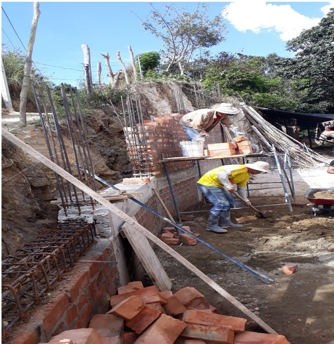
Figura 30. Se continua el levantamiento de muros.
