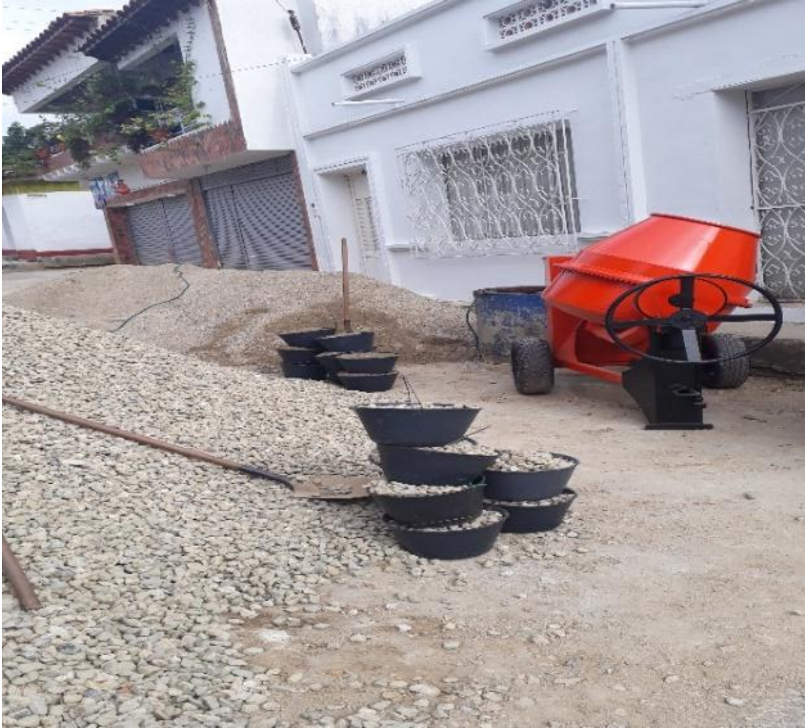
Figura 17. Dosificación de materiales medida en baldes.
