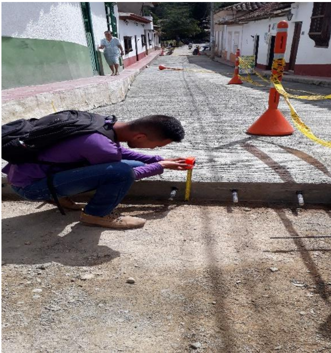
Figura 18. Verificación de espesor de las losas de concreto.
