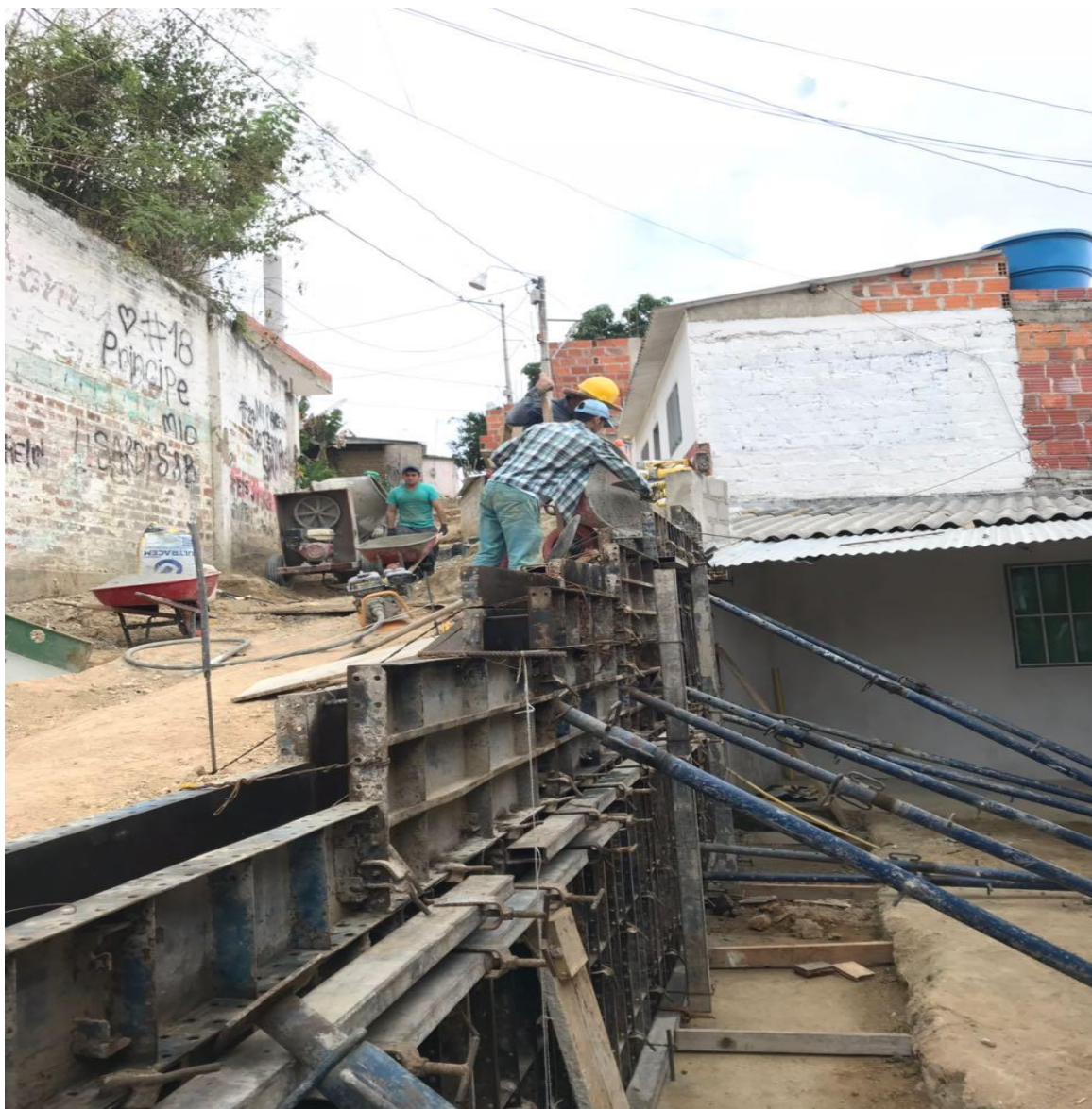
Figura 23. Fundición del muro.
