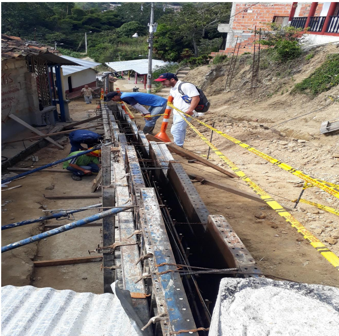
Figura 22. Instalación de formaletas.
