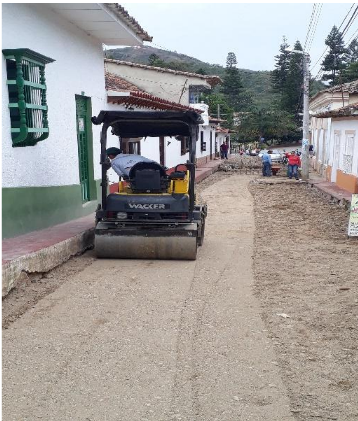
Figura 16. Compactación de la subbase.
