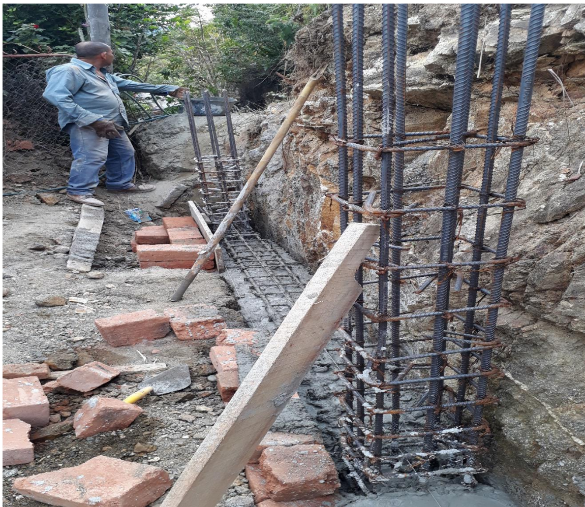
Figura 27. Viga de cimentación.
