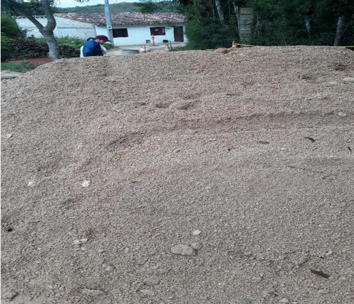
Figura 11. Agregado fino utilizado en obra.
