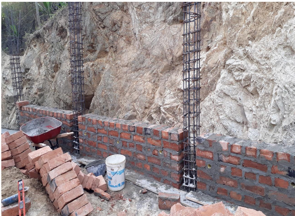
Figura 28. Levantamiento de muro
