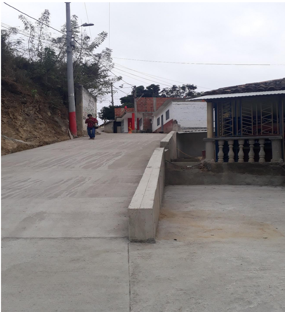
Figura 25. Obra del Muro terminada en su totalidad.
