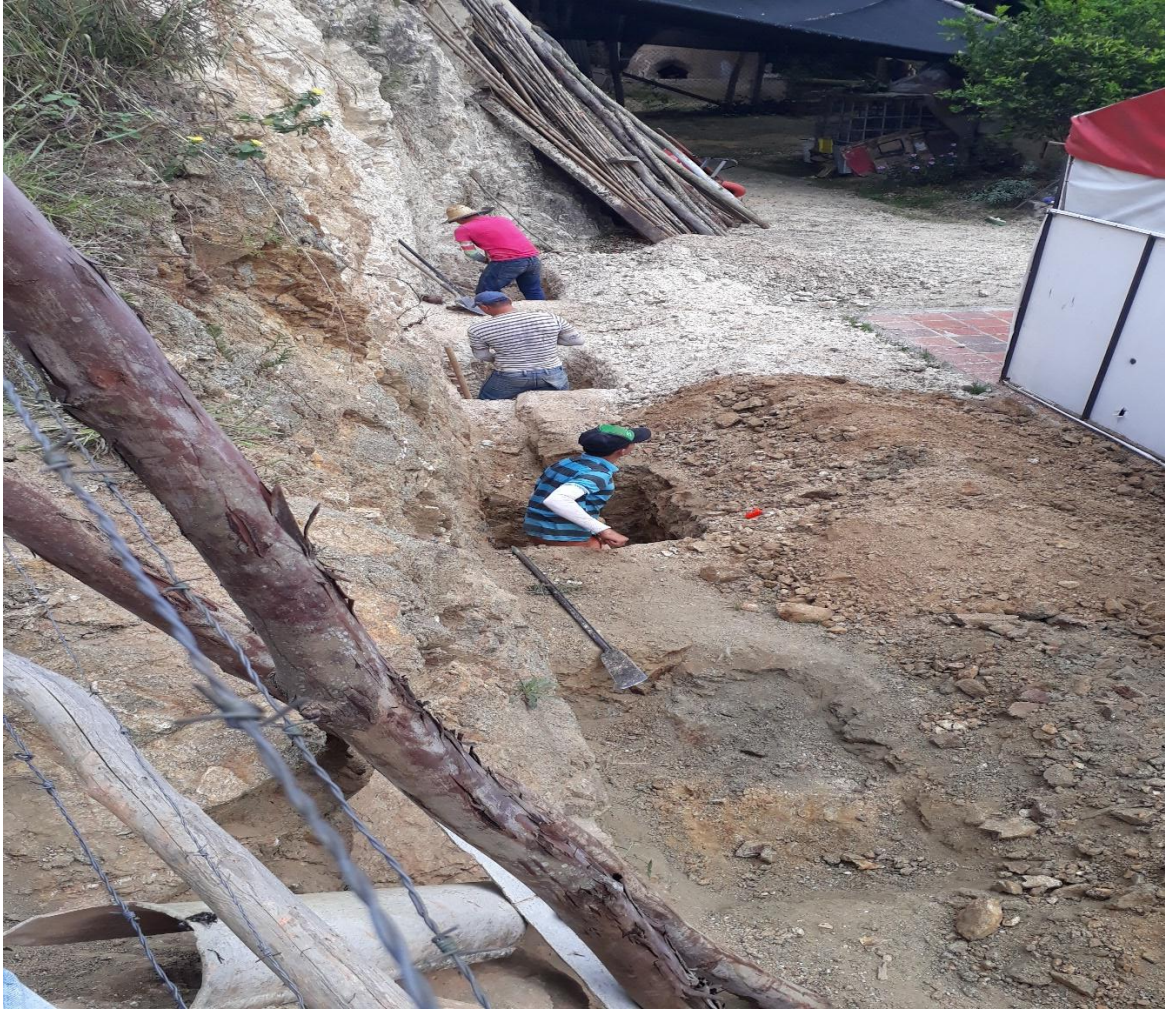
Figura 26. Excavaciones de zapatas.
