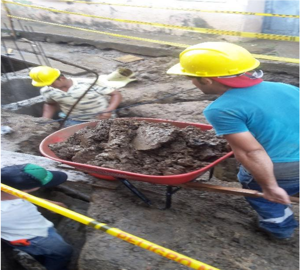
Figura 34. Señalización de la obra y retiro de material excavado.
