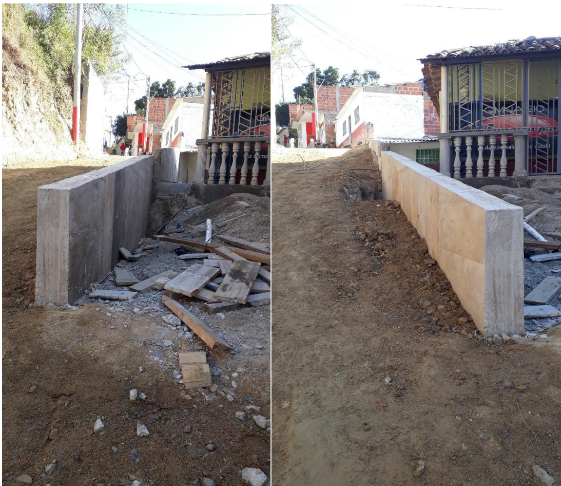
Figura 24. Muro desencofrado.
