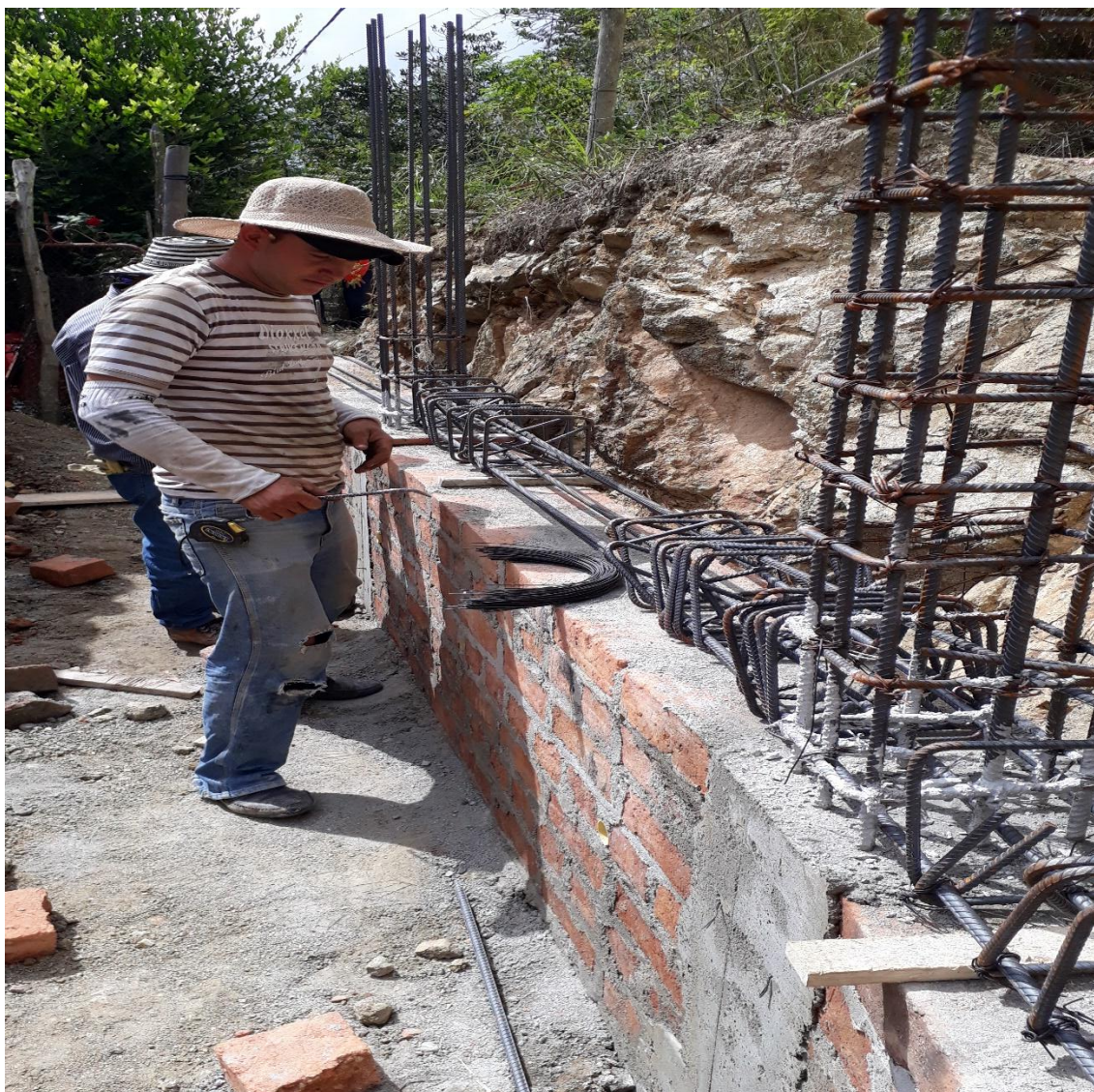
Figura 29. Figurado vigas de confinamiento.
