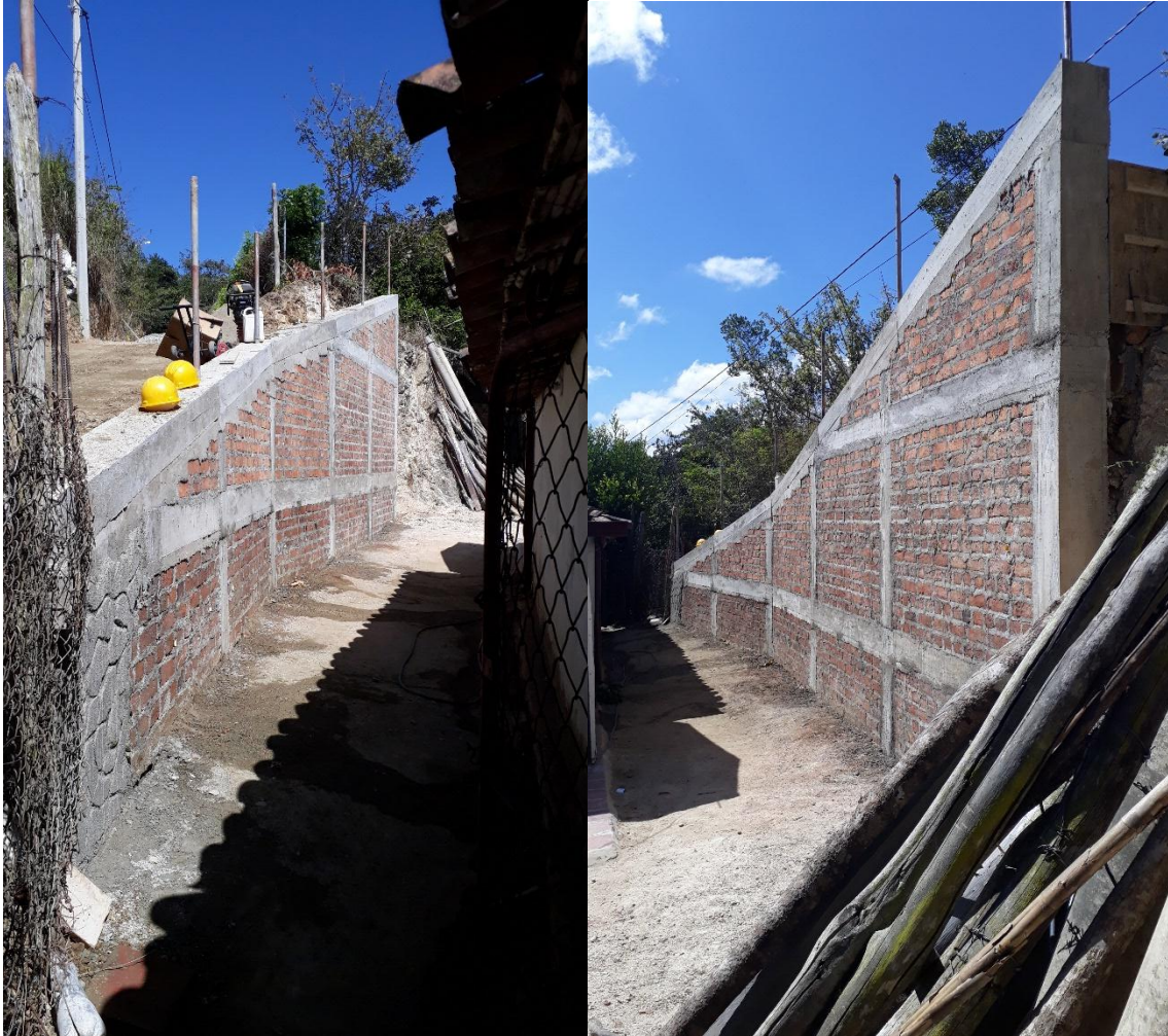
Figura 31. Muro construido en su totalidad.
