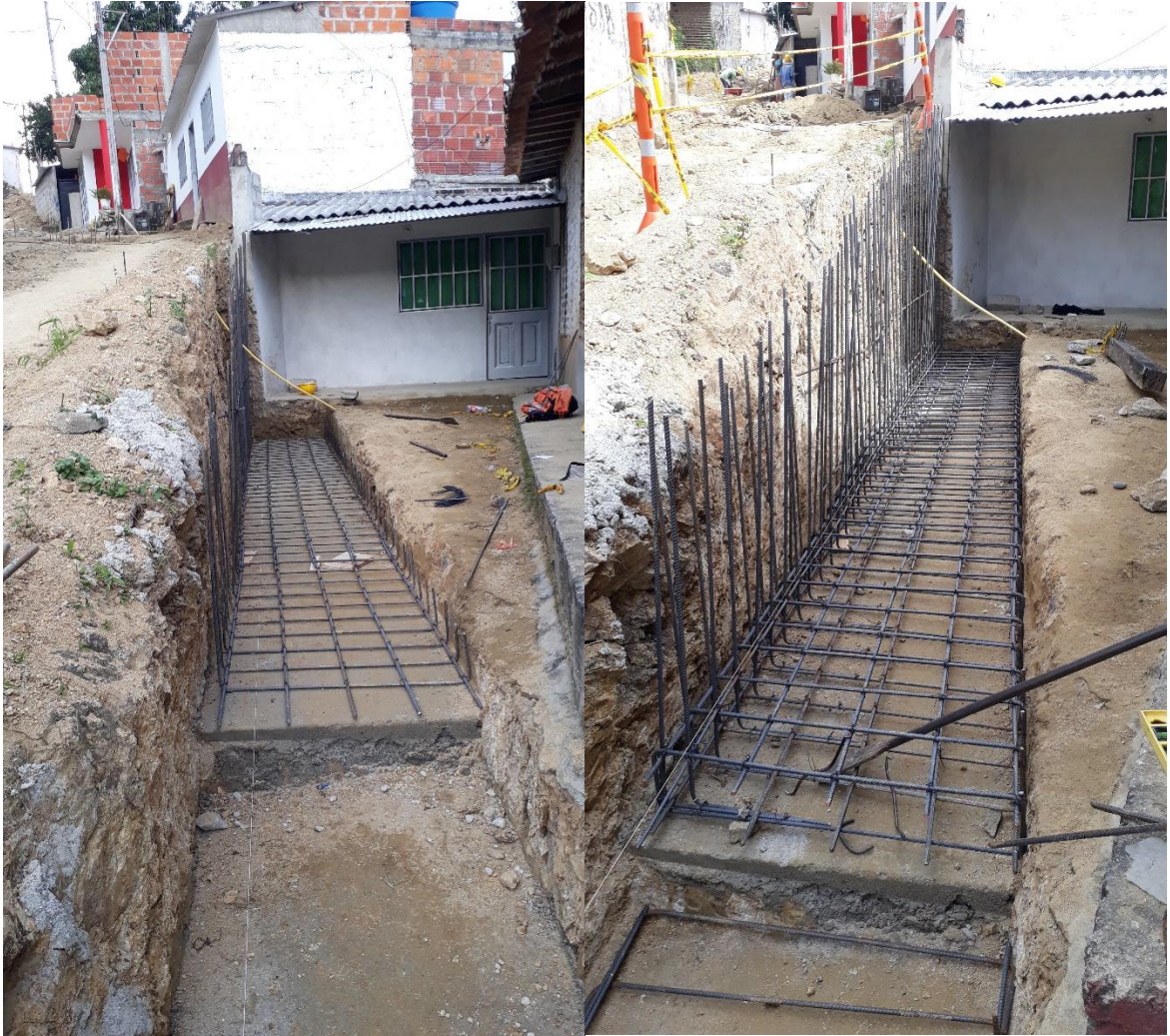
Figura 20. Armado del acero.
