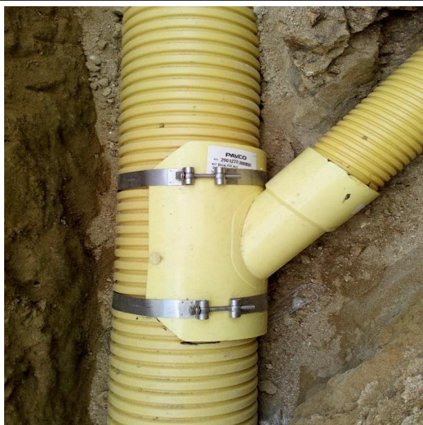
Descripción: instalación silla yee 8" x 4". Ubicación: Calle Jerusalén. Fecha: 03/11/2017.
