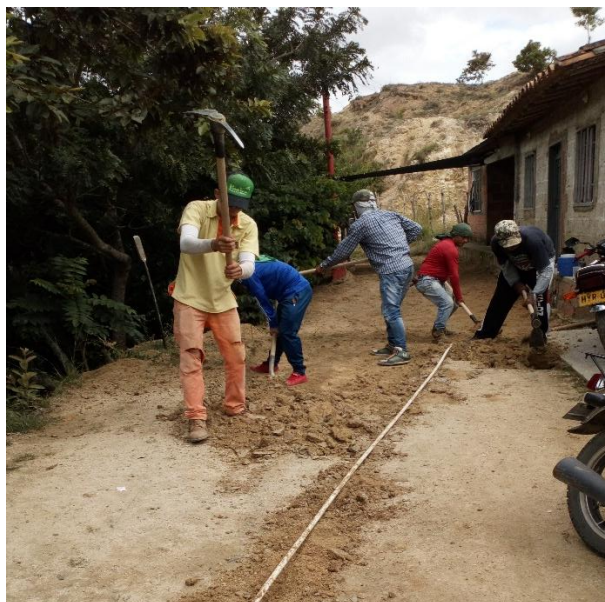
Descripción: descapote manual, esp=0.20mt. Ubicación: Calle El Faro. Fecha: 09/11/2017
