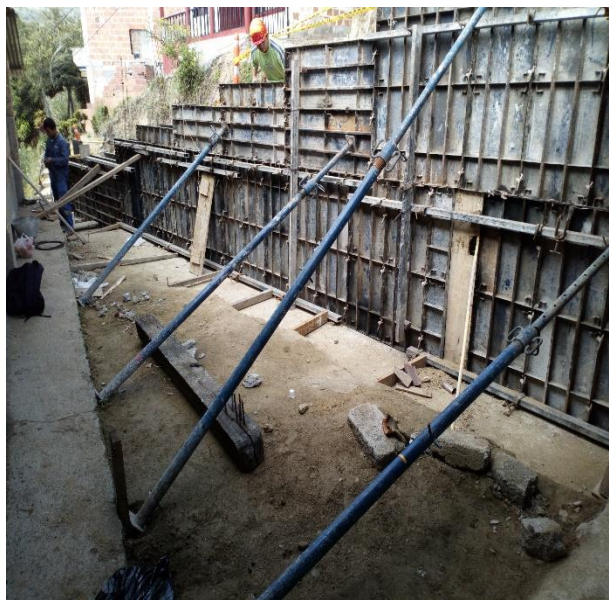
Descripción: encofrado de muro de contención. Ubicación: Calle Jerusalén. Fecha: 27/10/2017.
