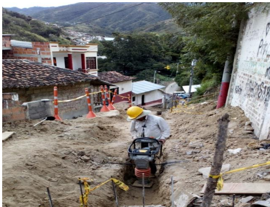
Imagen 10. Compactación de relleno de zanjas, Calle Jerusalén. Fuente: pasante del proyecto.
