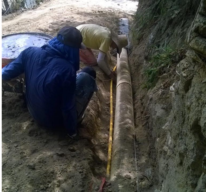
Imagen 15. Recubrimiento para protección de tuberías superficiales existentes. Fuente: pasante del proyecto.
