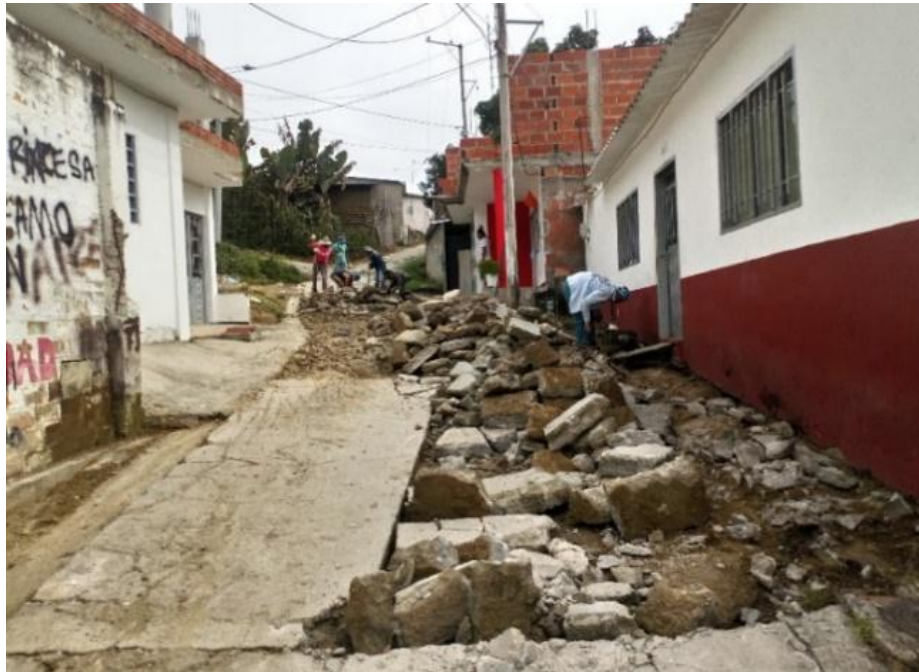
Imagen 1 Demolición pavimento existente, Calle Jerusalén.
