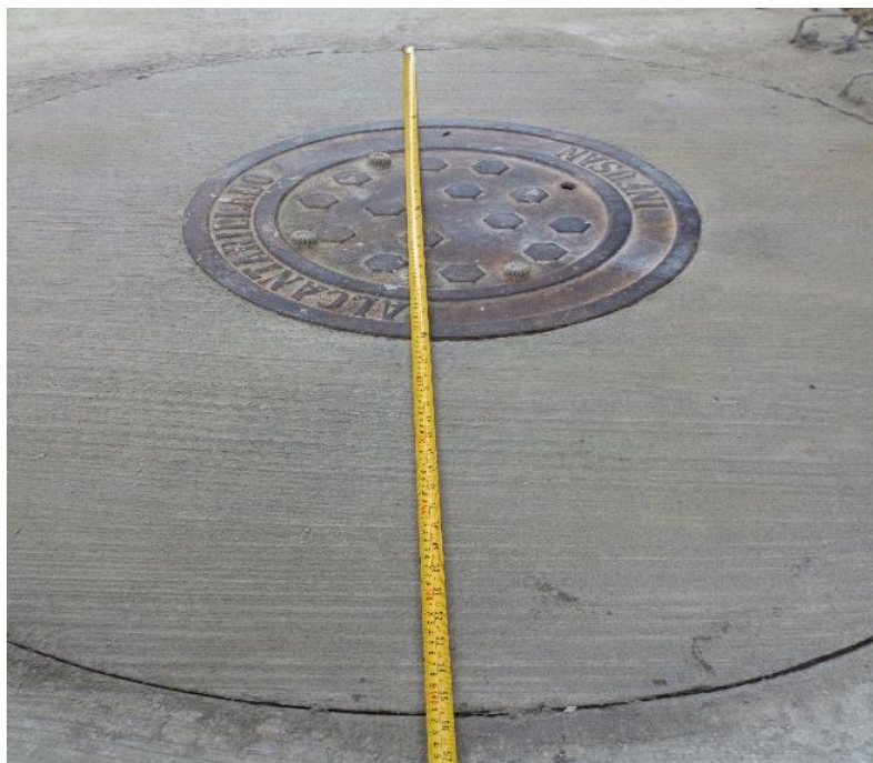
Imagen 16. Reconstrucción de tapas de pozos de la red de alcantarillado, Calle El Faro. Fuente: pasante del proyecto.
