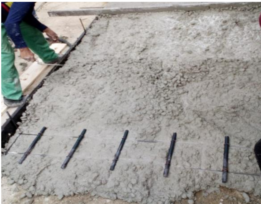
Imagen 21. Colocación de acero de refuerzo, Calle Bolívar. Fuente: pasante del proyecto.
