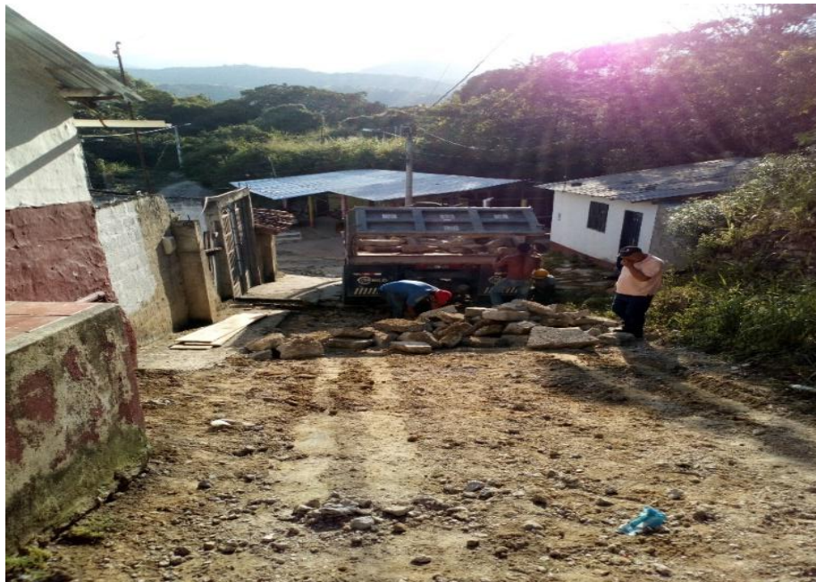
Imagen 2 Retiro de escombros, Calle Jerusalén.
