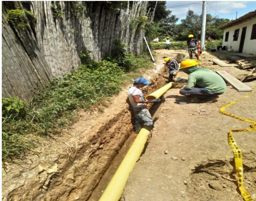
Imagen 11. Suministro e instalación de tubo 12" y 8" alcantarillado PVC, Calle Jerusalén. Fuente: pasante del proyecto.
