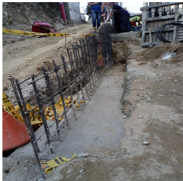
Descripción: zarpa fundida muro de contención. Ubicación: Calle Jerusalén. Fecha: 23/10/2017.
