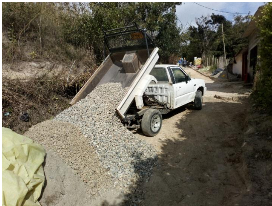
Imagen 5. Acarreo de materiales desde el punto de descargue de la volqueta hasta lugares de almacenamiento, Calle El Faro.
