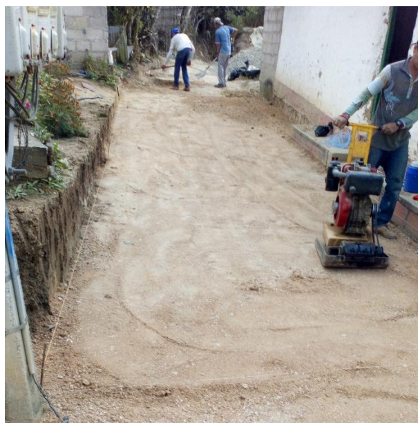
Descripción: riego y compactación con rana de sub base granular. Ubicación: Calle El Faro. Fecha: 16/11/2017.
