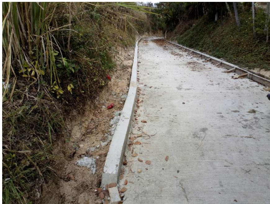
Imagen 24. Bordillos 0.15mt*0.15mt, Calle El Faro.
