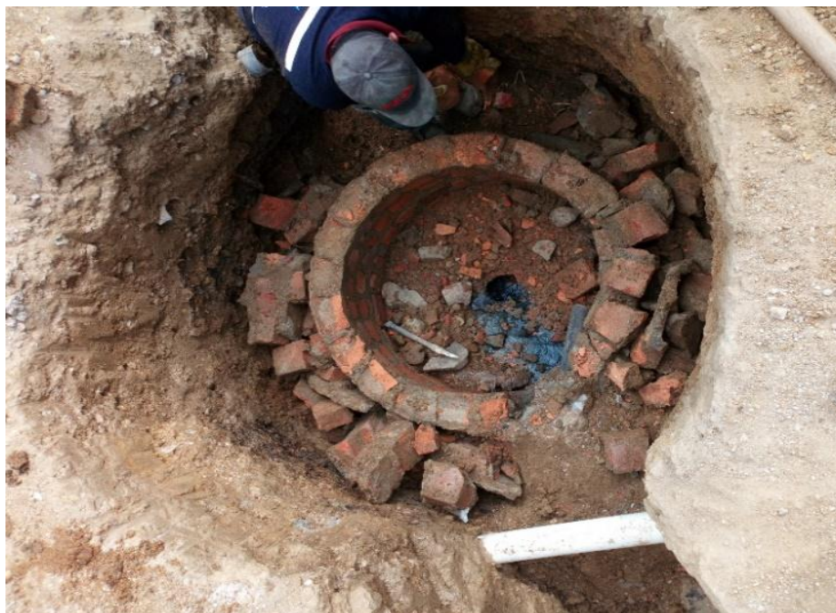
Imagen 3. Demolición de pozo existente en mal estado, Calle Jerusalén.
