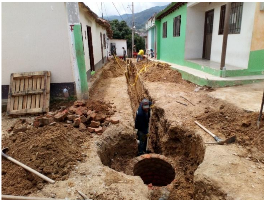
Imagen 4. Excavaciones para tubería de alcantarillado sanitario, Calle Jerusalén. Fuente: pasante del proyecto.
