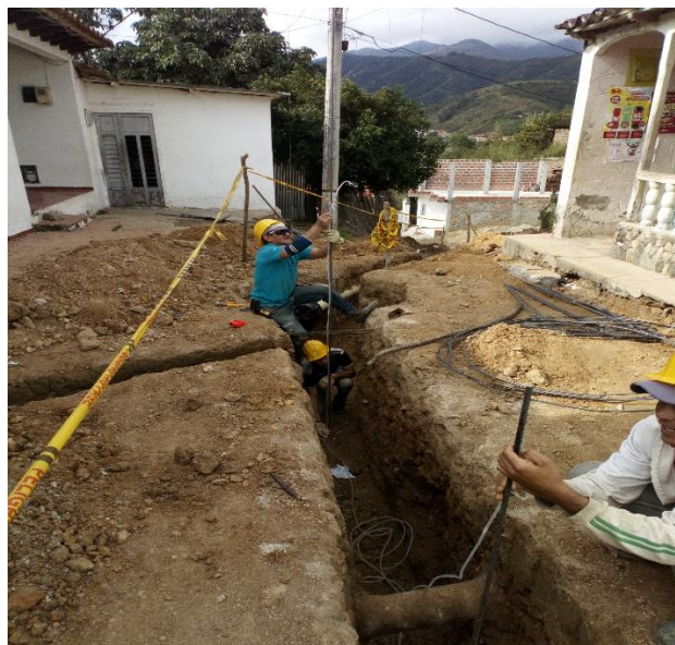
Descripción: toma de niveles de fondo de excavación para tubería sanitaria. Ubicación: Calle Jerusalén. Fecha: 27/10/2017.
