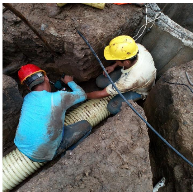
Descripción: instalación de tubo 12" alcantarillado sanitario. Ubicación: Calle Bolívar. Fecha: 24/10/2017.
