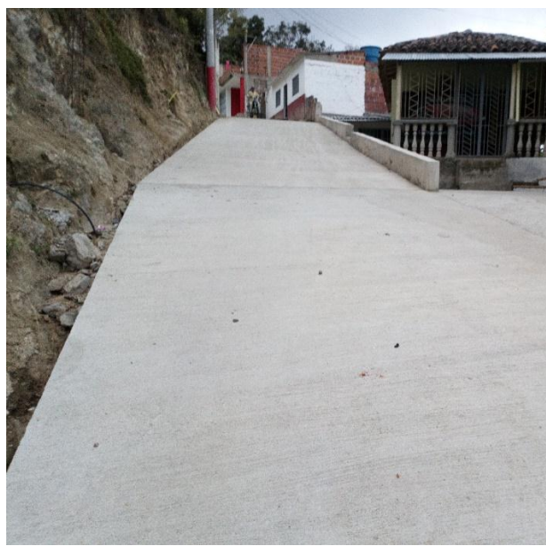
Descripción: estado final del pavimento. Ubicación: Calle Jerusalén. Fecha: 29/12/2017
