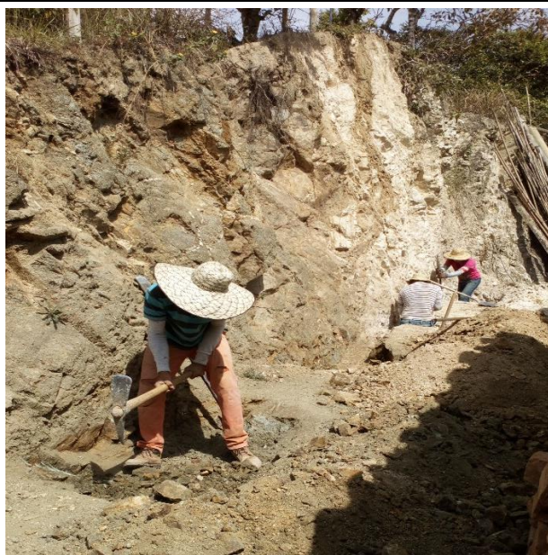
Descripción: excavación manual para zapatas de muro en mampostería confinada. Ubicación: Calle El Faro. Fecha: 07/11/2017.
