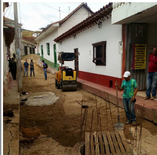
Descripción: riego y compactación con benitin de sub base granular. Ubicación: Calle Bolívar. Fecha: 07/11/2017
