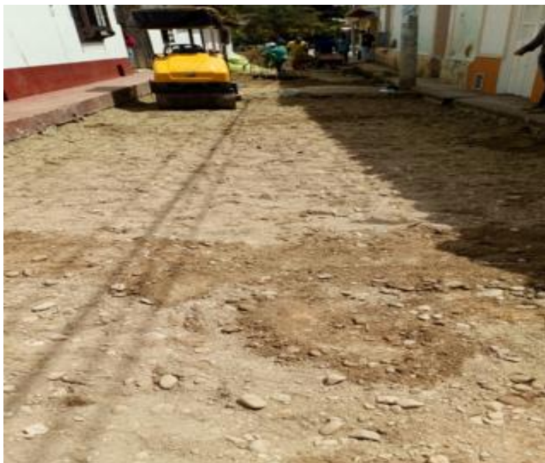
Imagen 20. Riego y compactación sub base granular, Calle Bolívar.
