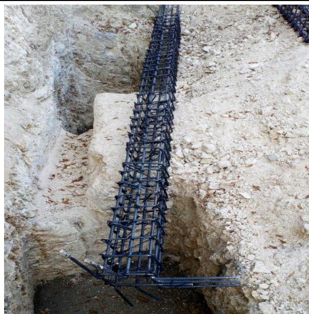
Descripción: acero de refuerzo para columnas de muro en mampostería confinada. Ubicación: Calle El Faro. Fecha: 10/11/2017.
