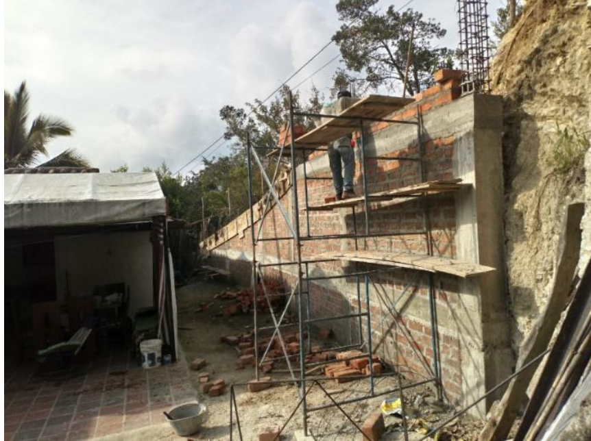
Imagen 18. Zapatas, vigas y columnas en concreto de 3000 psi, Calle EL Faro. Fuente: pasante del proyecto.
