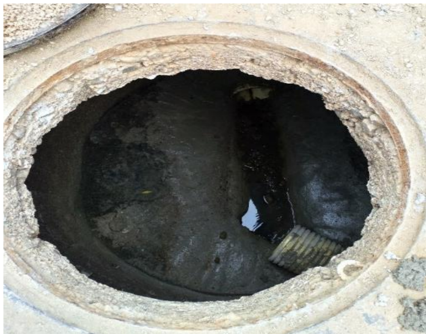
Imagen 7. Construcción de cañuelas, Calle El Faro. Fuente: pasante del proyecto.
