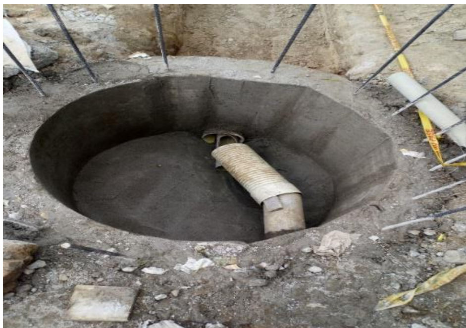
Imagen 6. Construcción de pozo de inspección de 1,50 m de diámetro externo, muros de 0,15 m de altura promedio 1,2m a 1,50m concreto clase II., Calle Jerusalén.
