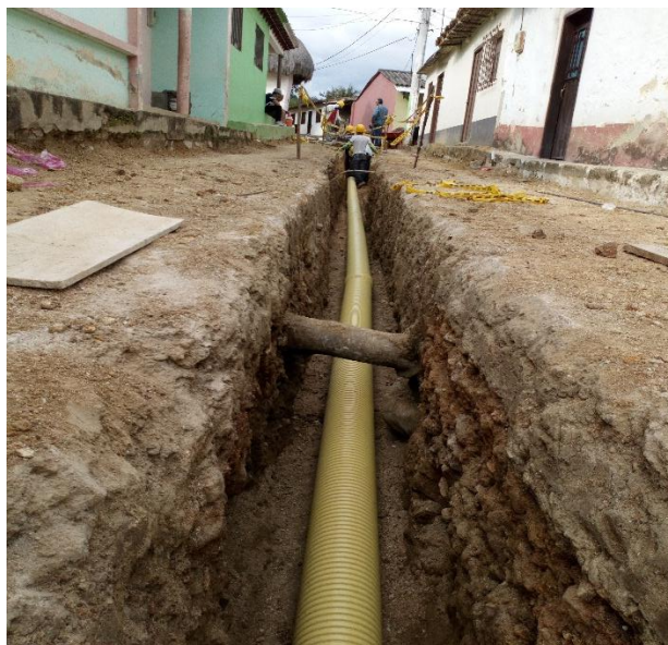
Descripción: instalación de tubo 8" alcantarillado sanitario. Ubicación: Calle Jerusalén. Fecha: 27/10/2017
