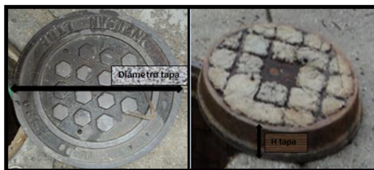
Figura 5. Fotos del Diámetro y Altura de la Tapa de un Pozo de Inspección.
