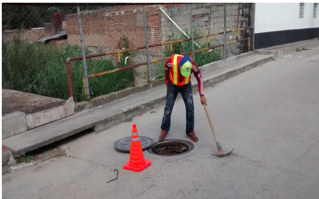
Figura 14. Obrero Especializado en la Inspección del Pozo..
