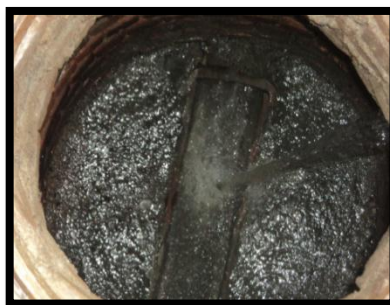
Figura 13. Pozo con un buen Drenaje, una buena Cañuela y Limpio.
