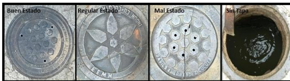
Figura 8. Estado de la Tapa del Pozo.
