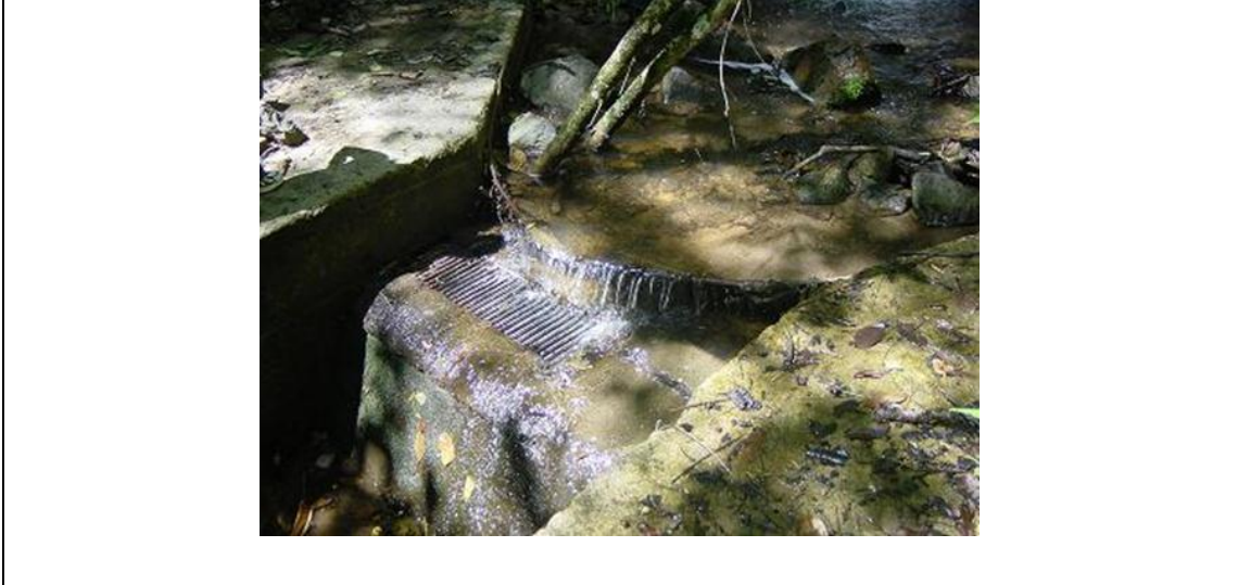
Figura 3 Estado actual de captación, quebrada la Onda.
