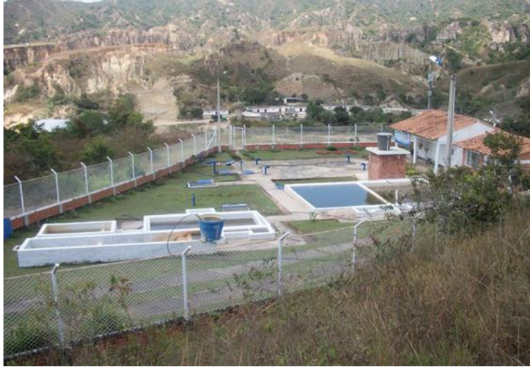
Figura 6 Tanque de almacenamiento, Playa de Belén
