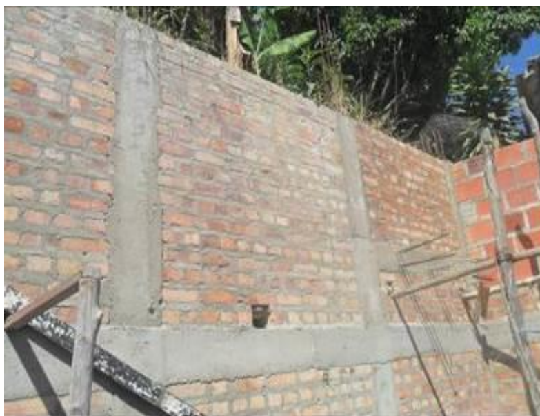
Foto 37. Muro para estabilización talud barrio Promesa de Dios
