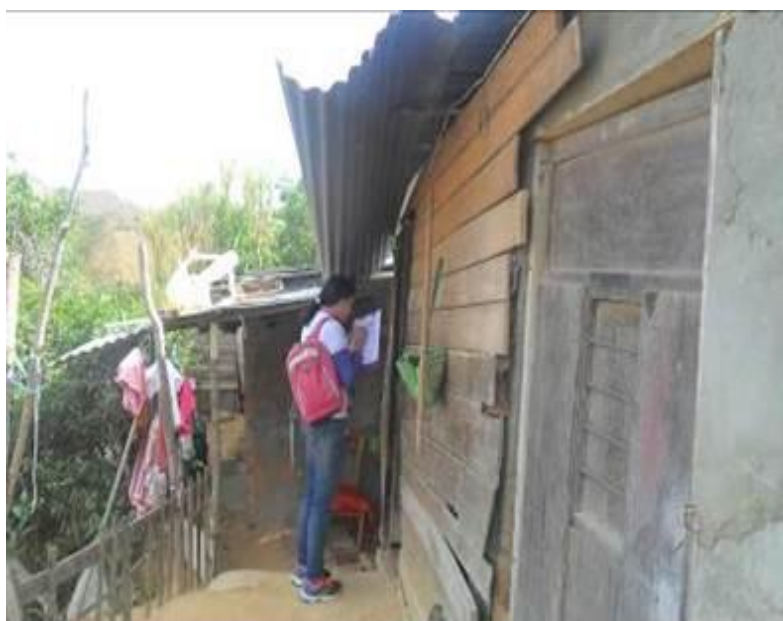
Foto 23. Deslizamiento barrio Colinas de la Provincia
