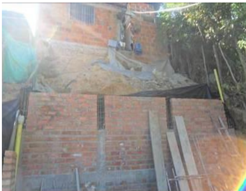
Foto 38. Muro contención para estabilización talud barrio San Fermín
