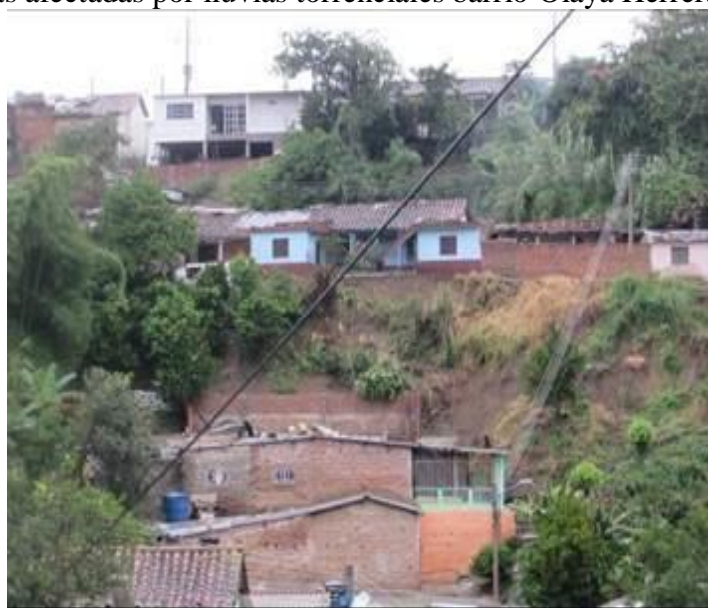
Foto 43. Viviendas afectadas por lluvias torrenciales barrio Olaya Herrera
