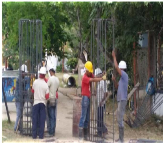
Luego de realizado el figurado de acero se localizan cada uno de los elementos figurados como se ilustra en la siguiente imagen.
