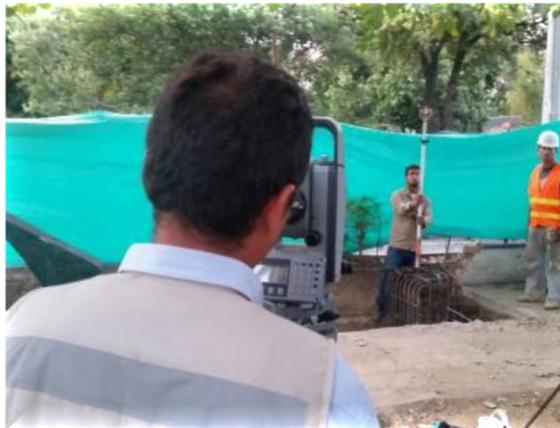
Luego de ubicados los ejes de cimentación se procede a realizar las excavaciones en ambos márgenes de la construcción del puente peatonal como se muestra a continuación.
