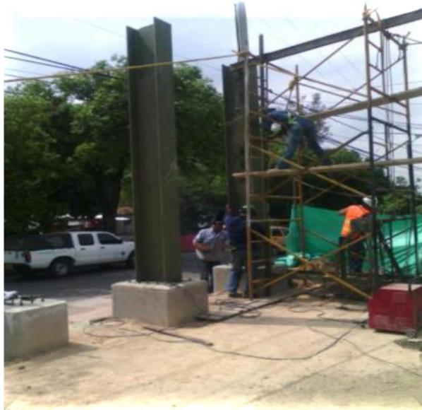
Obteniendose a la fecha el montaje de todos los elemento verticales y realizandose el montaje de la estructura del puente sobre los porticos que se muestrarn en las siguiente imagen.
