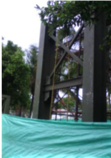
Por último se muestra la estructura principal del puente peatonal y su montaje.
