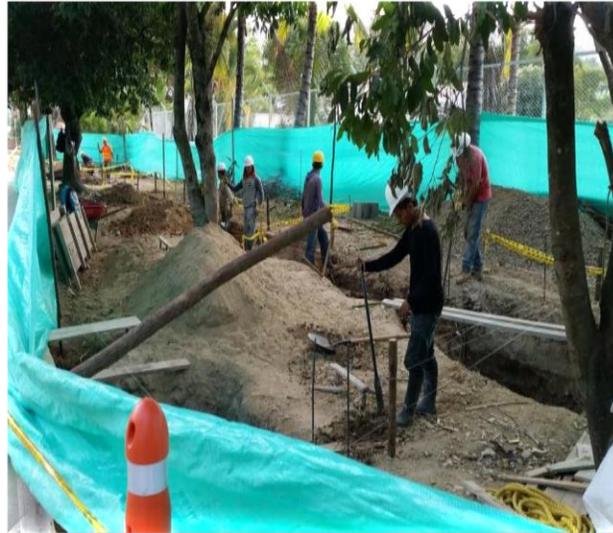
Al igual que las excavaciones el figurado de acero para pedestales se inician al mismo tiempo teniendo estos una altura de 2.8 m y con estribos cada 0.15 m de separación.
