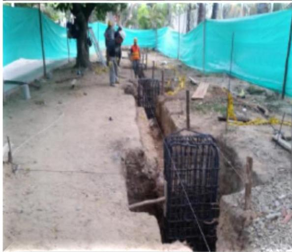
Posteriormente se realiza la fundida de los pedestales, realizando los cilindros para los ensayos de resistencia como se muestra a continuación
