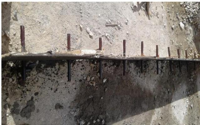
Figura 8. Colocación de pasadores en acero de refuerzo liso 3/4\".
