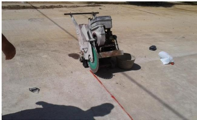
Figura 25. Corte del pavimento  $e=5\text{cm}$ .
