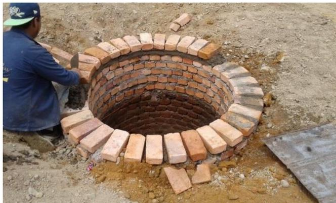
Figura 6. Nivelación pozos de inspección.
