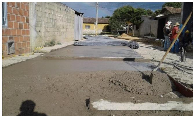
Figura 20. Vaciado del concreto.
