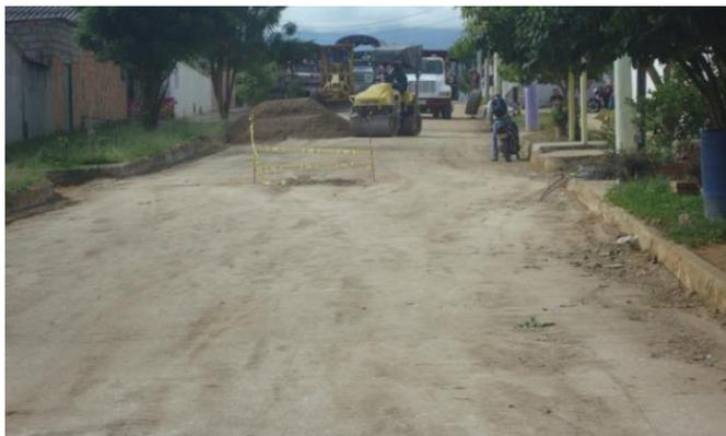
Figura 5. Instalación y suministro de sub- base granular.
