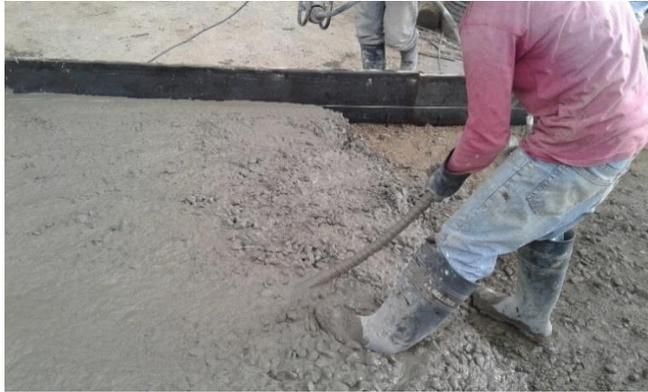
Figura 21. Vibrado del concreto.
