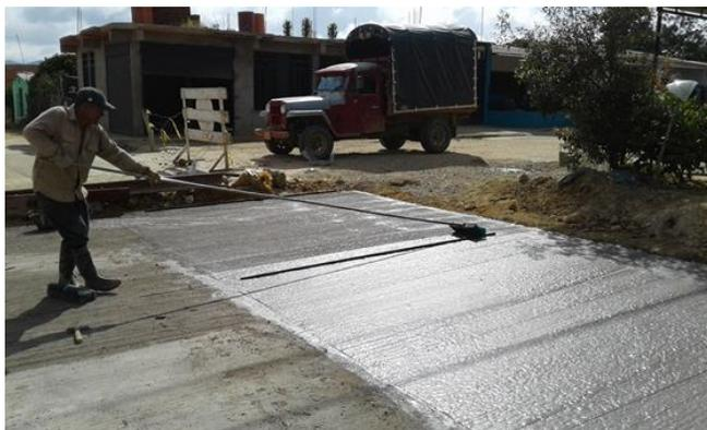
Figura 23. Acabado del concreto.
