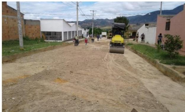
Figura 17. Instalación y suministro de sub- base granular.
