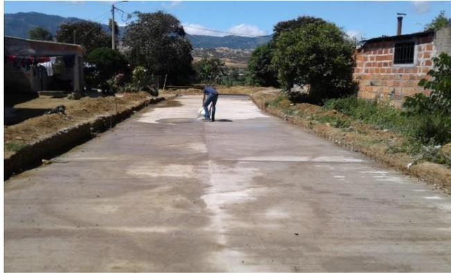
Figura 24. Curado del concreto.
