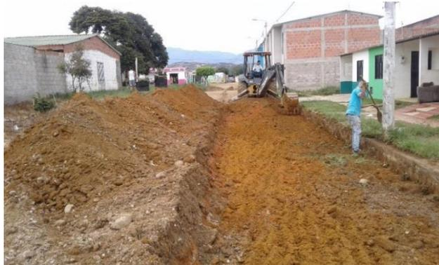
Figura 16. Excavación con maquinaria.
