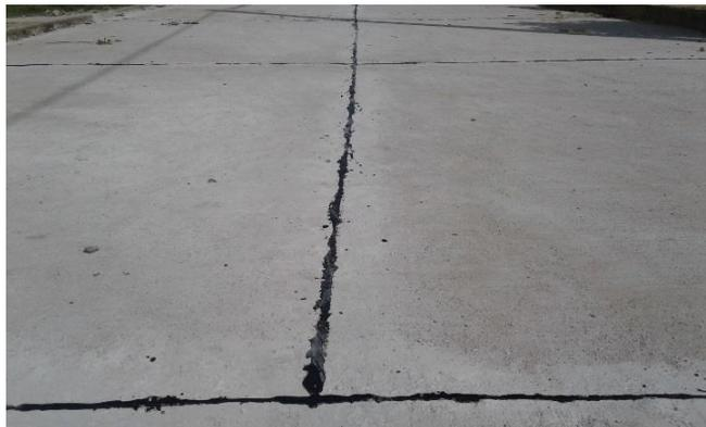
Figura 12. Sello en asfalto juntas de dilatación.
