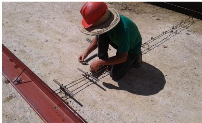
Figura 19. Colocación de pasadores en acero de refuerzo liso 3/4\".
