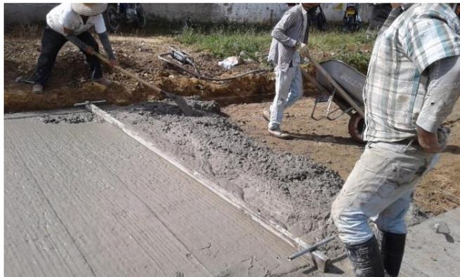
Figura 9. Vaciado del concreto.
