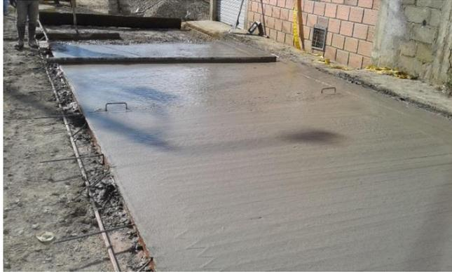
Figura 10. Instalación de barras de unión.
