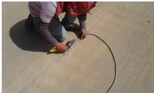
Figura 26. Instalación cordón de espuma en juntas de dilatación.
