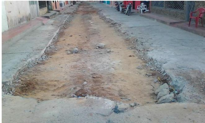
Figura 3. Demolición del pavimento existente.
