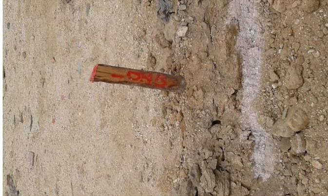
Figura 4. Nivelación por medio de estacas.
