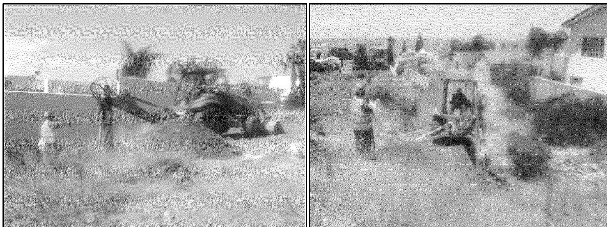
Figura 28. Pozos de Cielo Abierto realizados con máquina retroexcavadora
