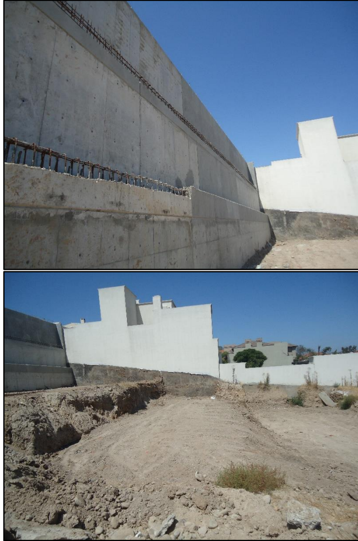
Figura 10. Muro de contención y lotificación
