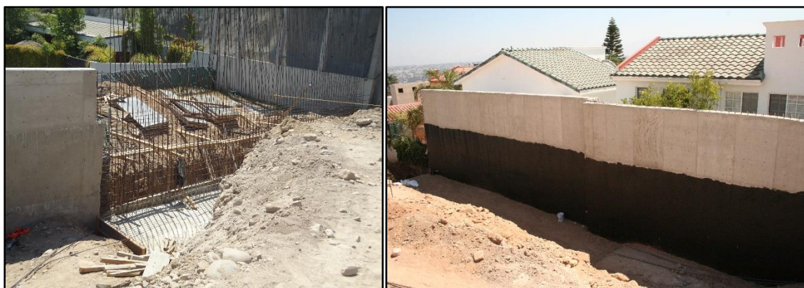
Figura 77. Muro para contención de relleno y evitar empujes a predios vecinos.
