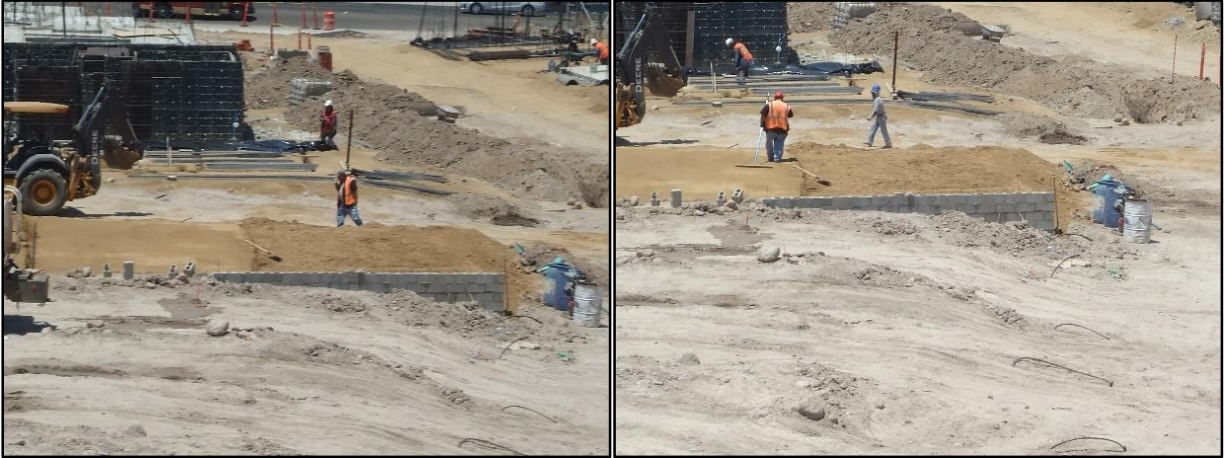
Figura 84. Mejoramiento del terreno con material tucuruquay
