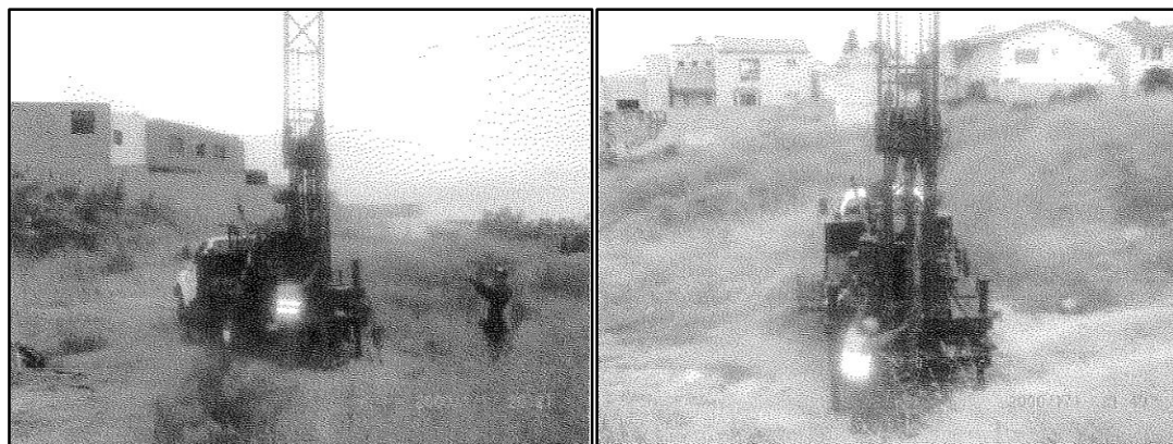
Figura 30. Sondeo con perforadora mecánica "CME55"
