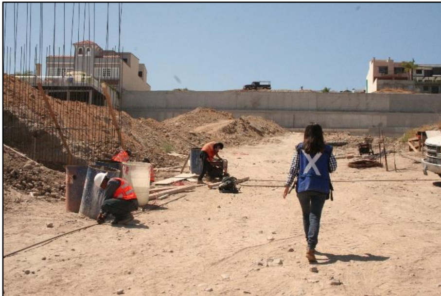
Figura 8. Inspección del predio
