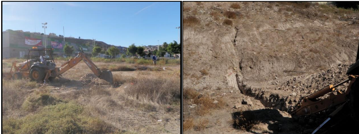
Figura 31. Sondeo del tipo Pozo a Cielo Abierto (PCA) con retroexcavadora.
