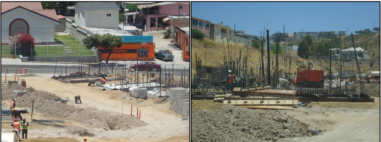
Figura 85. Inicio de trabajos después del mejoramiento del terreno
