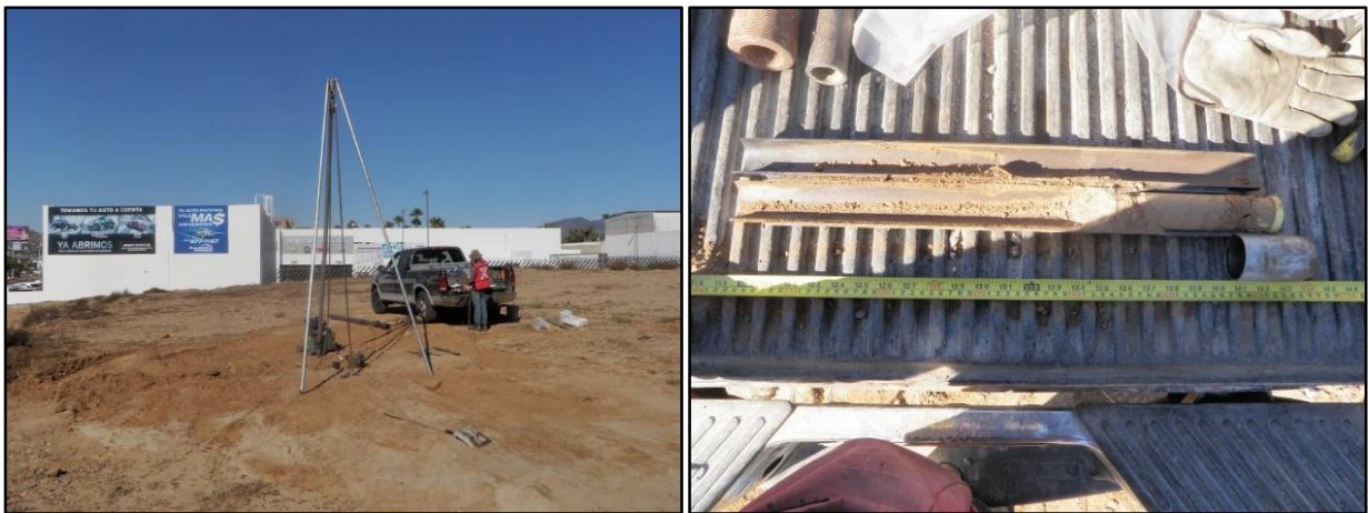
Figura 36. Sondeo 2 con prueba de penetración estándar y su respectiva muestra
