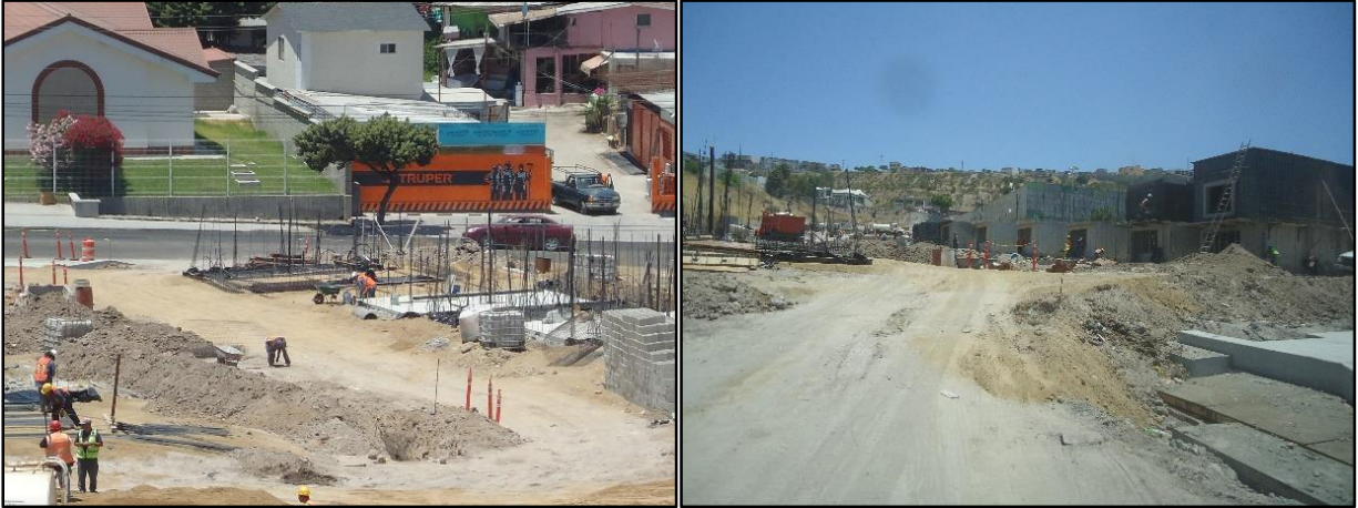
Figura 13. Ejecución de actividades correspondientes a la urbanización
