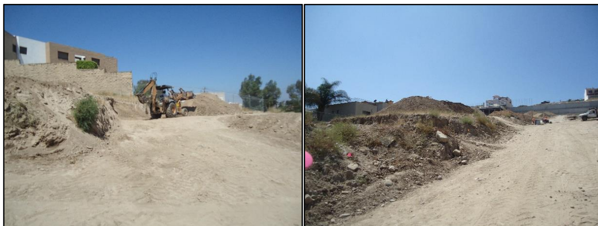
Figura 5. Movimiento de tierra y lotificación del predio.
