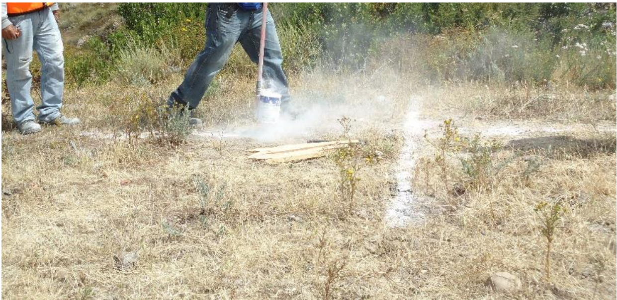
Figura 38. Demarcación de los puntos de control
