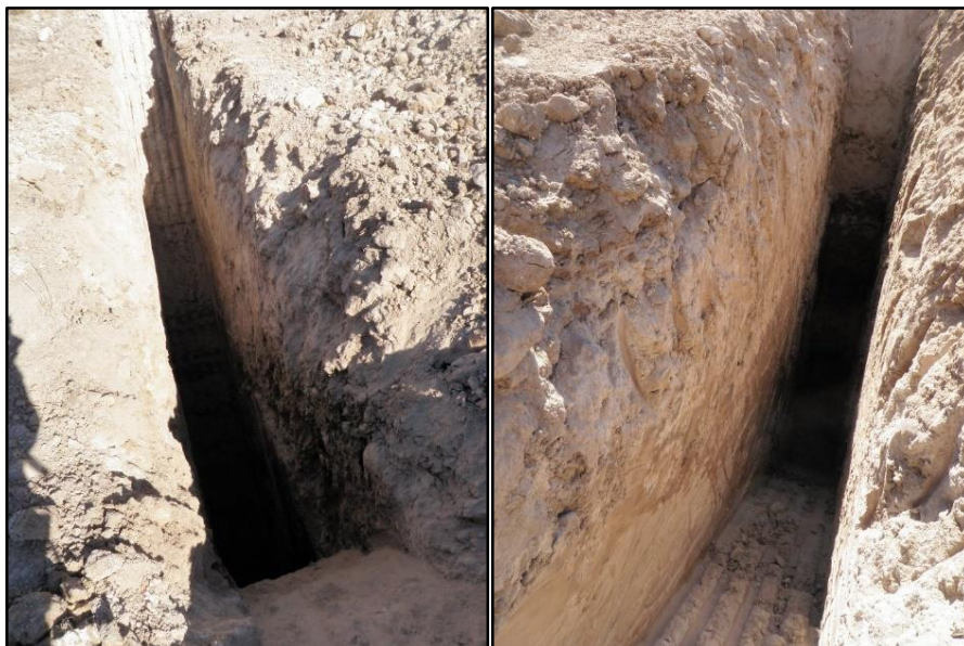
Figura 32. Calicata de 3 metros para obtención de muestras.
