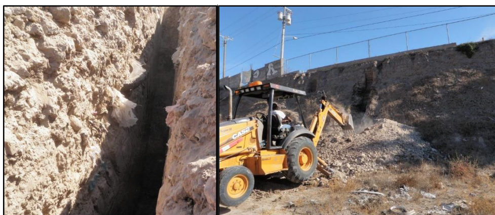
Figura 34. Hallazgo de relleno de basura y exploración en el talud.
