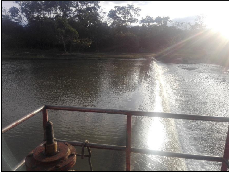
Figura 18. Presa bocatoma Rio Oroque. Fuente: Autores del proyecto.
