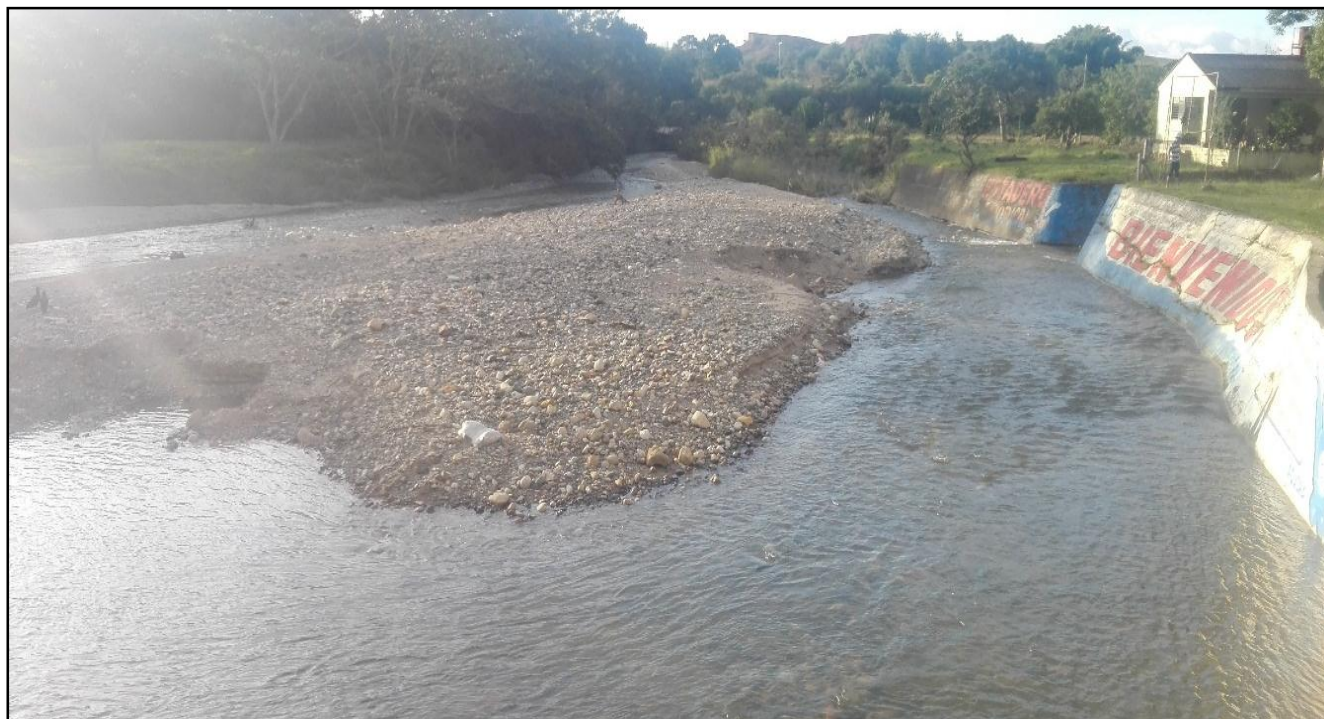
Figura 6. Material de arrastre del afluente Rio Oroque pasos después de la presa. Fuente: Autores del proyecto.
