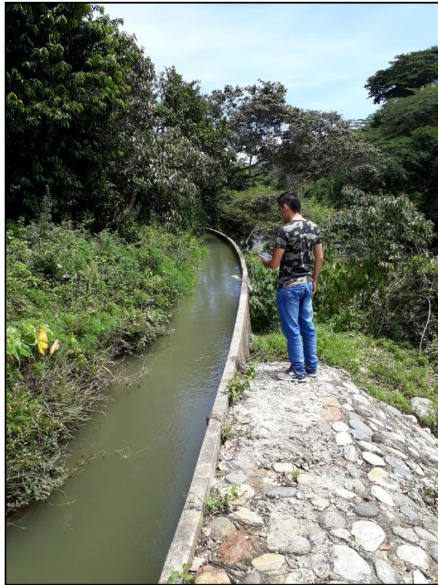
Figura 28. Canal principal que parte de la bocatoma Rio Frio. Fuente: Autores del proyecto.
