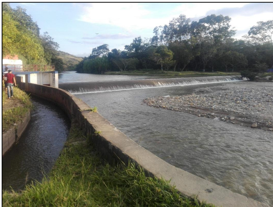
Figura 17. Condición actual Bocatoma Rio Oroque. Fuente: Autores del proyecto.
