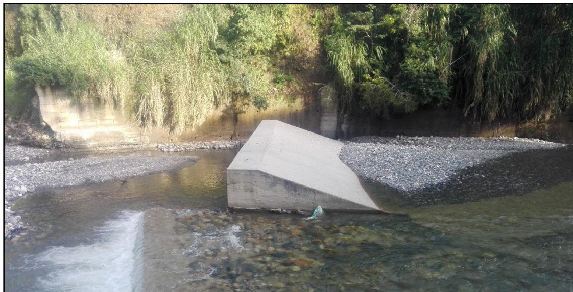
Figura 10. Disipador de energía del flujo bocatoma Rio Frio. Fuente: Autores del proyecto.
