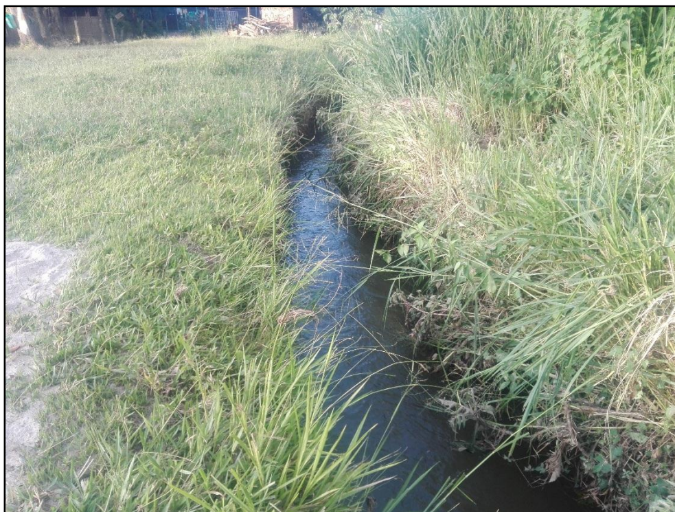
Figura 34. Canales con obstrucción por vegetación. Fuente: Autores del proyecto.
