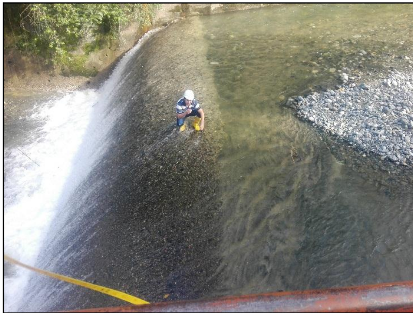
Figura 11. Presa bocatoma Rio Frio. Fuente: Autores del proyecto.
