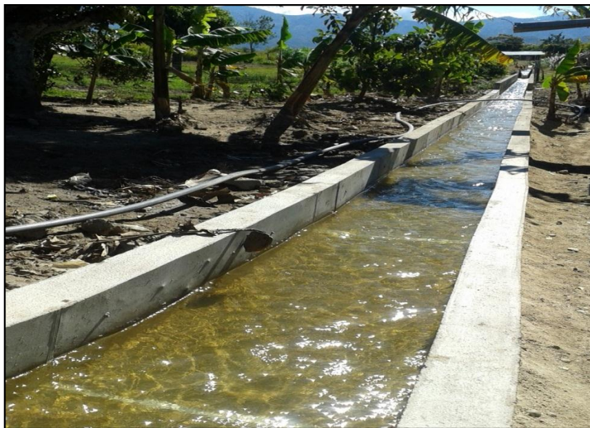
Figura 30. Sección tipo de los canales secundarios de la bocatoma Rio Frio. Fuente: Autores del proyecto.
