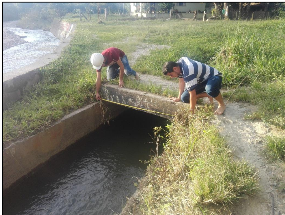
Figura 33. Canal principal Bocatoma Rio Oroque. Fuente: Autores del proyecto.
