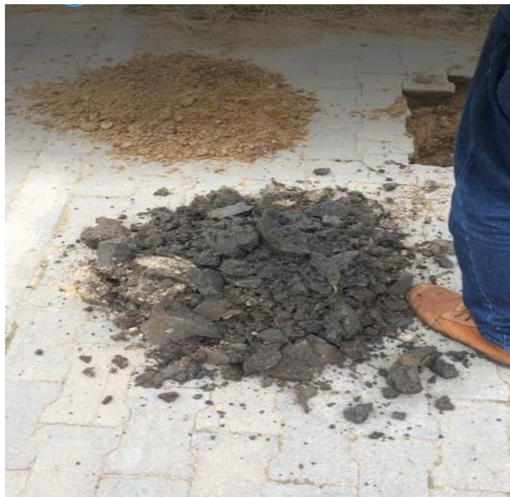
Fotografía 22. Extracción del material de subrasante (después de los primeros 0.60 mts) provenientes de la excavación.
