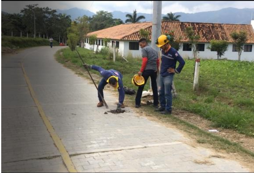
Fotografía 18. Ubicación de la ejecución del ensayo de CBR.
