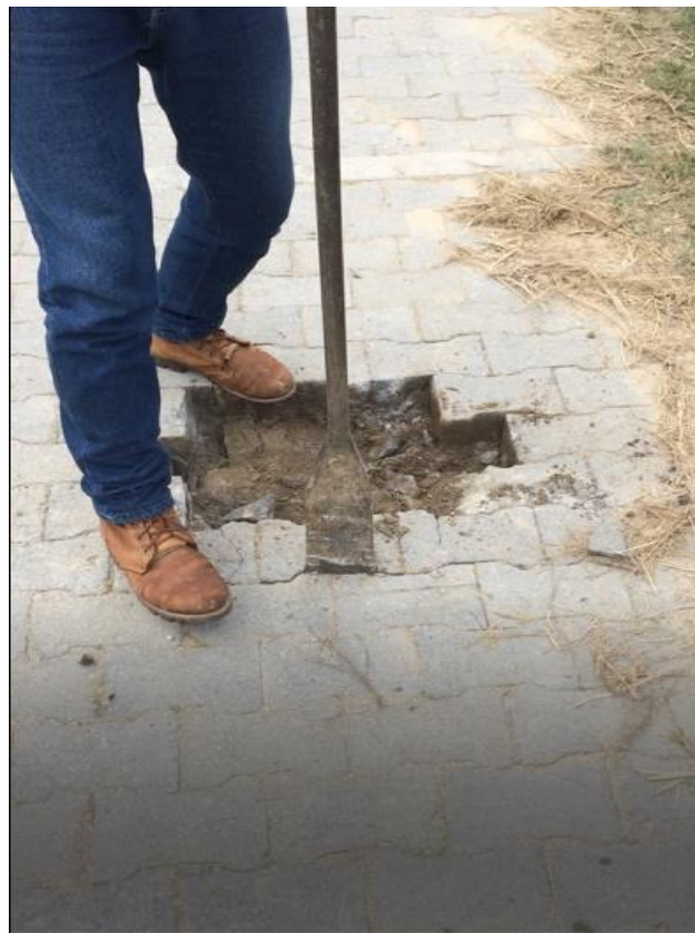
Fotografía 19. Levantamiento del adoquín en el tramo de pavimento articulado existente.
