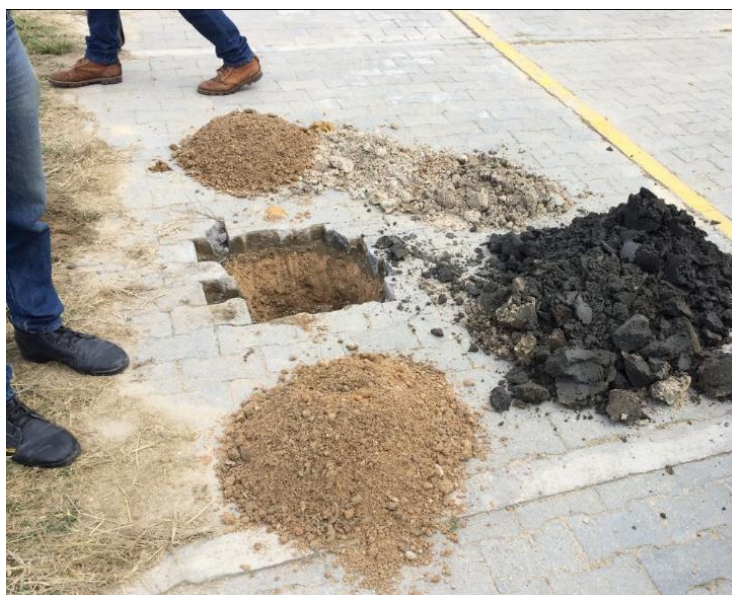
Fotografía 23. Diversos tipos de materiales por los cuales está compuesto el tramo del suelo de la vía que comunica los Anexos con la Granja de la UFPSO.
