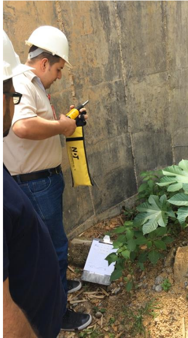
Fotografía 1. Calibración del esclerómetro previo al inicio del ensayo.
