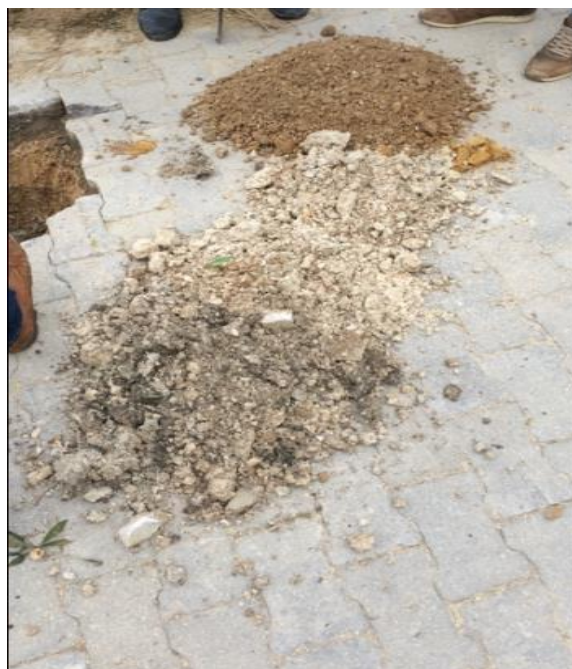
Fotografía 21. Extracción del material superficial (primeros 0.60 mts) provenientes de la excavación.
