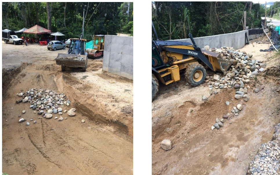
Fotografía 14. Sobre excavación para relleno en la parte frontal del muro de contención redoma derecha.
