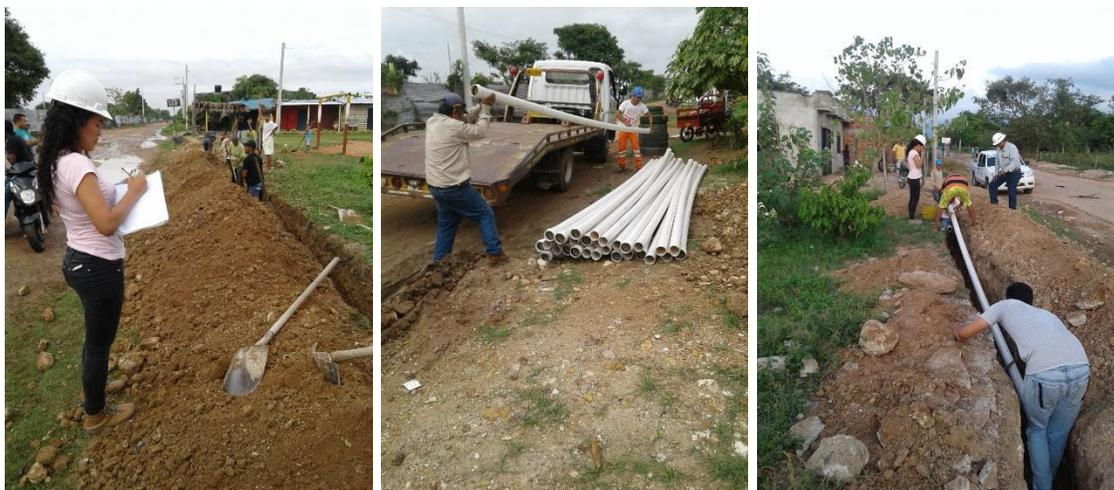
Fotografía 66. Excavaciones, suministro de tubería de 3" AC e instalación de tubería.
