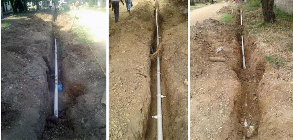
Fotografía 1. Instalación de tubería.
