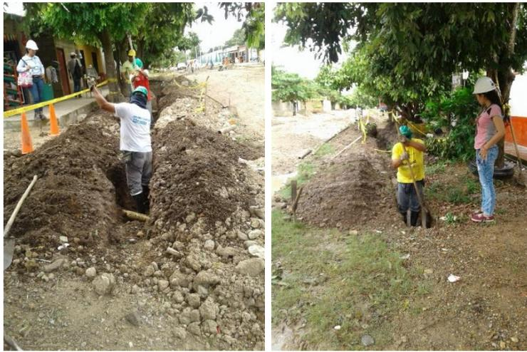
Fotografía 48. Excavación de zanja para instalación.
