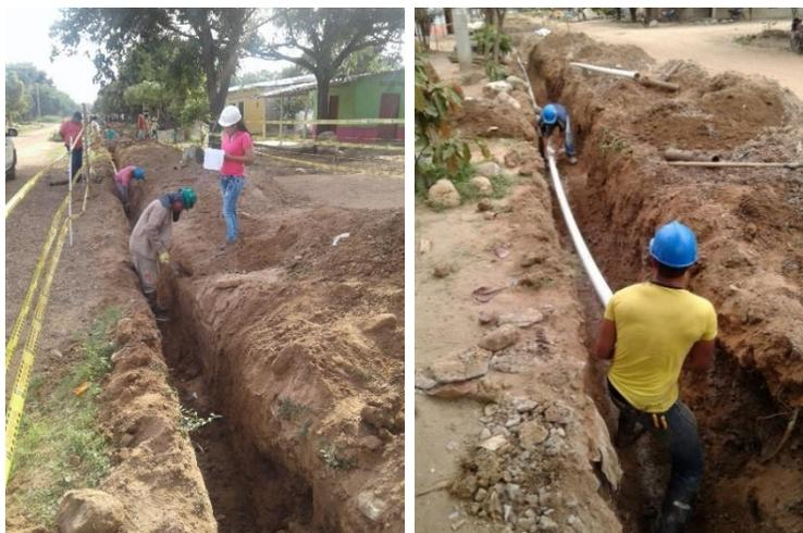
Fotografía 54. Nivelación e instalación de tubería PVC.
