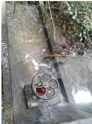
Fotografía 7. Compuerta para evacuar los sedimentos del canal de aducción.
