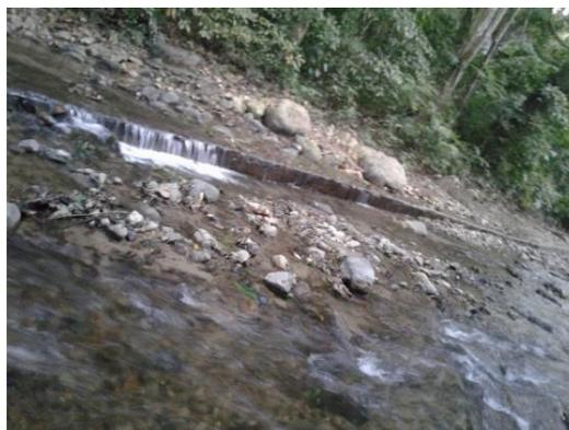
Fotografía 10. Aducción revestida en concreto.
