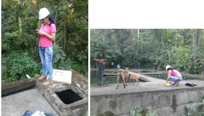
Fotografía 3. Toma de coordenadas y medidas en el desarenador 1.
