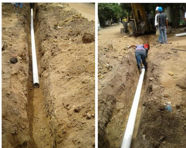
Fotografía 58. Instalación de tubería de 6" PVC.
