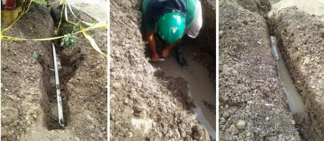
Fotografía 50. Instalación de tuberías y acometidas domiciliarias.
