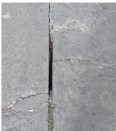
Figura 22. Remoción de material en la Junta por Bombeo. Sector del Tamaco. Fuente: autor del proyecto.
