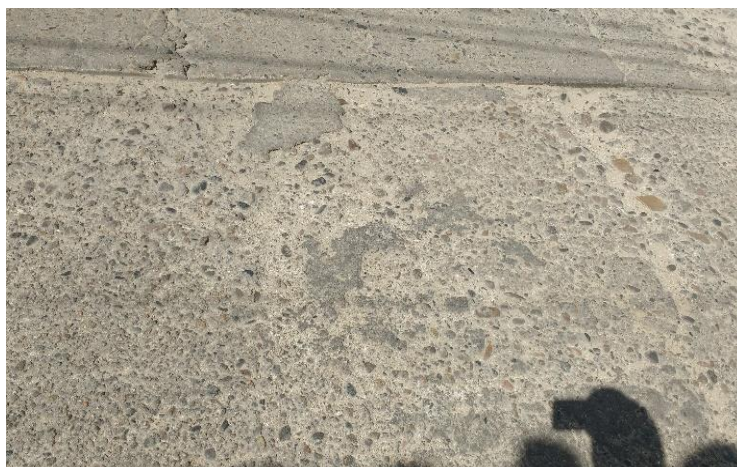
Figura 26. Desintegración de material. Sector de San Agustín - La Luz. Fuente: autor del proyecto
