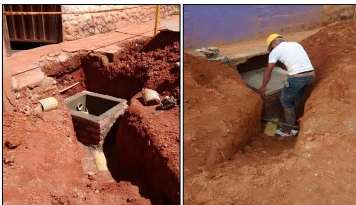
**Figura 17. Caja de conexión domiciliaria 0,6x0,6x0,6 mts.**
