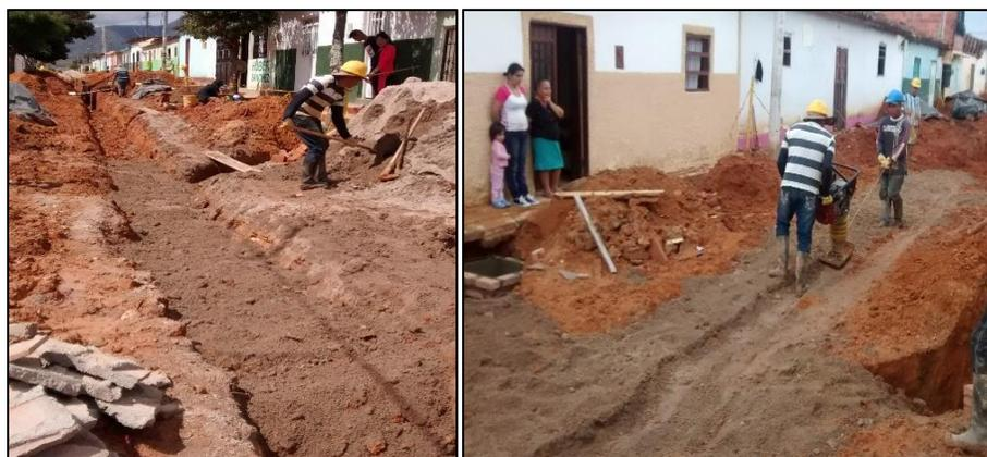
**Figura 11. Relleno compactado con material seleccionado.**
