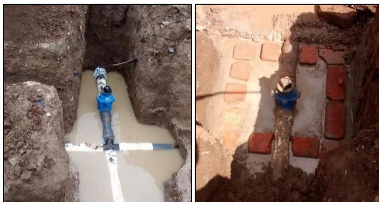
**Figura 38. Suministro e instalación de válvula de 3".**
