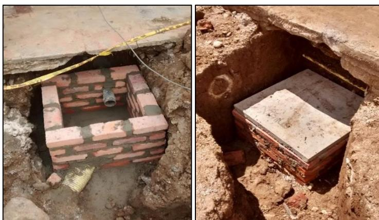
**Figura 35. Caja de conexión domiciliaria 0,6x0,6x0,6 mts.**
