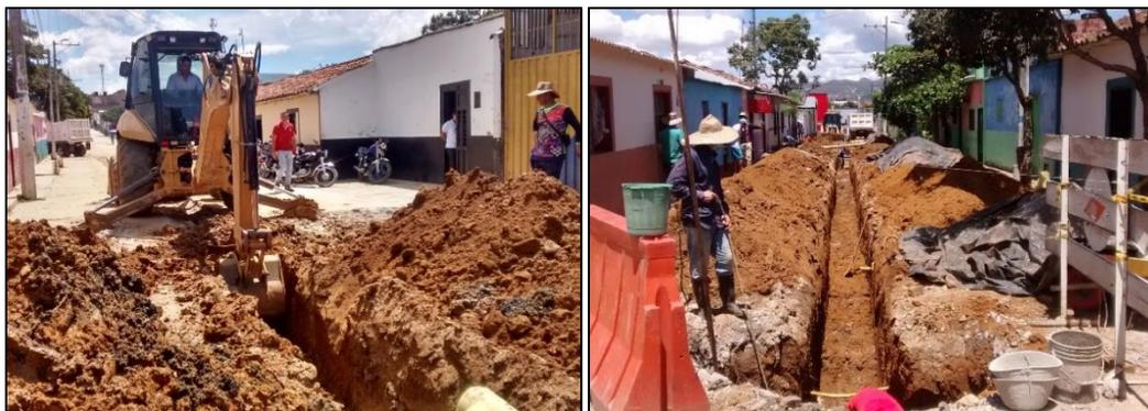
**Figura 24. Excavación mecánica en material.**
