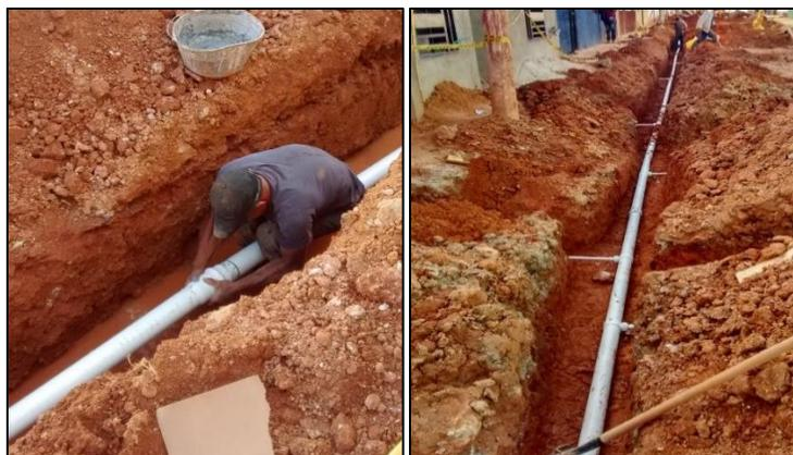
**Figura 15. Suministro e instalación de tubería de agua potable tipo PVC 3" RDE 21.**
