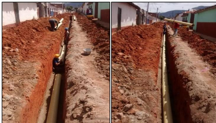
**Figura 12. PVC alcantarillado Novafort d=10".**
