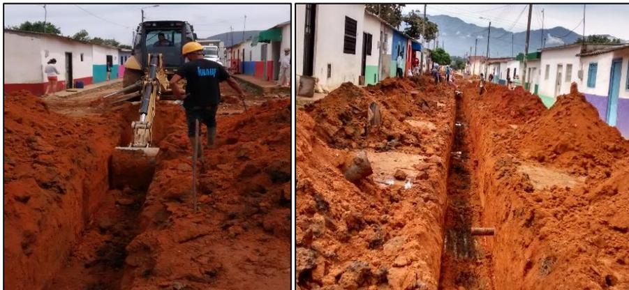
**Figura 6. Excavación mecánica en material sin clasificar.**
