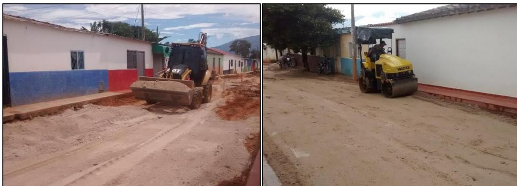
**Figura 19. Instalación y suministro de recebo compactado.**
