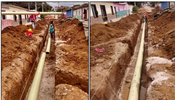
**Figura 30. PVC alcantarillado Novafort d=10".**
