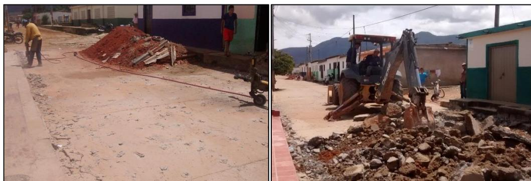
**Figura 5. Demolición de pavimento rígido.**
