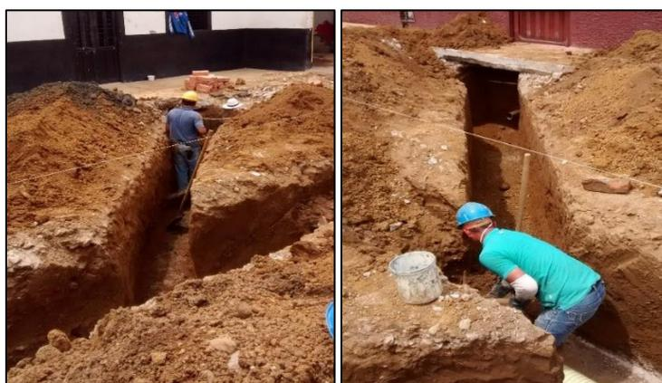
**Figura 25. Excavación manual.**
