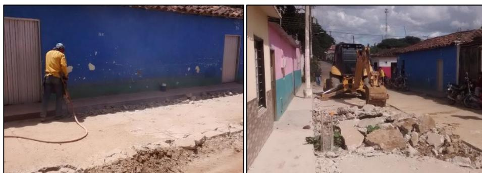
**Figura 22. Demolición manual de pavimento rígido.**
