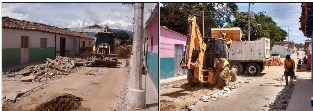
**Figura 26. Retiro de escombros y material sobrante de excavación.**
