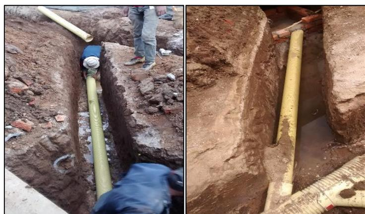
**Figura 32. PVC alcantarillado Novafort d=6" acometidas.**
