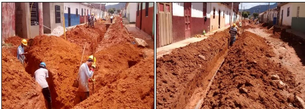
**Figura 7. Excavación manual.**
