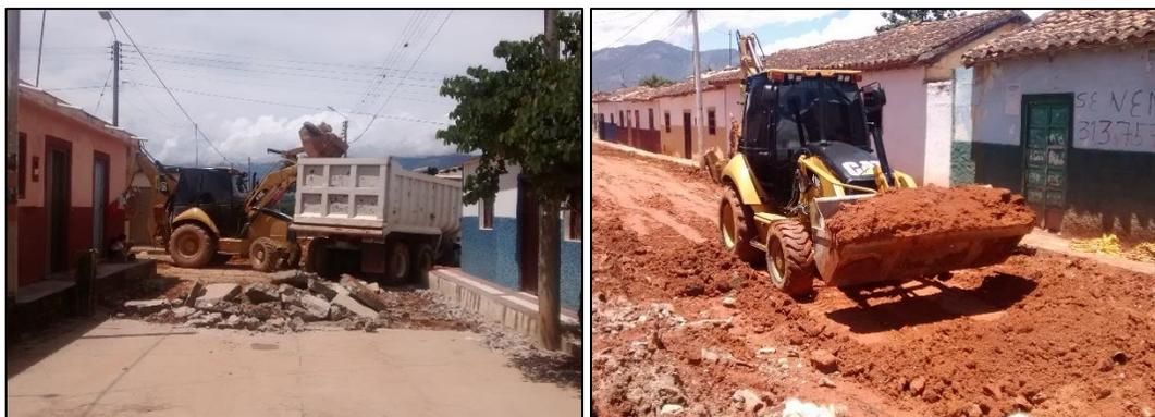
**Figura 8. Retiro de escombros y material de excavación.**
