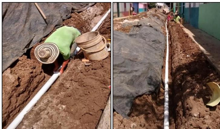
**Figura 33. Suministro e instalación de tubería agua potable tipo PVC 3" RDE 21.**
