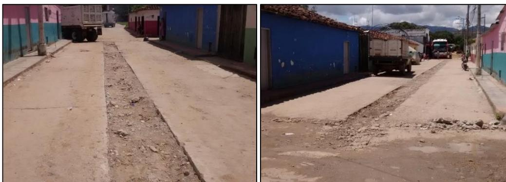
**Figura 23. Corte de pavimento existente  $e= 6,5$  cm.**
