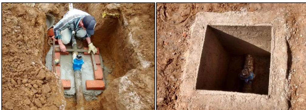
**Figura 20. Suministro e instalación de válvula 3".**
