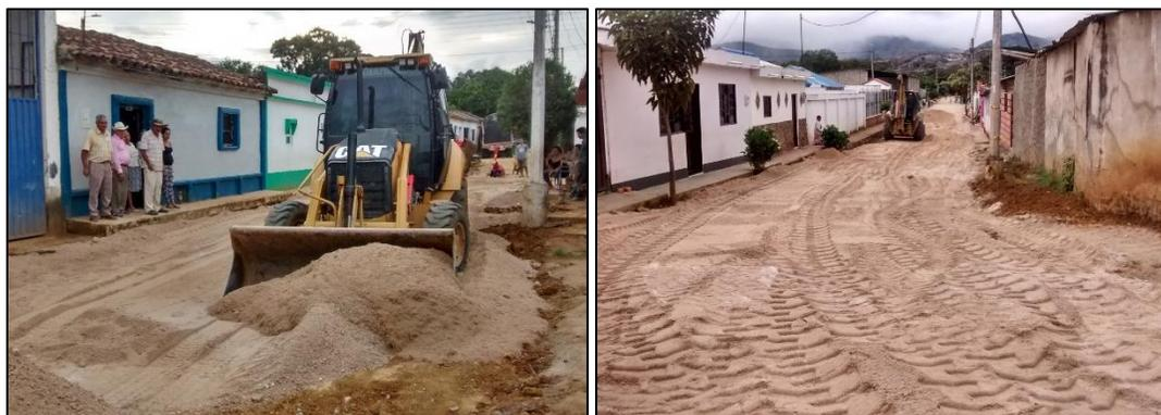
**Figura 37. Instalación y suministro de recebo compactado.**
