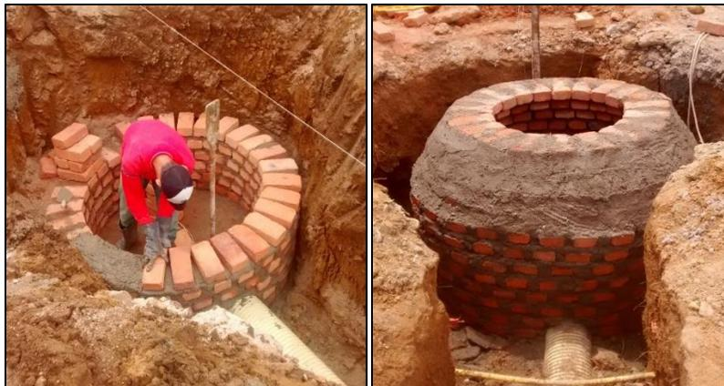
**Figura 36. Pozo de inspección  $h < 1,4\text{m}$  y  $h > 1,4\text{m}$ .**
