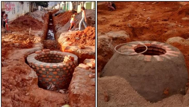
**Figura 18. Pozos de inspección  $h < 1,4\text{m}$  y  $h > 1,4\text{m}$ .**
