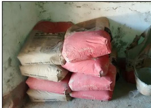
**Figura 44. Cemento Cemex Tipo 1.**
