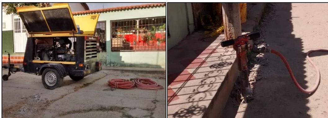
**Figura 51. Compresor de aire dos martillos.**
