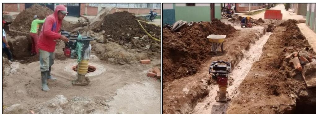
**Figura 29. Relleno compactado con material seleccionado.**
