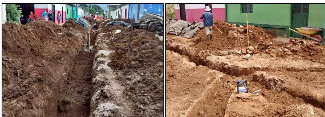
**Figura 28. Relleno compactado con material de excavación.**
