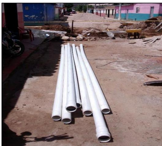
**Figura 41. Tubería PVC 3" RDE 21.**
