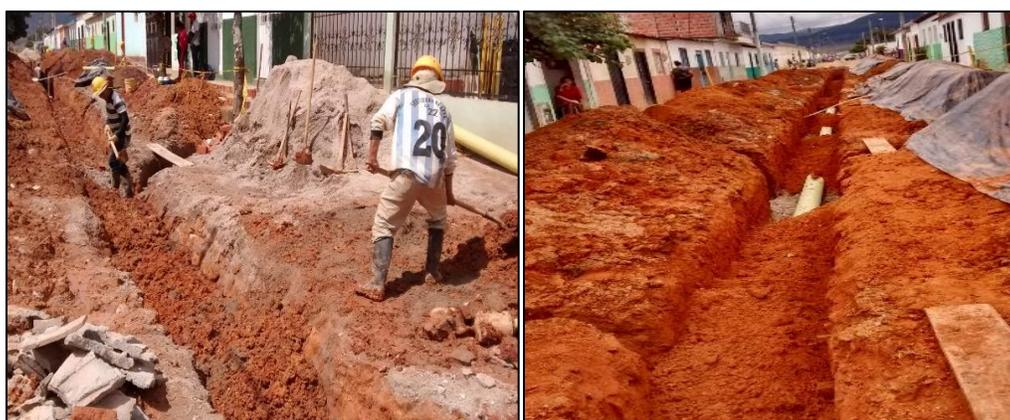
**Figura 10. Relleno compactado con material de excavación.**
