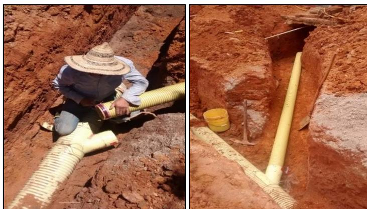
**Figura 14. PVC alcantarillado Novafort d=6" acometidas.**
