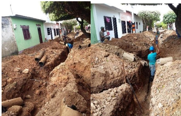
Extracción de tubería AC
