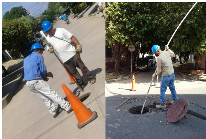
Figura 5. Inspección y mantenimiento de pozos
