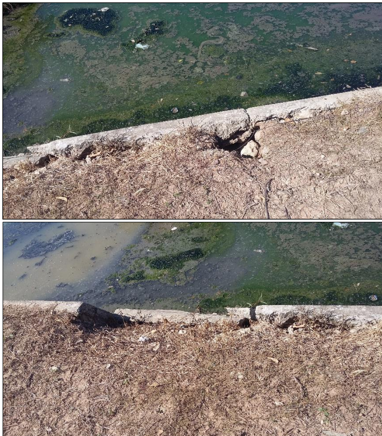
Figura 14. Recubrimiento de paredes de lagunas
