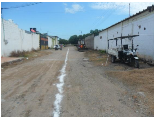
Marcación del eje de excavación
