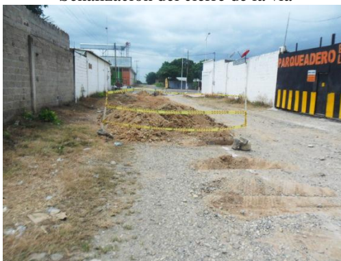
Señalización perimetral de la zona de trabajo
