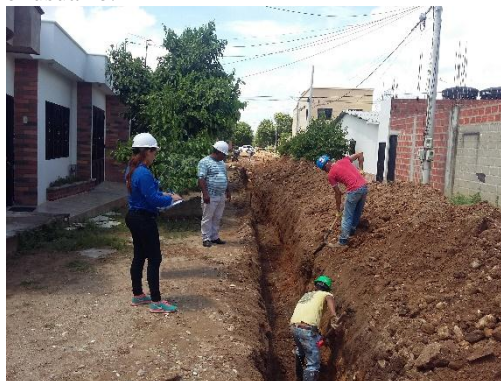
Nivelacion del terreno
