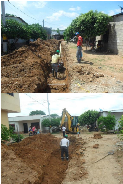
Compactación del terreno
