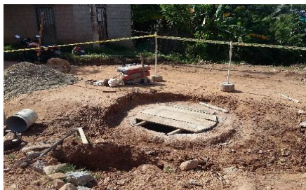
Figura 40. Reparación de tapa en la Cra 35 CII 14N Fuente: (Pasante, 2017)
