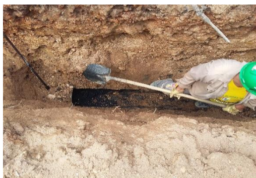
Tramo de tubería existente
