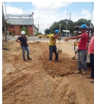
Compactación manual del terreno
