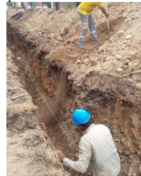
Nivelación del fondo de excavación
