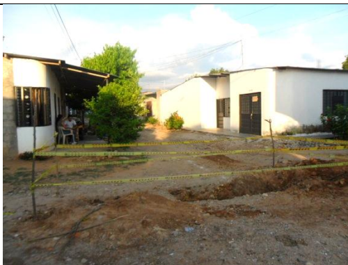
Señalización del sitio de trabajo, en tramos pendientes.
