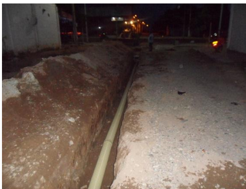
Instalación del primer tramo
