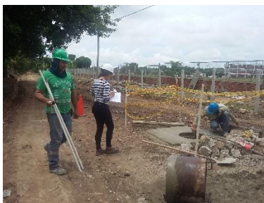
Figura 42. Reparación de tapa #2 Vía Antropolis Fuente: (Pasante, 2017)
