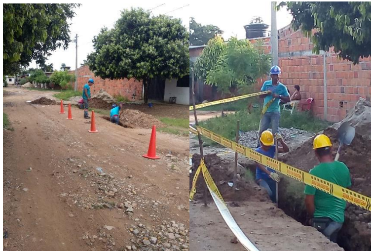
Señalización de la zona de trabajo
