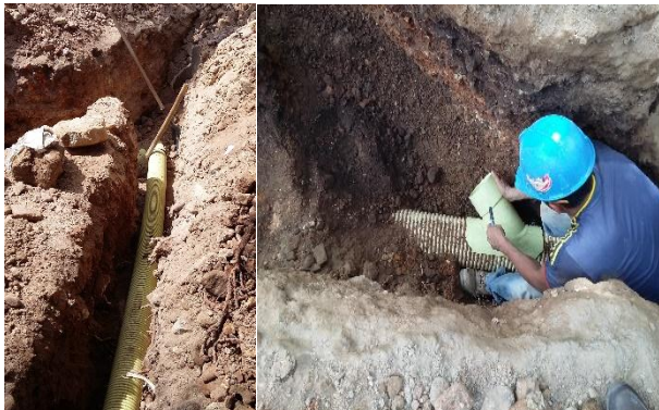
Instalación de tubería y silla Yee
