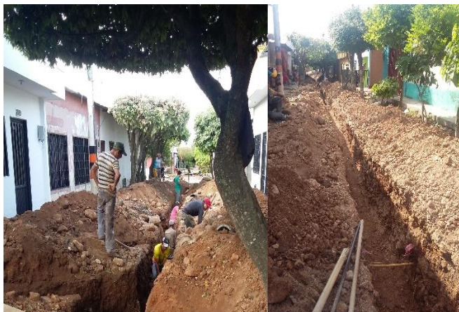
Proceso de excavación
