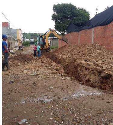
Excavación del terreno
