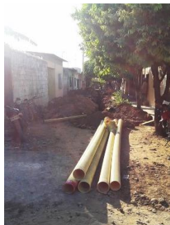
Tubería puesta en obra
