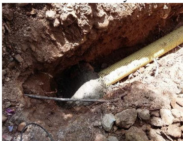
Ensamble de tubería
