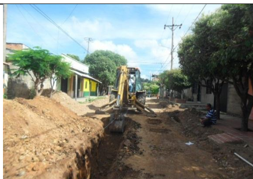
Excavación del eje de la tubería
