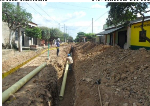
Instalación de tubería principal
