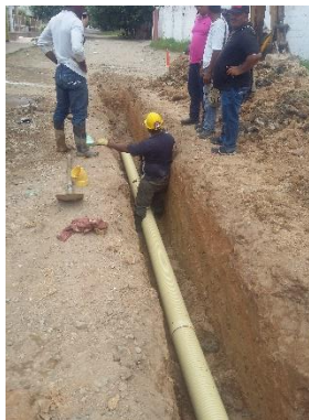
Instalación del segundo tramo
