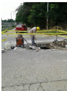
Figura 46. Reparación de tapa en la CII 3 con Cra 27
