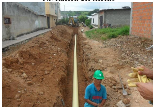
Instalación de red principal
