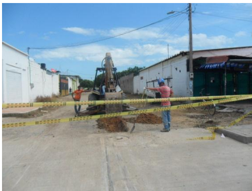
Señalización del cierre de la vía
