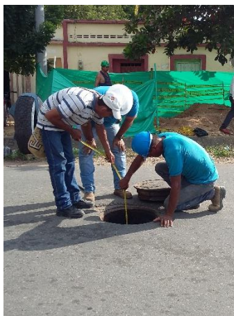
Figura 6. Medición de la profundidad de la cámara de inspección
