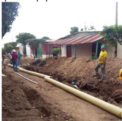
Verificación de estado de la tubería
