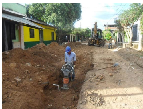
Compactación del terreno
