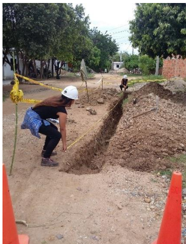
Medición de la zanja
