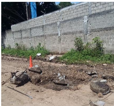
Figura 43. Reparación de tapa #3 Vía Antropolis
