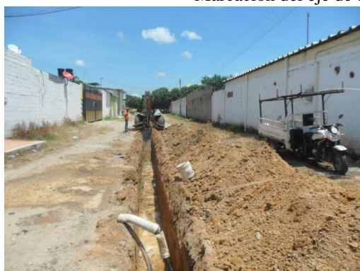
Excavación primer tramo
