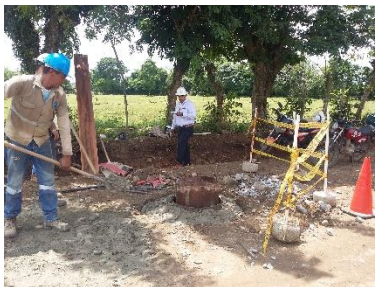
Figura 41. Reparación de tapa #1 Vía Antropolis Fuente: (Pasante, 2017)
