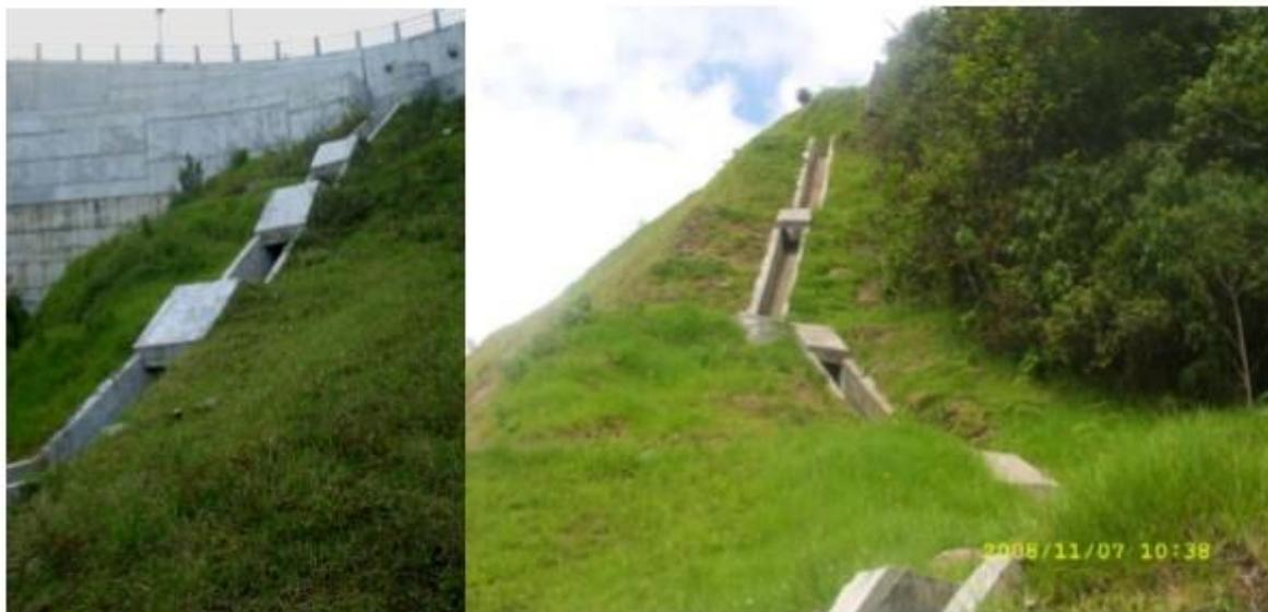
**Figura 12.** Canal de rápidas con tapa y columpio
