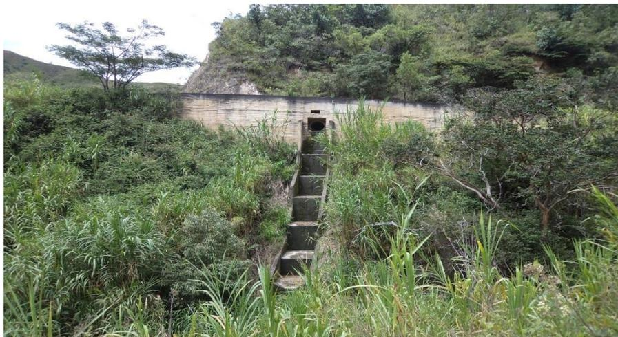
**Figura 10.** Disipador de Energía escalonado
