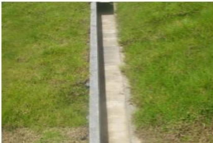
**Figura 8.** Rápida con fondo liso
