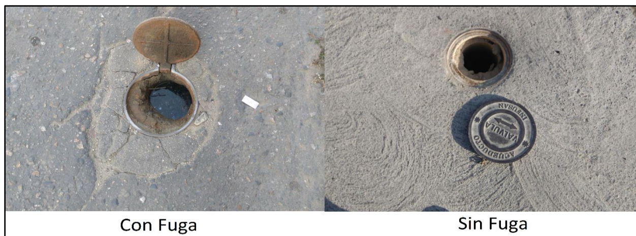
Figura 54. Esquema de fuga en la válvula.
