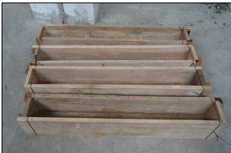
Figura 31. Encoframiento empleado para las vigas de ensayo. Fuente: Autores del proyecto.
