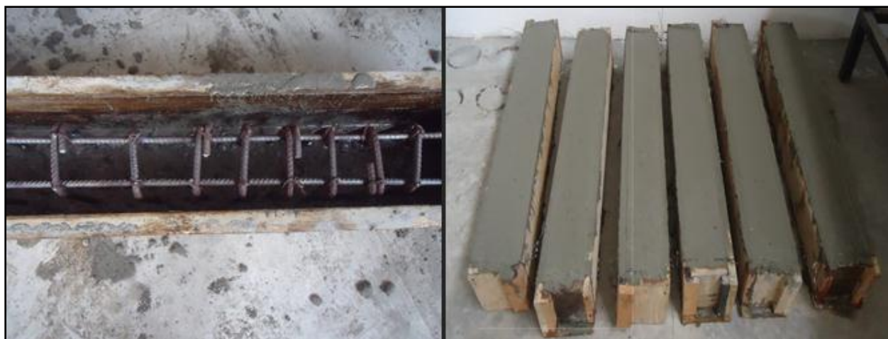
Figura 33. Elaboración de viga de concreto reforzada. Fuente: Autores del proyecto.
