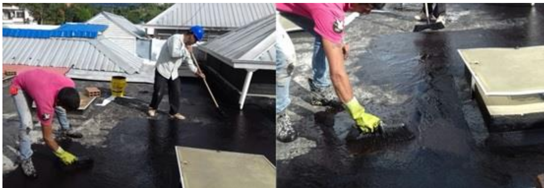
Figura 51. Impermeabilización con alumol sika en placas
