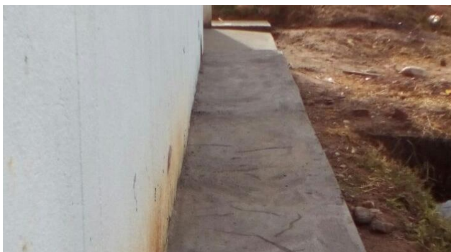
Figura 38. Fraguado de anden perimetral
