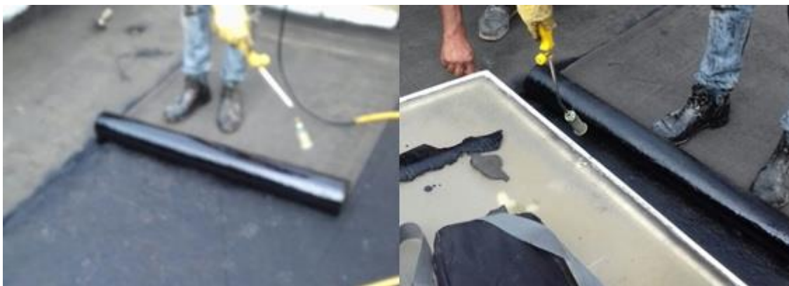
Figura 58. Impermeabilización con manto asfáltico
