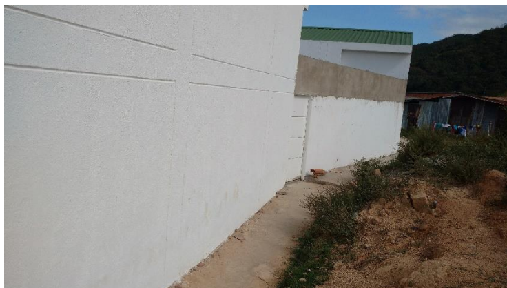
Figura 67. Prolongación de muro exterior
