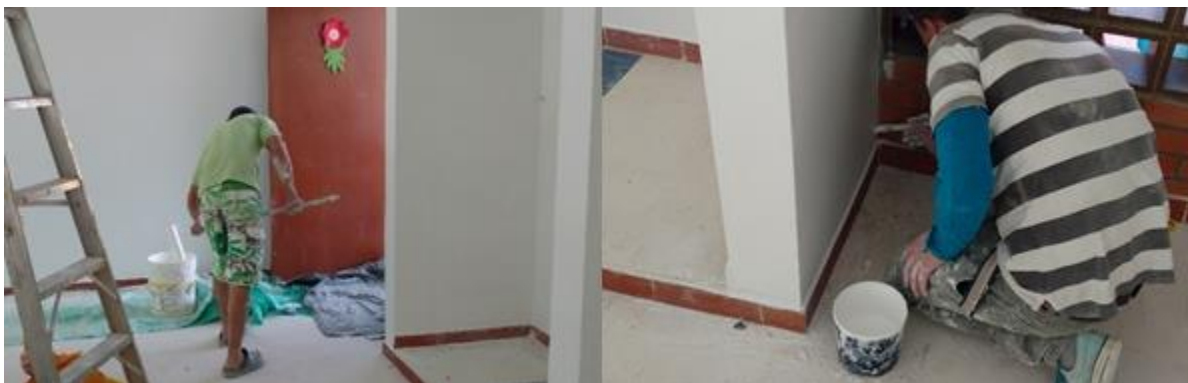
Figura 65. Pintura interior en vinilo tipo 1
