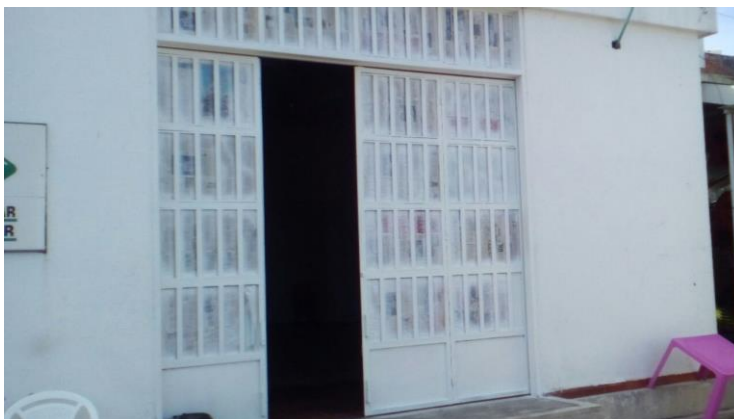
Figura 50. Carpintería metálica en portón
