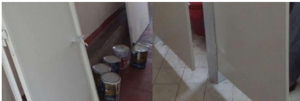
Figura 43. Pintura y recuperación de carpintería metálica
