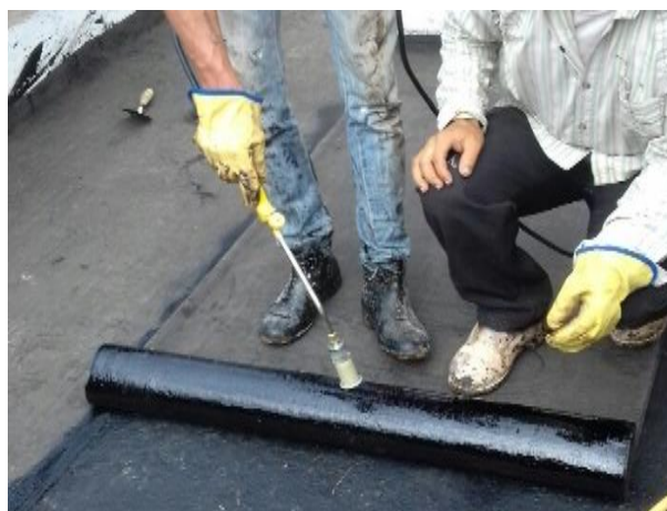
Figura 62. Instalación de manto asfáltico de 4mm
