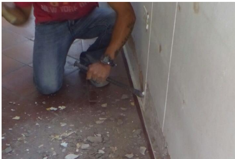
Figura 37. Demolición de pañete
