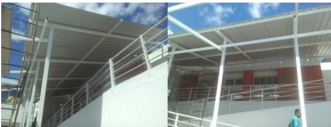
Figura 68. Instalación de cubierta en teja master 1000
