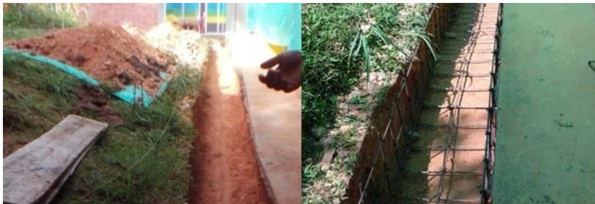
Figura 42. Excavación para canal, armado y figurado de acero
