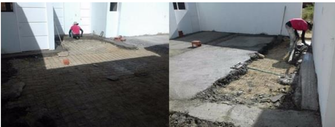
Figura 64. Instalación de malla electrosoldada y fundida de piso
