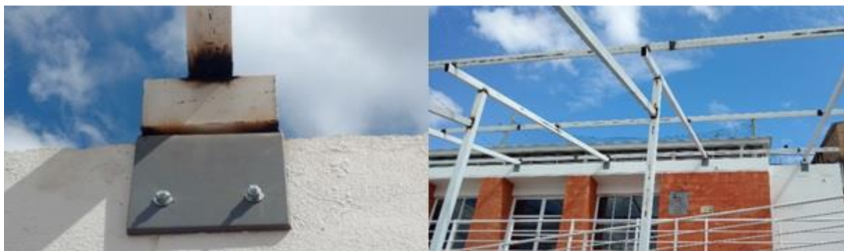
Figura 66. Instalación de estructura de soporte para cubierta
