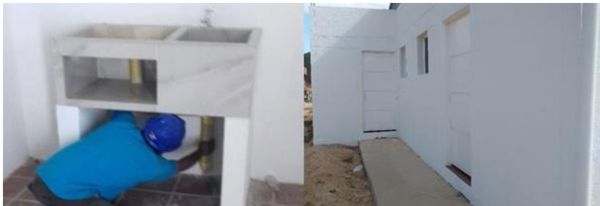
Figura 45. Instalación de lavadero y pintura exterior
