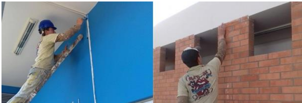
Figura 61. Pintura koraza administración y baños
