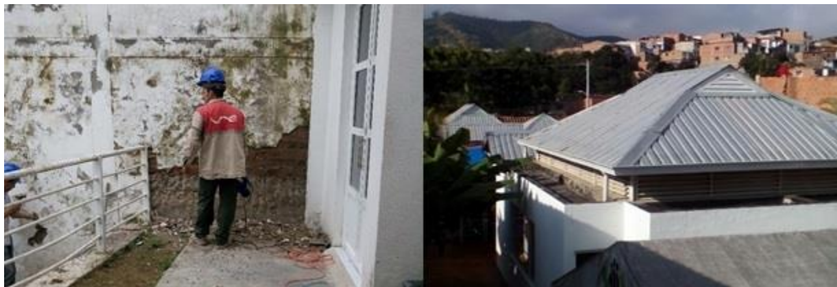
Figura 40. Demolición de pañete y limpieza de cubierta
