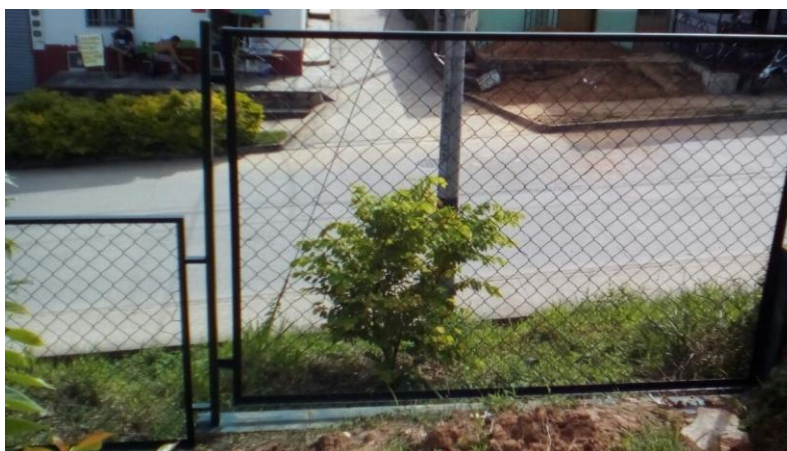
Figura 39. Pintura de carpintería metálica
