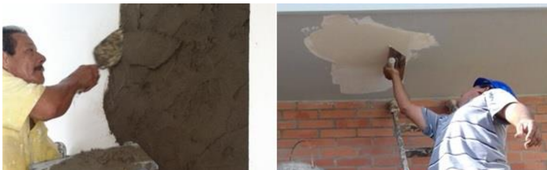
Figura 53. Pañete impermeabilizado y resanes sobre placa
