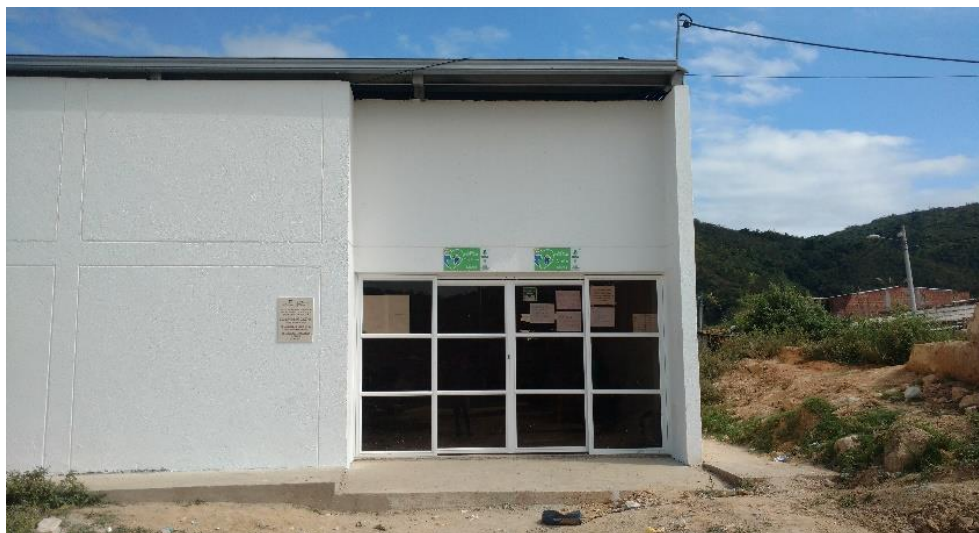
Figura 60. Acabado frontal en pintura koraza
