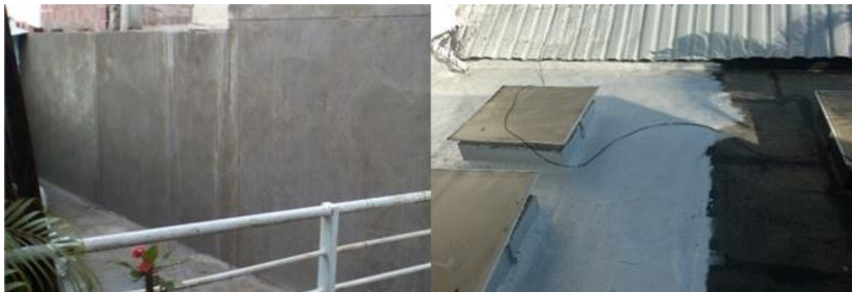
Figura 48. Limpieza de muro e impermeabilización sobre placa plana
