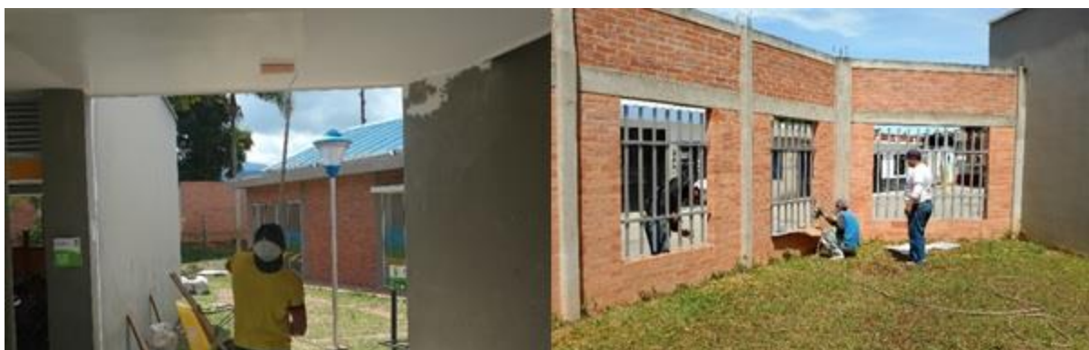
Figura 55. Pintura en pasillo principal y carpintería metálica
