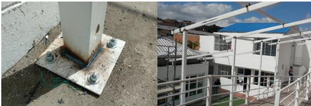
Figura 63. Instalación de estructura de cubierta
