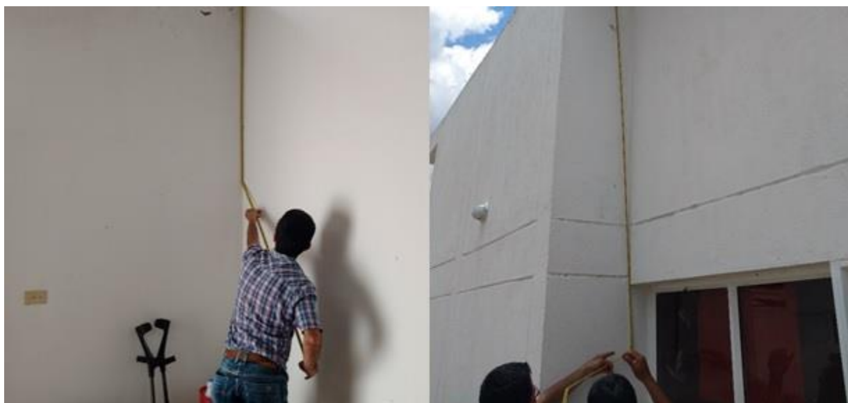
Figura 15. Medición de muros
