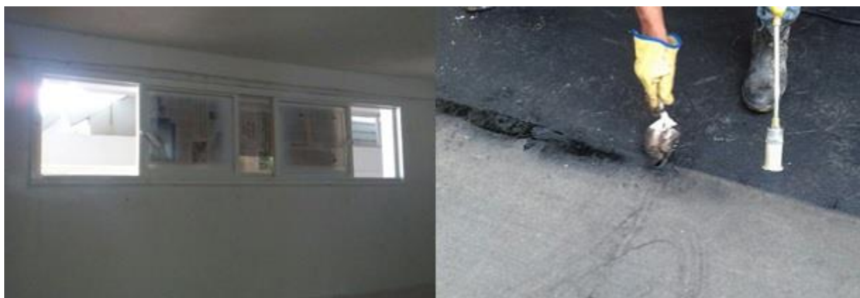
Figura 47. Pintura en carpintería metálica e impermeabilización en placas
