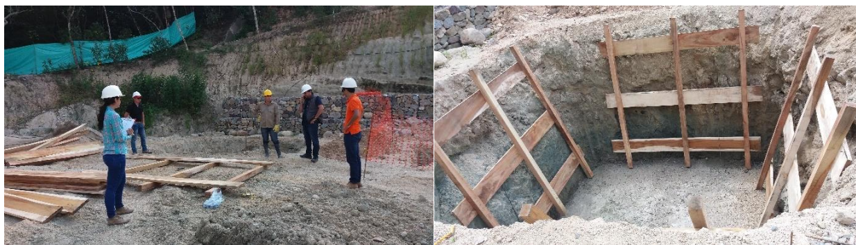
Figura 30. Elaboración e instalación de entibado Fuente. Autor 2018.
