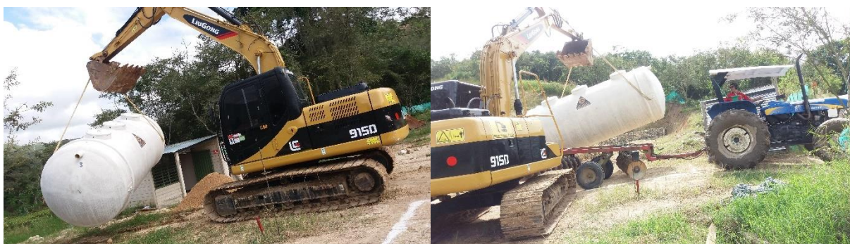
Figura 15. Retiro del tanque con retroexcavador Fuente. Autor 2018.
