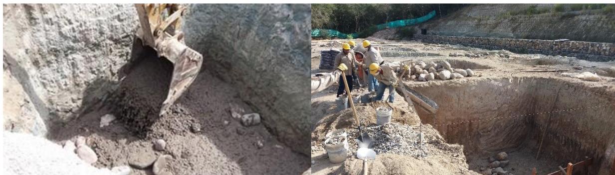
Figura 24. Vaciado del cimiento Fuente. Autor 2018.
