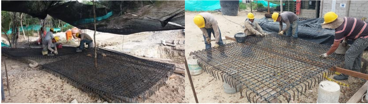
Figura 26. Armado acero de refuerzo para zapatas Fuente. Autor 2018.
