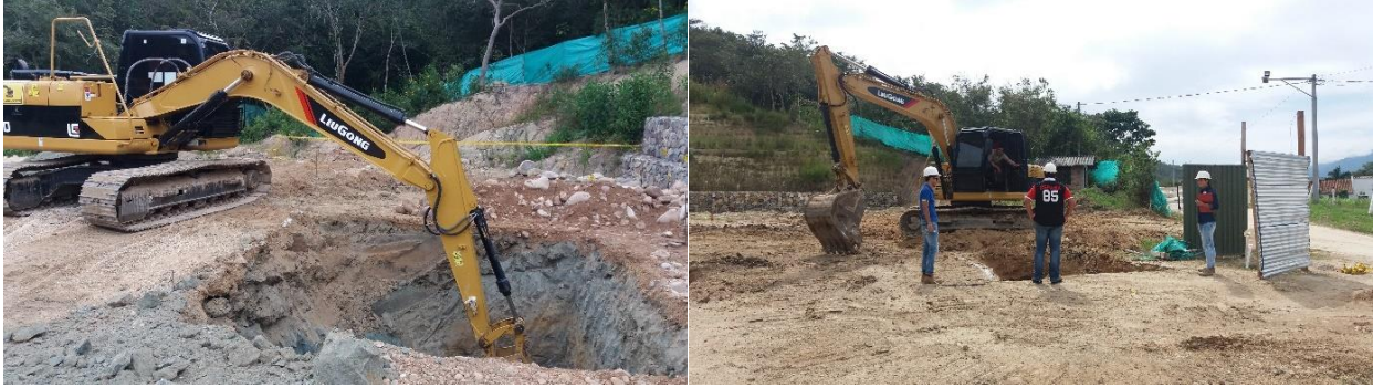
Figura 19. Excavación mecánica Fuente. Autor 2018.
