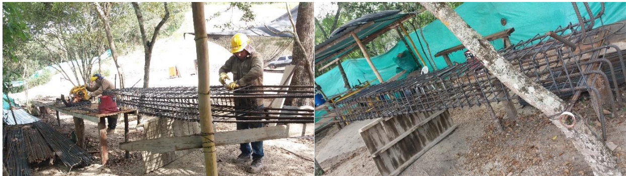
Figura 27. Armado de acero para columnas Fuente. Autor 2018.
