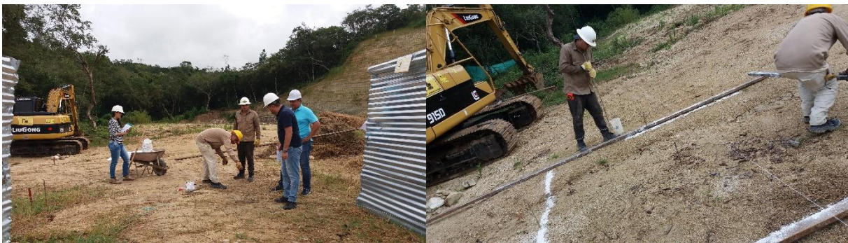
Figura 17. Demarcación para ejes con cal Fuente. Autor 2018.
