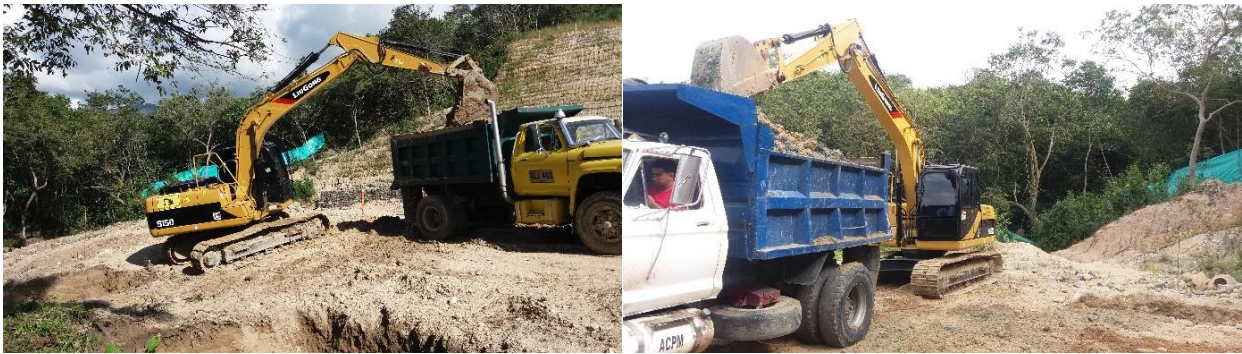
Figura 20. Retiro material a escombrera Fuente. Autor 2018.
