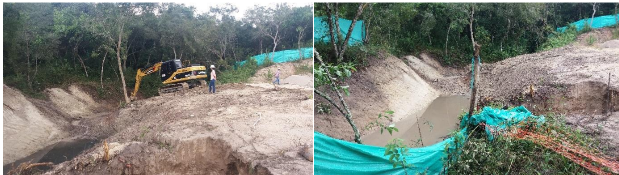
Figura 21. Adecuación canal natural. Fuente: Autor 2018.
