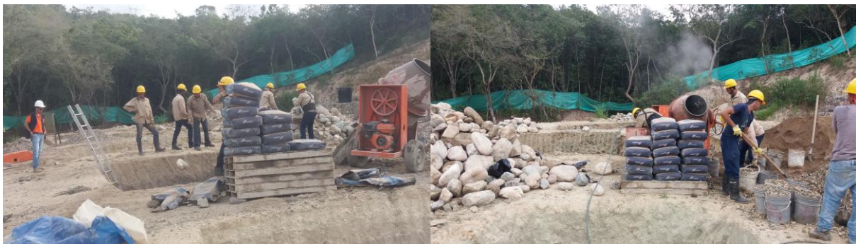
Cimiento en concreto ciclópeo
