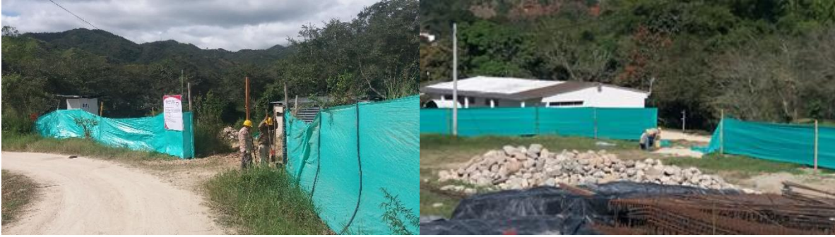
Figura 18. Cerramiento zona de acopio Fuente. Autor 2018.
