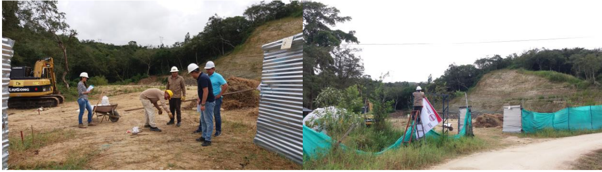
Adecuacion y limpieza de la obra
