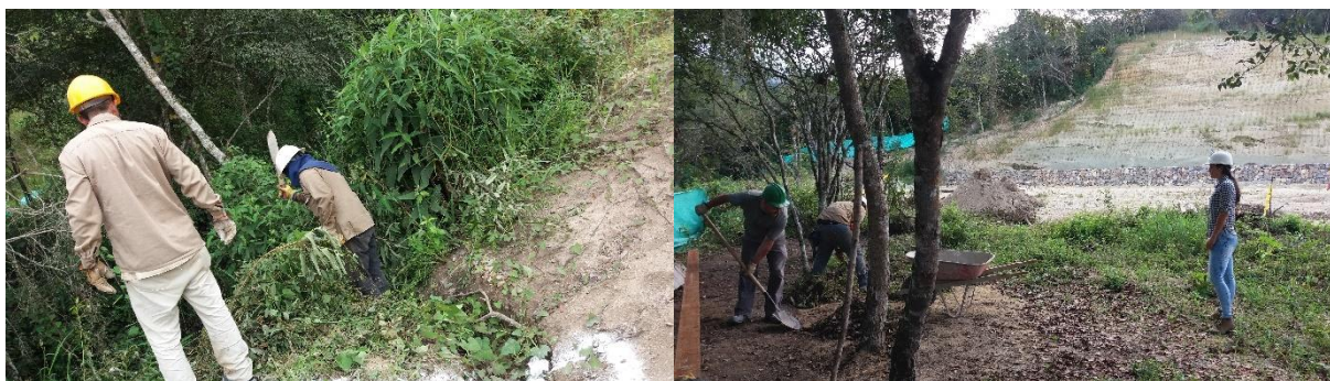
Figura 16. Limpieza y descapote
