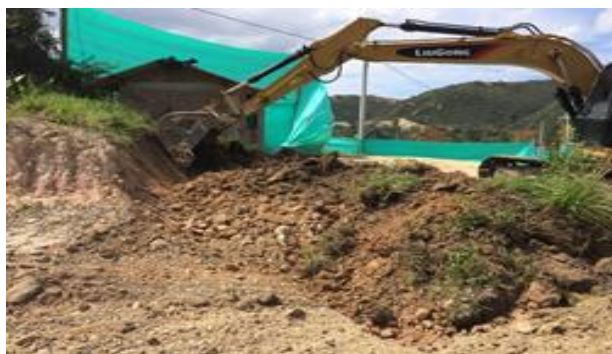
Figura 31. Desmonte de caseta
