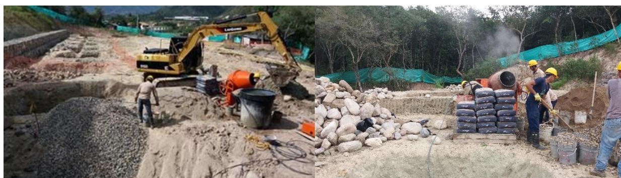
Figura 23. Preparación concreto ciclópeo Fuente. Autor del proyecto.
