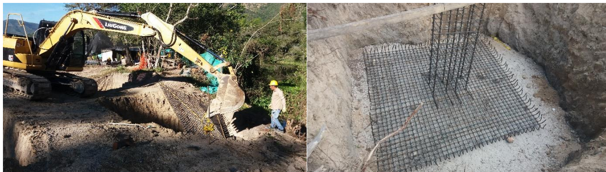
Figura 28. Instalación de parrilla y columna en cajones Fuente. Autor 2018.
