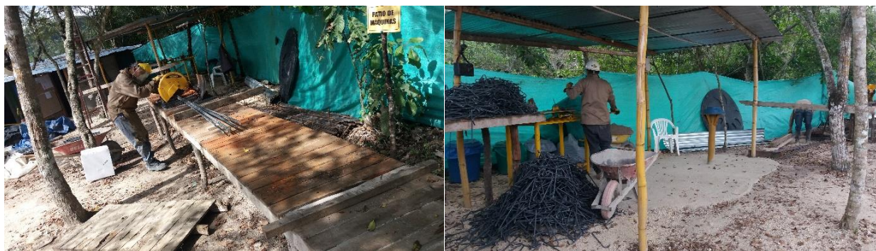
Figura 25. Corte y figurado de acero. Fuente. Autor 2018.
