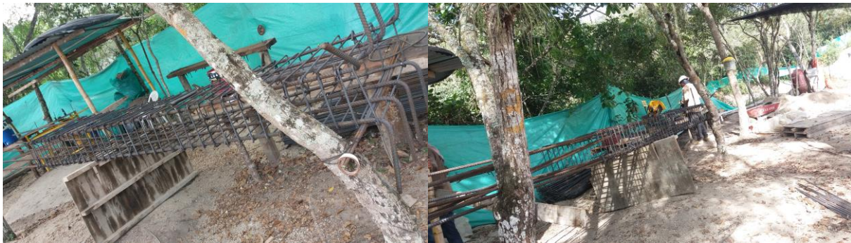
Armado de acero columnas
