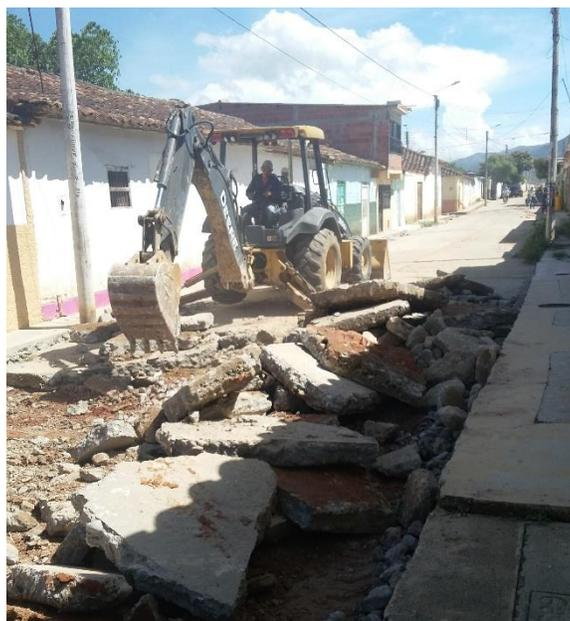
Fotografía 5. Ruptura de pavimento existente
