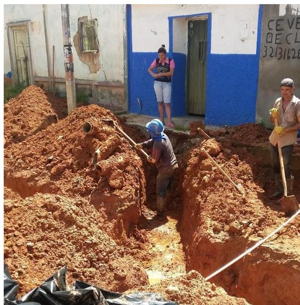
Fotografía 17. Excavación manual de zanjas.
