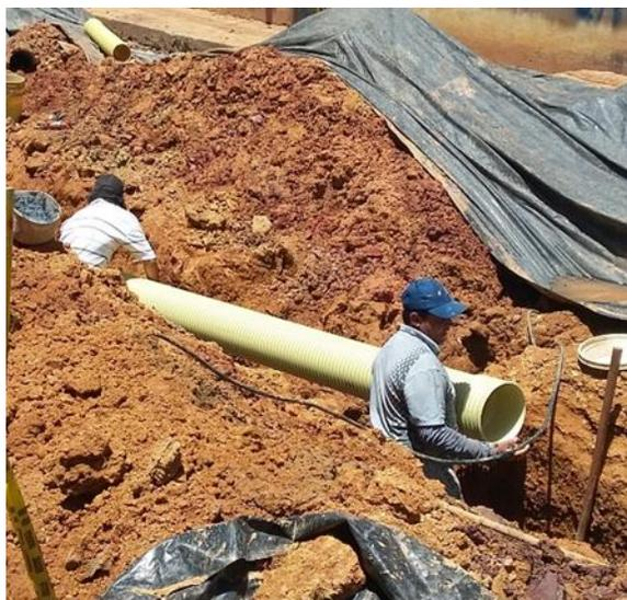
Fotografía 16. Instalación de tubería PVC.
