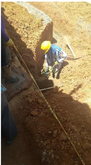
Fotografía 18. Demolición de cajas de conexión domiciliaria existentes.
