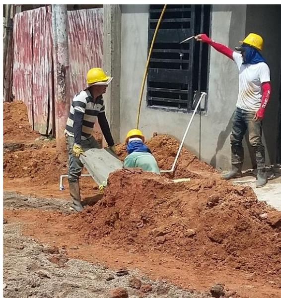
Fotografía 21. Colocación de tapas para cajas de conexión.
