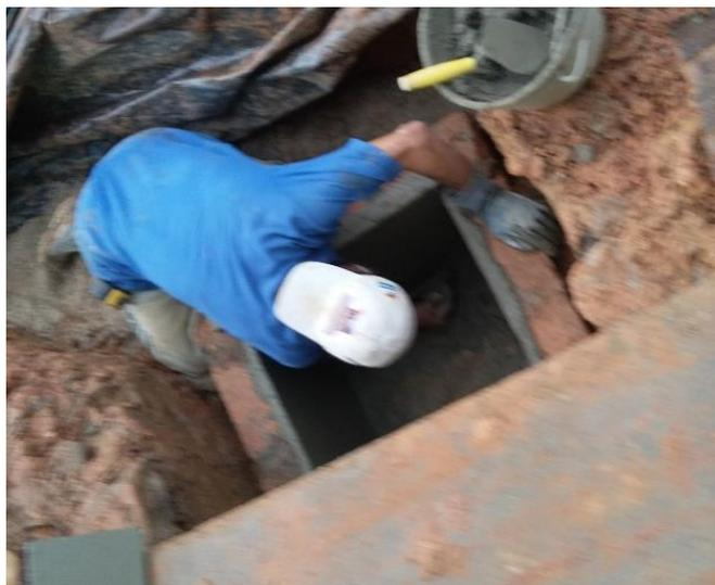
Fotografía 19. Construcción de cajas de conexión domiciliaria.
