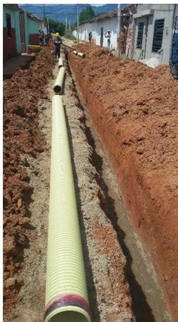
Fotografía 15. Transporte de tubería PVC para posterior colocación.
