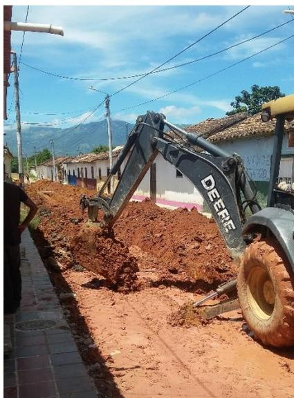
Fotografía 9. Excavación mecánica de material común.
