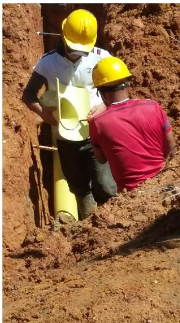
Fotografía 20. Soldadura de PVC para accesorios Silla Y 10-6.
