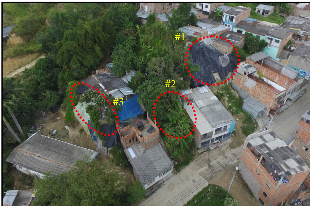
Figura 26. Taludes estudiados en el sector de ladera del Barrio Cuesta Blanca. Fuente. Autores del proyecto.
