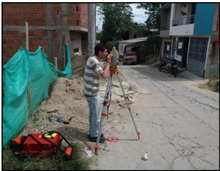
Figura 31. Estación total marca SOUTH. Fuente. Autores del proyecto
