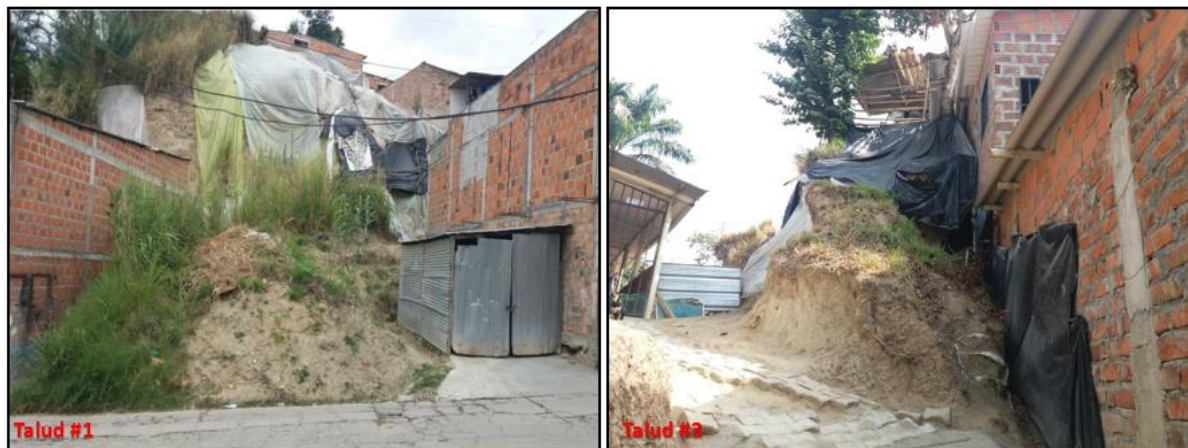
Figura 2. Sector de Ladera del Barrio Cuesta Blanca, después de la Intervención. Fuente. Autores del proyecto.
