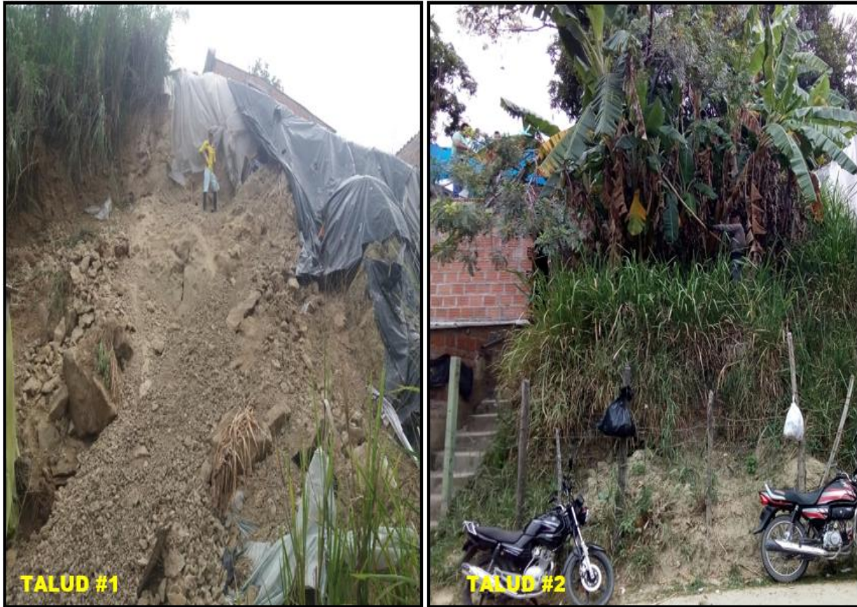
Figura 23. Taludes en el sector de ladera en estudio Fuente. Autores del proyecto.
