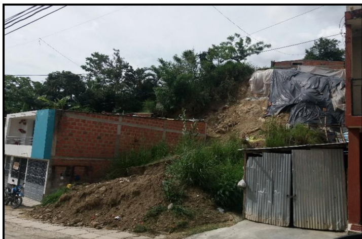
Figura 43. Vista general del deslizamiento ocurrido en la fecha del 05 de Mayo del 2018 del talud #1.
