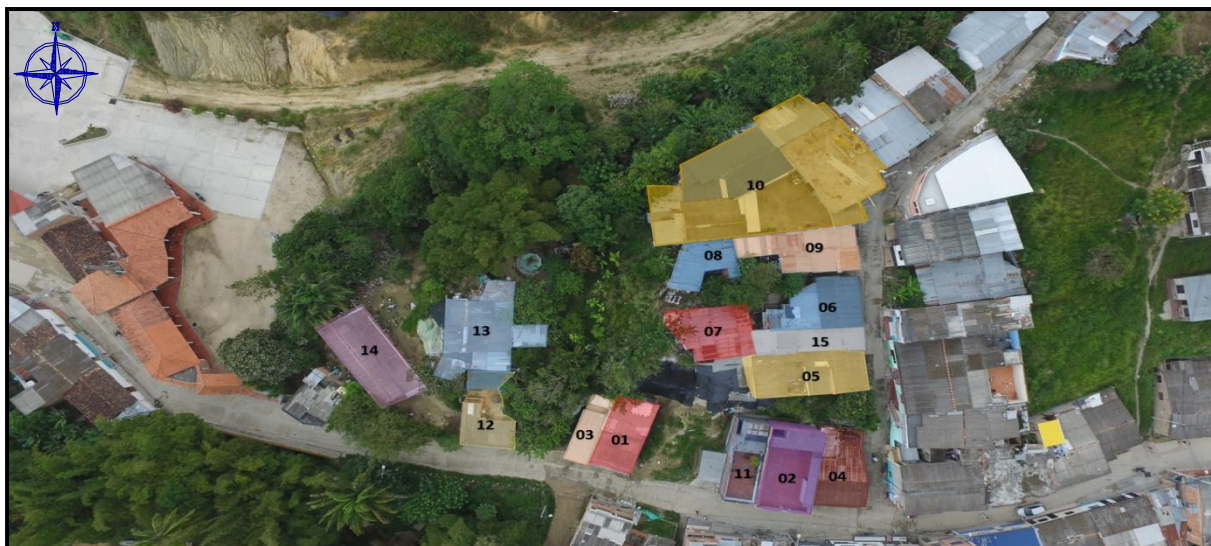
Figura 49. Viviendas ubicadas en el sector de ladera en estudio.
