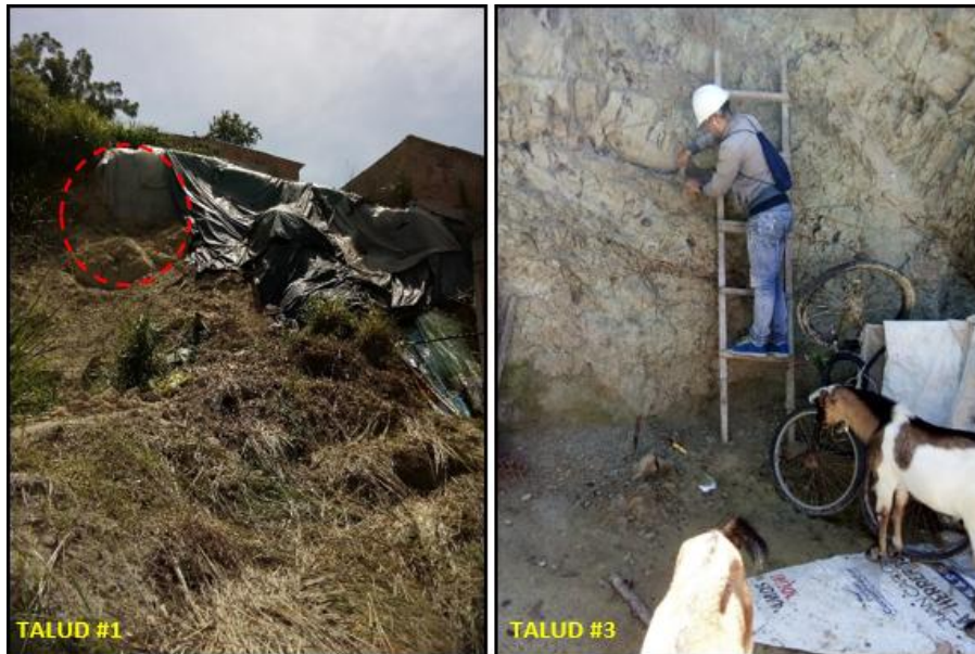
Figura 35. Limpieza de la superficie de los taludes.
