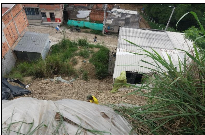
Figura 42. Deslizamiento ocurrido en la fecha del 05 de Mayo del 2018, vista corona del talud #1. Fuente. Autores del proyecto
