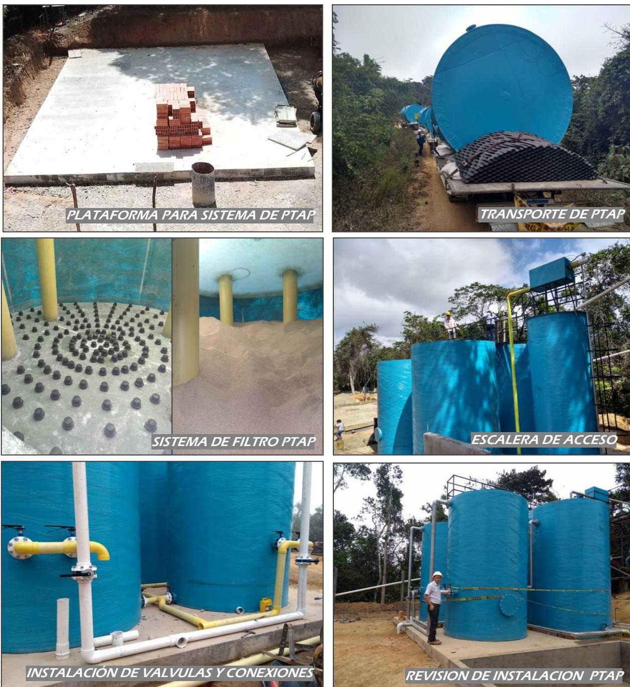
Fotografía 12. Sistema planta de tratamiento de agua potable. Fuente: Autor de la pasantía.
