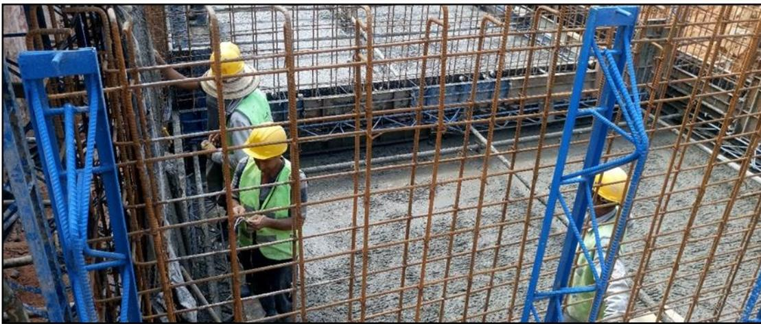
Fotografía 9. Supervisión en la actividad de acero de refuerzo para tanque de almacenamiento. Fuente: Autor de la pasantía.
