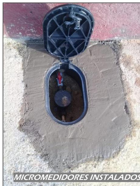
Fotografía 16. Instalación de tubería y micromedidores domiciliarios. Fuente: Autor de la pasantía.
