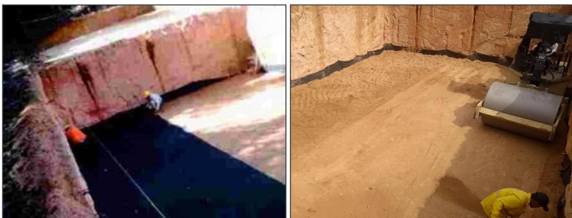
Fotografía 7. Instalación de Geotextil y material clasificado para base. Fuente: Autor de la pasantía.
