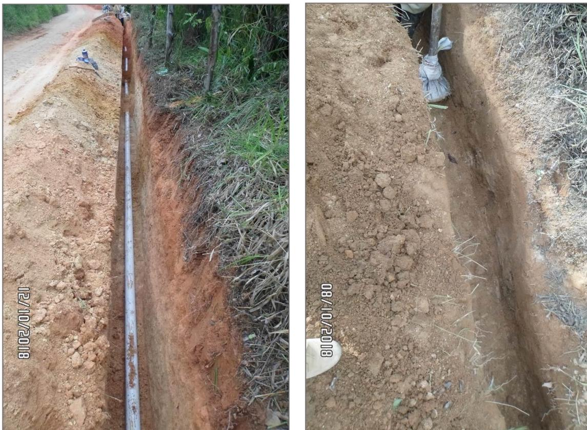
Fotografía 15. Excavación e instalación de tubería de conducción. Fuente: Autor de la pasantía.
