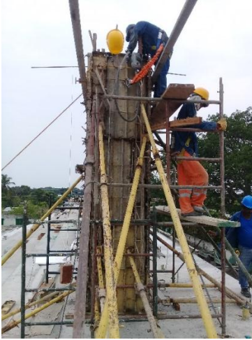
Imagen. 206. Aplomado de columna, Eje J, Nivel 4
