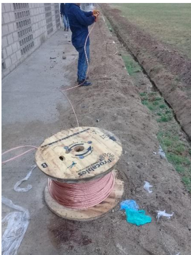
Imagen. 134. Instalación de cableado de cobre
