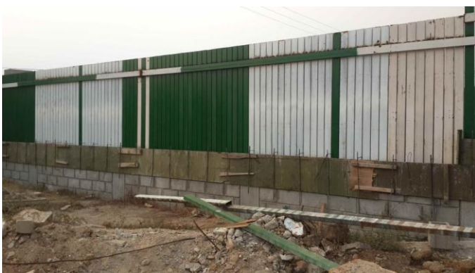
Imagen. 193. Vaciado de concreto de viga corona de cerramiento.
