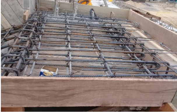
Imagen. 55. Armado de acero de refuerzo de escaleras de acceso a graderías, modulo 2
