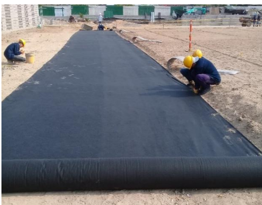
Imagen. 87. Extensión de geotextil en zona de traslado. Oriental.
