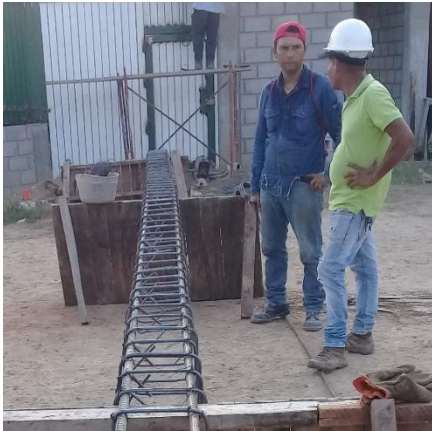
Imagen. 61. Armado de acero de refuerzo de viga de cimentación de portón Sur
