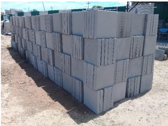
Imagen. 122. Losetas de urbanismo fabricadas in situ Tipo 1
