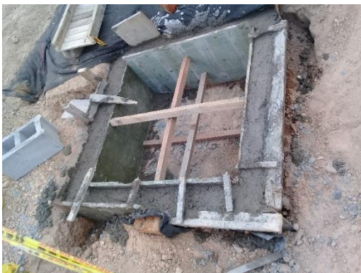
Imagen. 76. Fundida en concreto de caja de inspección principal.
