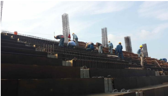
Imagen. 168. Armado de acero modulo central 1. Sección CD.
