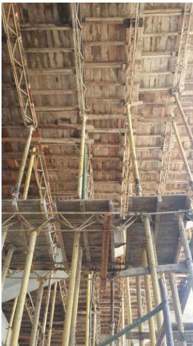
Imagen. 176. Obra falsa de graderías, modulo central 2.
