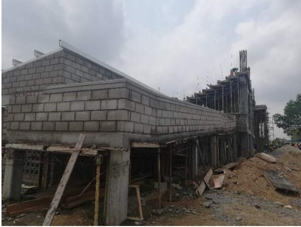
Imagen. 194. Levante de mampostería en rampa Norte
