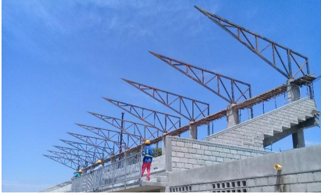
Imagen. 70. Instalación de estructura de soporte para cubierta.
