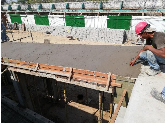
Imagen. 175. Vaciado de concreto de rampa Sur
