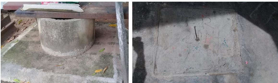
Imagen. 236. Pozo subterráneo anillado.
