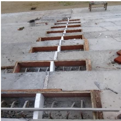
Imagen. 35. Encofrado de Escalinatas en junta de dilatación.
