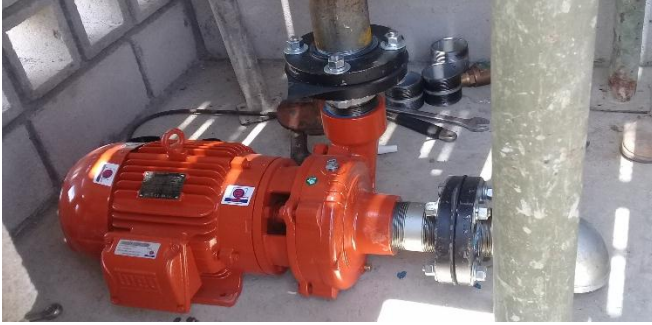
Imagen. 224. Electrobomba de 10HP
