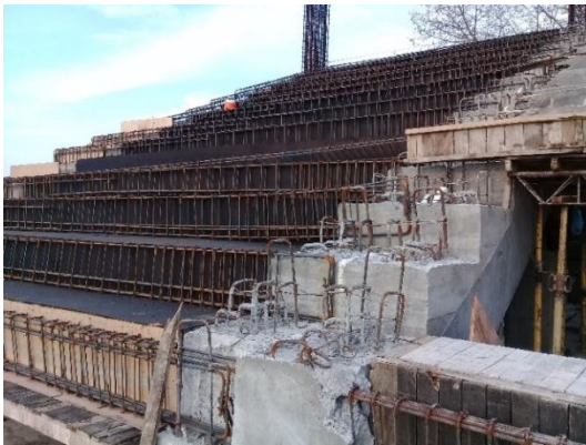
Imagen. 48. Armado de acero e graderías, modulo lateral 1.
