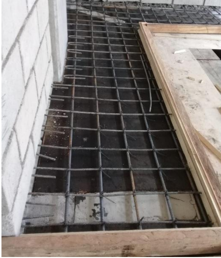
Imagen. 186. Armado de acero de bancos de camerinos.
