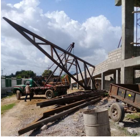
Imagen. 212. Descargue de perfiles metálicos de cubierta.
