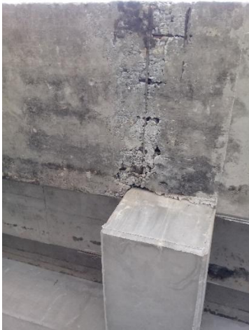
Imagen. 40. Desencofrado de graderías, vista inferior
