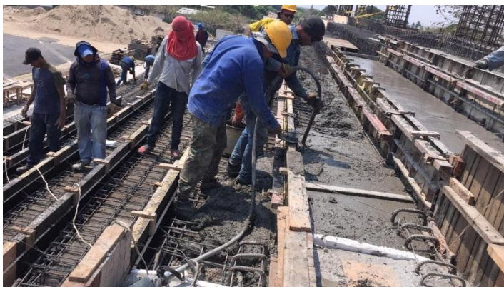
Imagen. 174. Vaciado de concreto en modulo central 1 sección BC.
