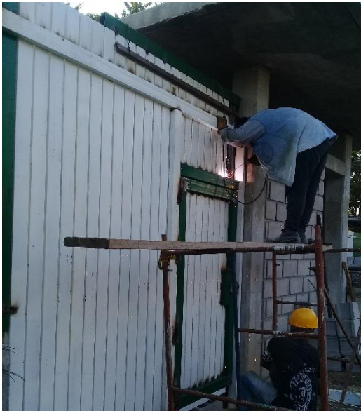
Imagen. 113. Instalación del portón para acceso de peatones
