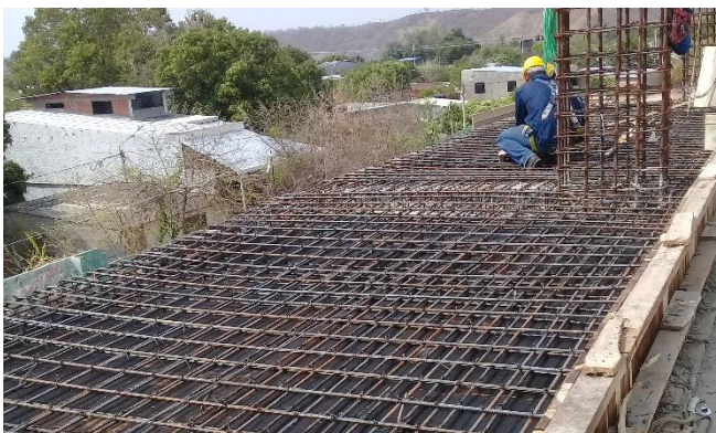
Imagen. 49. Armado de acero de refuerzo de lozas de palcos.
