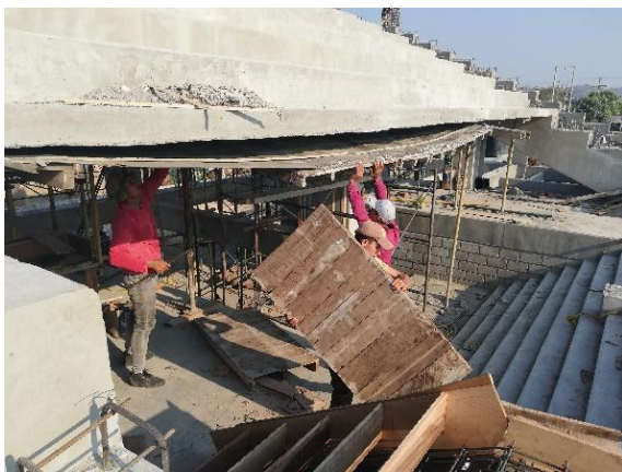
Imagen. 179. Retiro de formaletas en modulo central 1 Sección CD.
