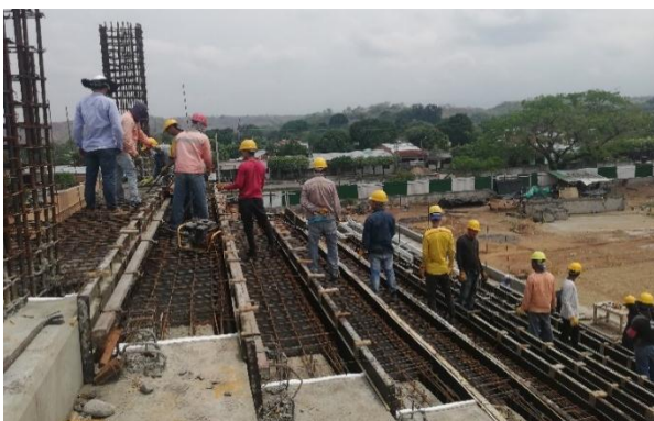
Imagen. 78. Fundida en concreto de graderías modulo lateral 2
