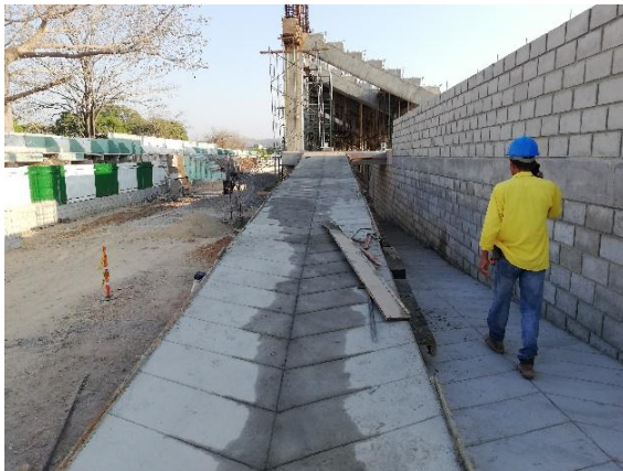
Imagen. 178. Curado de concreto en rampa sur.
