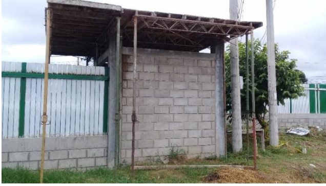
Imagen. 15. Armado de Formaleta para Placa de Taquilla Norte.
