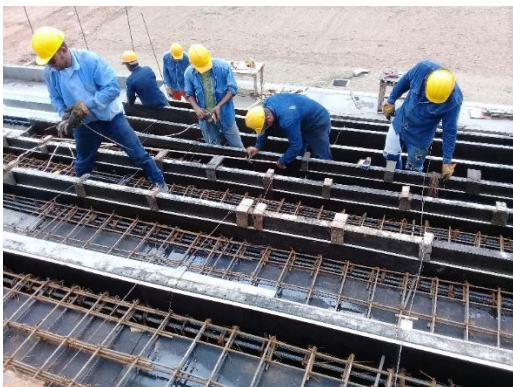
Imagen. 26. Formaletado de graderías superior Sección E-F Modulo 2
