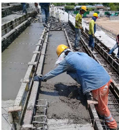
Imagen. 77. Fundida en concreto de graderías Sección GH modulo central
