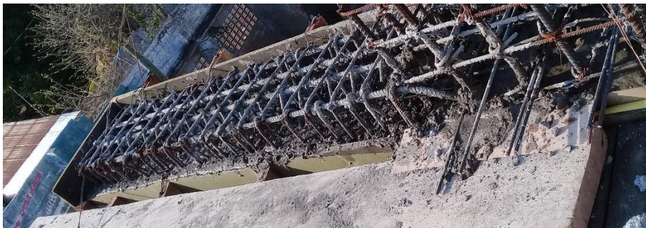
Imagen. 74. Fundida en concreto de ménsula Eje H.
