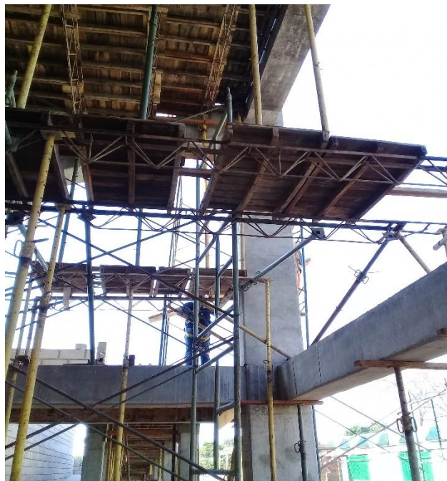
Imagen. 17. Obra falsa de graderías.
