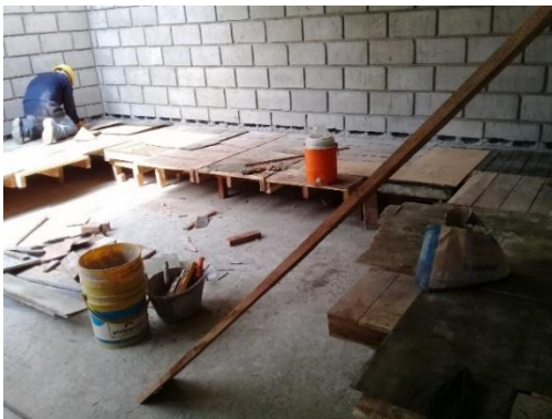
Imagen. 36. Encofrado y armado de obra falsa de bancos de camerinos
