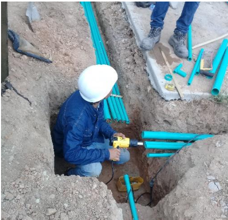
Imagen. 213. Instalaciones de tubería para cableado eléctrico.
