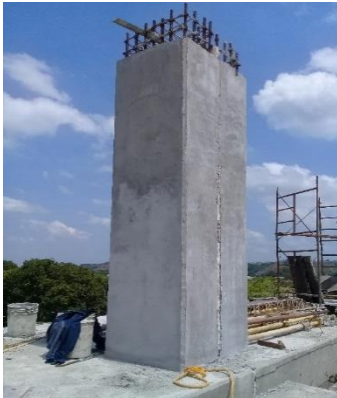
Imagen. 207. Acabado final de Columna Eje M-N.
