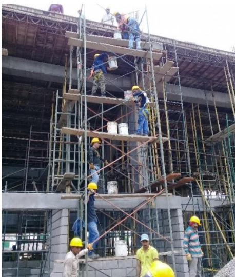
Imagen. 81. Vaciado de concreto de palco, Modulo 1
