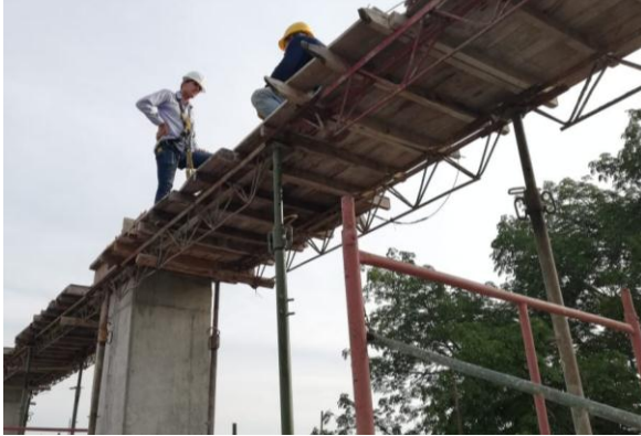
Imagen. 60. Supervisión armado de Acero Viga Aérea nivel 4
