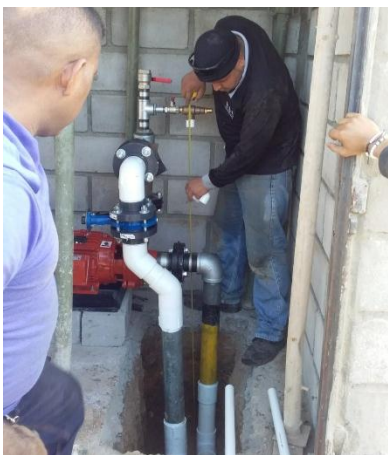
Imagen. 205. Instalación de electrobomba para sistema de riego.
