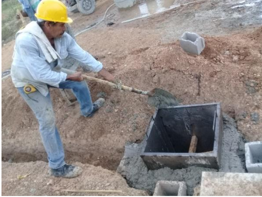
Imagen. 131. Vaciado en concreto de cajas eléctricas.
