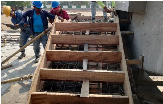
Imagen. 25. Encofrado de escalera # 1 de acceso a graderías.
