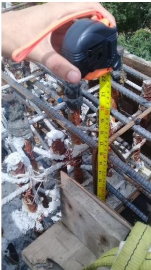
Imagen. 59. Chequeo del nivel de los pernos con respecto a la viga.
