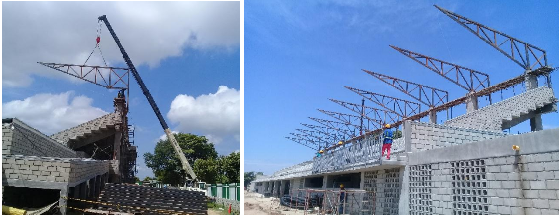
Imagen. 222. Instalación de cerchas y estructura de cubierta. De graderías.
