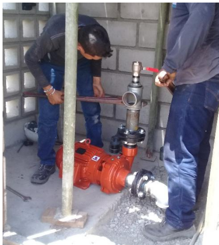
Imagen. 105. Instalación de Bomba de 10HP para riego de cancha.
