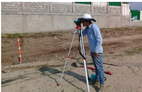
Imagen. 88. Verificación de niveles para capa de arena en zonas de traslado
