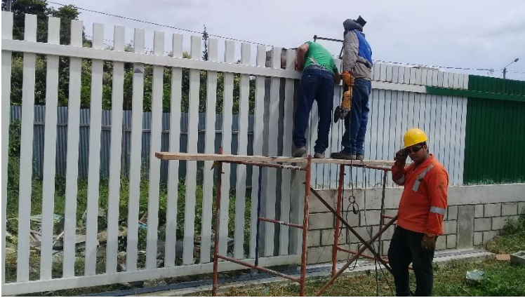
Imagen. 112. Instalación de portón de cerramiento lado norte
