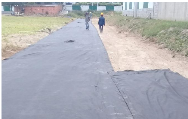
Imagen. 89. Extensión de geotextil en Zona de traslado Oriental
