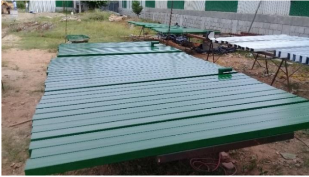
Imagen. 110. Pintura anticorrosiva para tubería de cerramiento.
