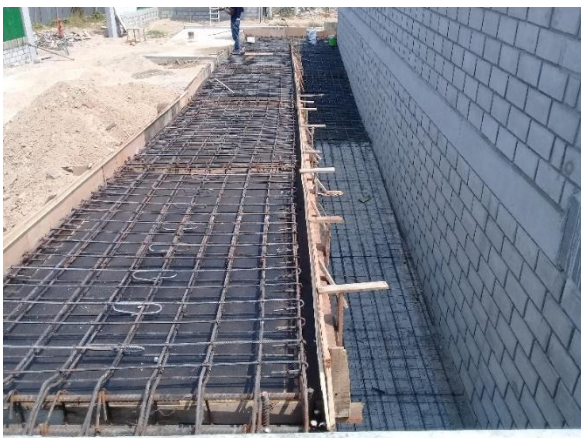
Imagen. 47. Armado de acero de refuerzo de rampa norte.
