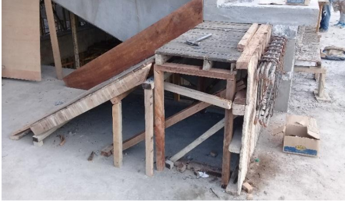
Imagen. 24. Encofrado de escaleras # 2 de acceso a graderías.
