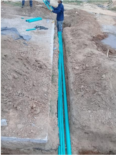
Imagen. 133. Instalación de tubería eléctrica.
