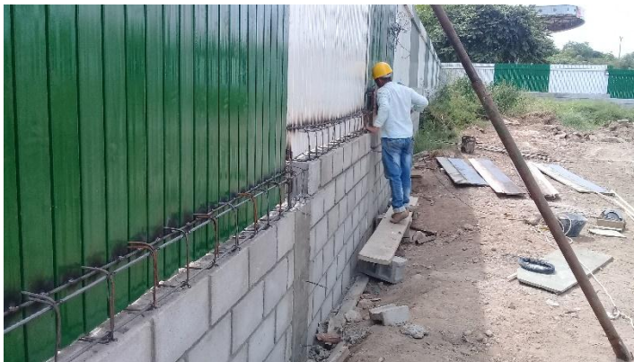
Imagen. 111. Armado de Acero de viga corona de cerramiento.
