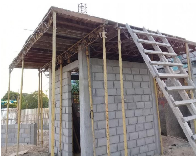
Imagen. 14. Armado de obra falsa para placa de taquilla sur
