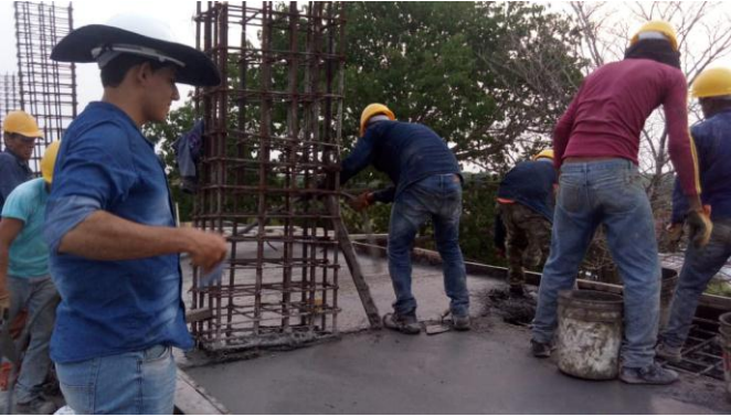
Imagen. 79. Fundida en concreto de Palco para reporteros Modulo 2
