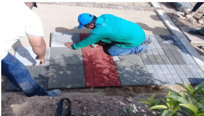
Imagen. 126. Proceso de instalación de losetas para senderos de urbanismo.
