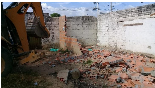
Imagen. 211. Demolición de campamento provisional
