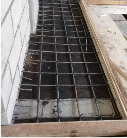
Imagen. 46. Armado de acero de refuerzo de bancas de camerinos.
