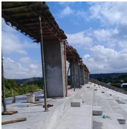
Imagen. 210. Encofrado de viga aérea nivel 4, Eje 1.
