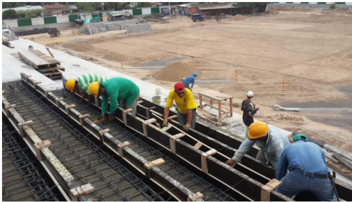
Imagen. 173. Colocación de guardera metálicas en modulo central Sección HF
