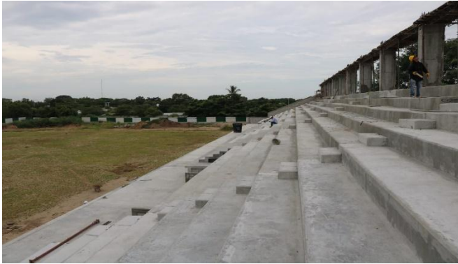
Imagen. 197. Módulos de graderías en etapa final.
