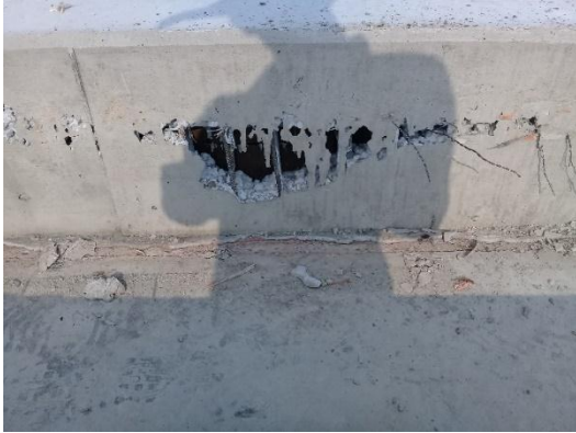
Imagen. 41. Desencofrado de graderías, Vista Superior
