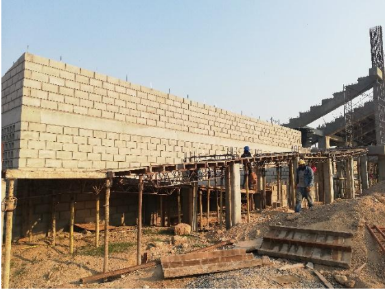
Imagen. 180. Armado de obra falsa de rampa norte.
