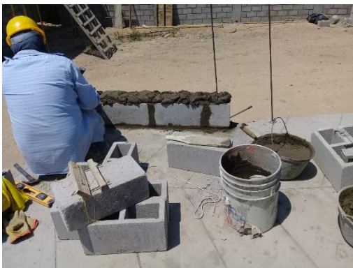
Imagen. 188. Levante de mampostería en la rampa sur.
