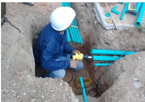
Imagen. 130. Instalación de tuberías para cableado eléctrico.
