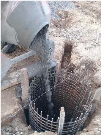
Imagen. 221. Vaciado de concreto de cimentación de mástiles de iluminación.
