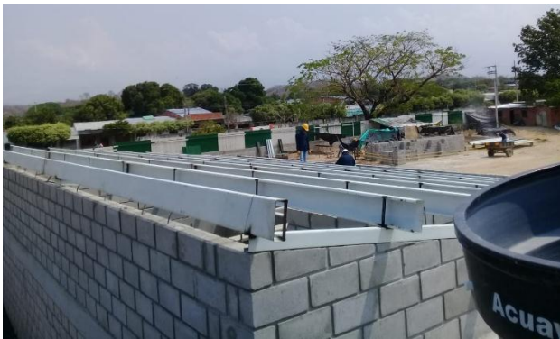
Imagen. 184. Instalación de perfiles metálicos para cubierta de camerinos.
