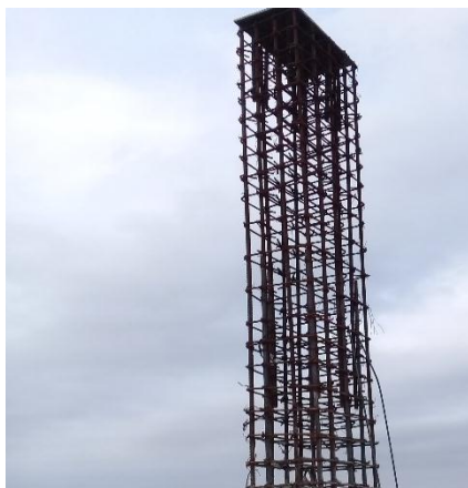
Imagen. 52. Instalación de flanches.
