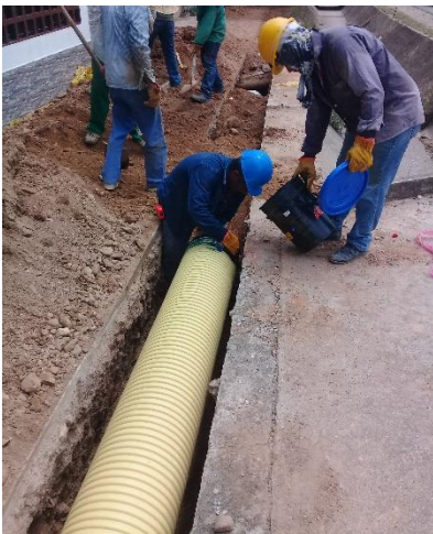
Imagen. 217. Instalación de tubería de 14" para desagüe de aguas lluvias.
