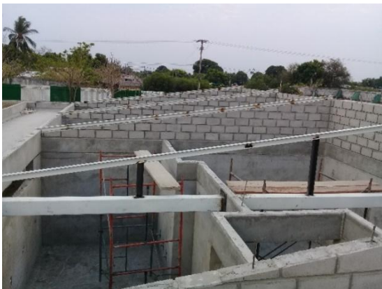
Imagen. 65. Armado de perfiles metálicos para soporte de cubierta, modulo 1.
