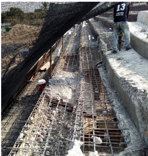
Imagen. 22. Demolición de gradarías afectadas.
