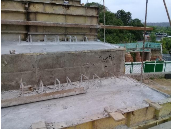
Imagen. 43. Desencofrado de graderías, modulo Lateral 2
