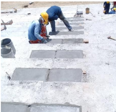
Imagen. 208. Fundida de escalinatas en concreto.
