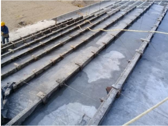
Imagen. 82. Curado de concreto en graderías modulo lateral 1.
