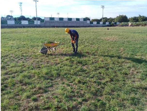
Imagen. 102. Retiro de material vegetal no deseado.
