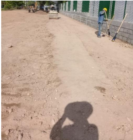
Imagen. 216. Conformación y nivelación del urbanismo.
