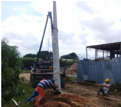
Imagen. 132. Instalación de postes eléctricos
