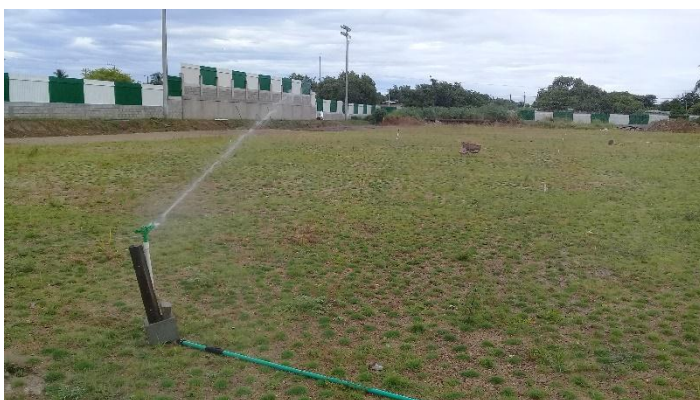
Imagen. 97. Riego de agua con aspersores provisionales
