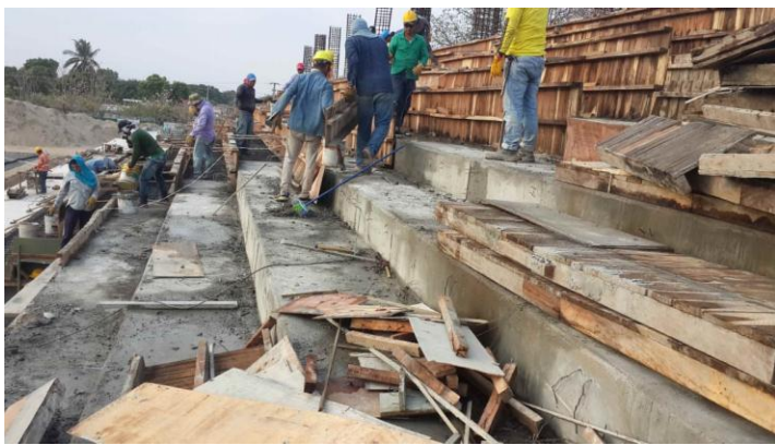
Imagen. 170. Curado del concreto.
