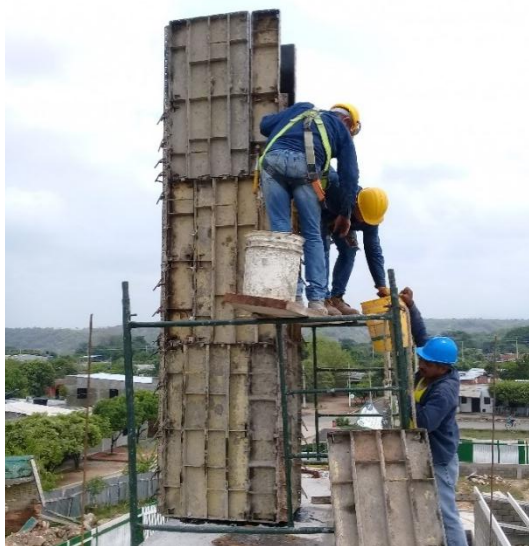
Imagen. 28. Encofrado de Columnas nivel 4 Eje J
