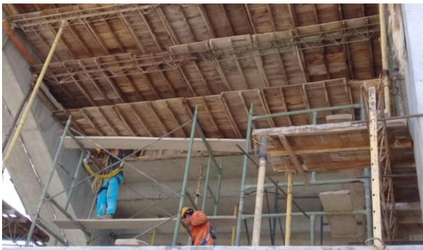
Imagen. 42. Retiro de formaletas y obra falsa de graderías
