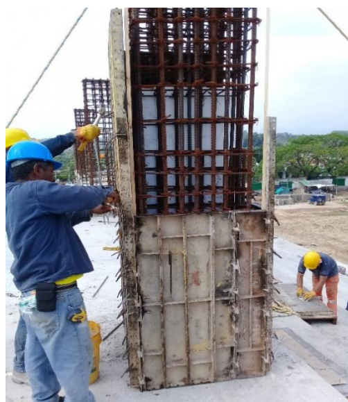
Imagen. 29. Encofrado de Columnas nivel 4. Eje F
