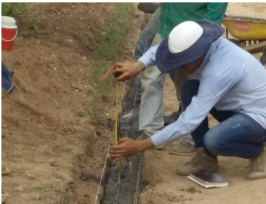
Imagen. 119. Chequeo de niveles para bordillos de urbanismo.
