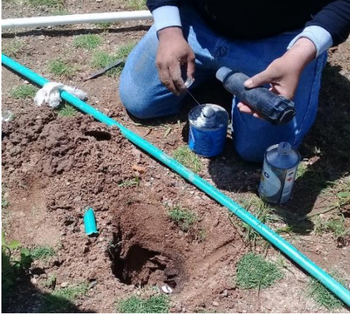
Imagen. 106. Instalación de distribuidores de riego.
