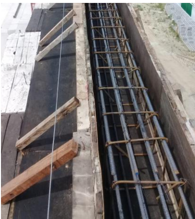
Imagen. 198. Armado de acero de viga aérea, eje 1, nivel 4.
