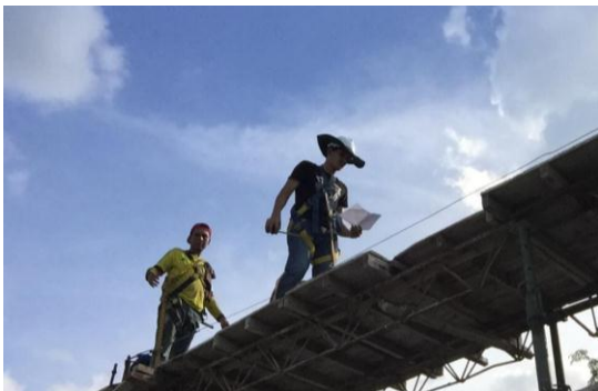
Imagen. 62. Chequeo de acero de refuerzo de Viga aérea, nivel 4, eje 1. Modulo lateral.
