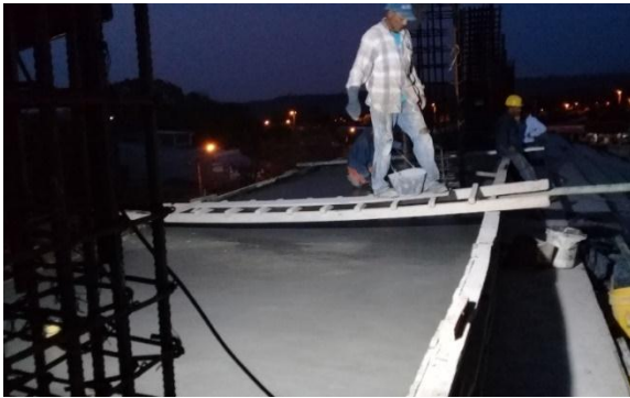
Imagen. 80. Fundida en concreto de Palco para reporteros Modulo 1
