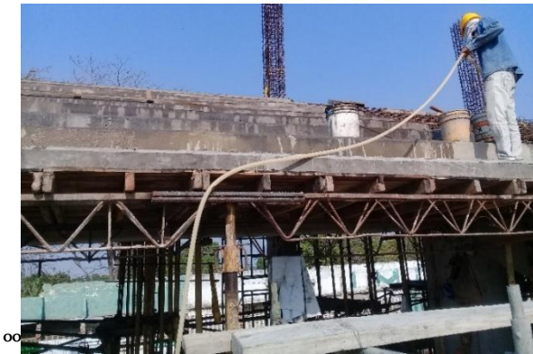
Imagen. 83. Curado de concreto en graderías modulo central 1.
