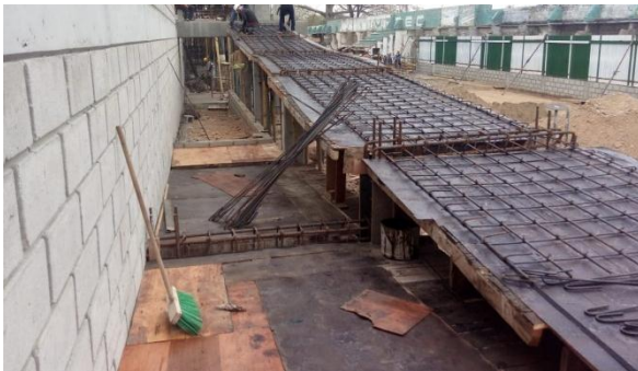
Imagen. 182. Armado de acero de rampa norte.
