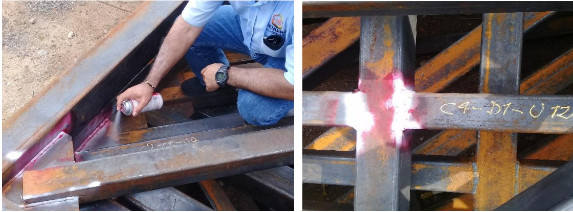
Imagen. 68. Ensayo de tinta penetrante de soldadura.
