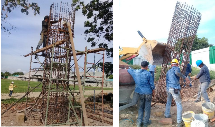
Imagen. 64. Armado e instalación de acero de refuerzo de cimentación de mástil.
