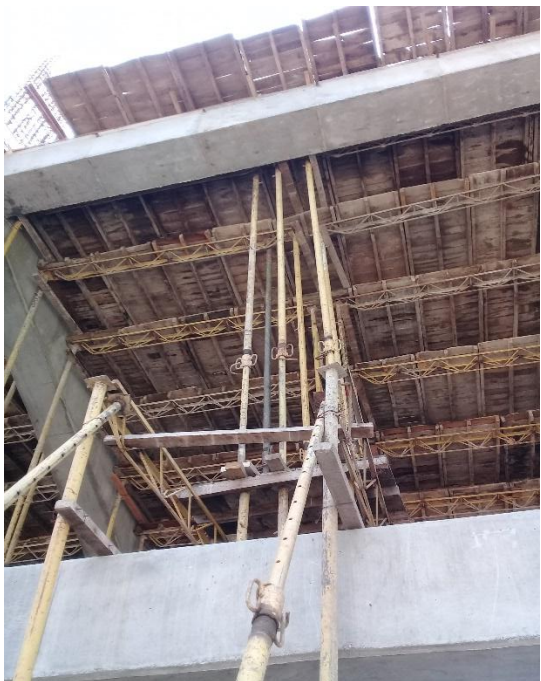
Imagen. 16. Obra falsa de graderías.
