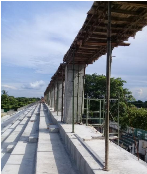
Imagen. 31. Armado de obra falsa de Viga del Eje 1 Nivel 4
