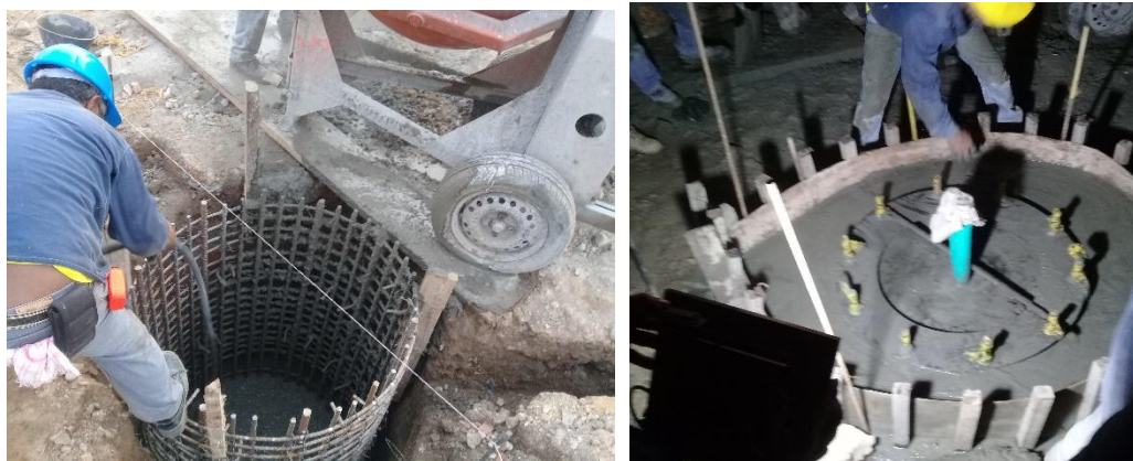
Imagen. 84. Vaciado de concreto de cimentación de mástiles.
