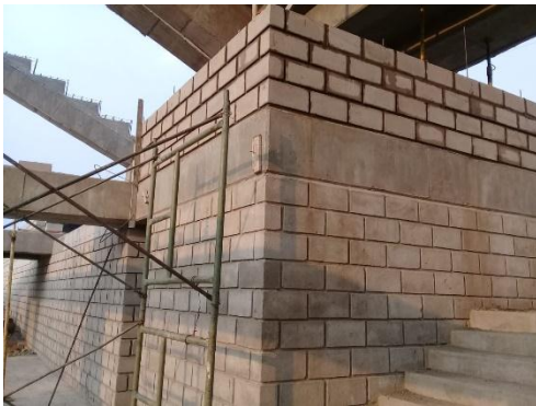
Imagen. 187. Levante de mampostería en el módulo central 2.
