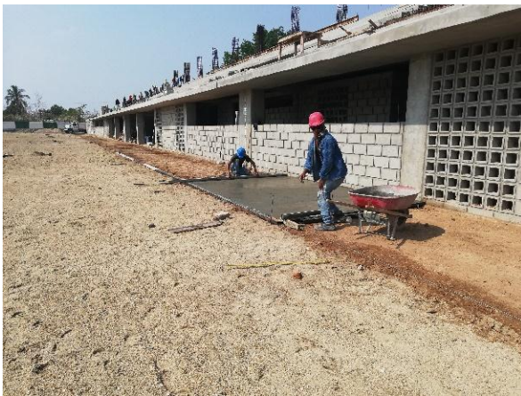
Imagen. 192. Vaciado de concreto de placa de contra piso.
