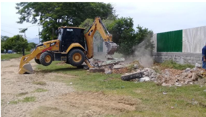
Imagen. 116. Demolición de antiguo cerramiento, lado Norte
