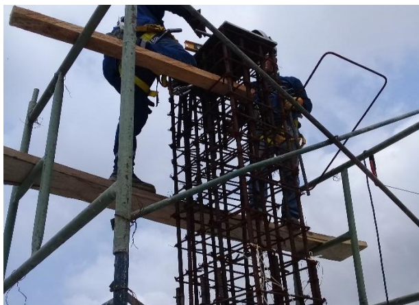
Imagen. 53. Instalación de flanches en columnas, nivel 4.
