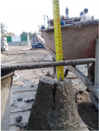
Imagen. 138. Medida del asentamiento.
