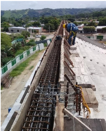
Imagen. 33. Colocación de guardera y listones de anclaje, Viga Nivel 4 Eje 1
