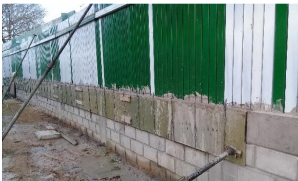
Imagen. 109. Apuntalamiento de tubería de cerramiento y viga corona.
