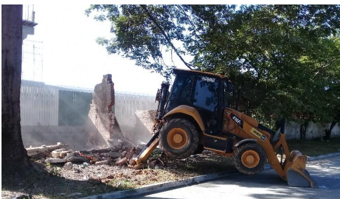
Imagen. 117. Demolición antiguo cerramiento lado occidental.
