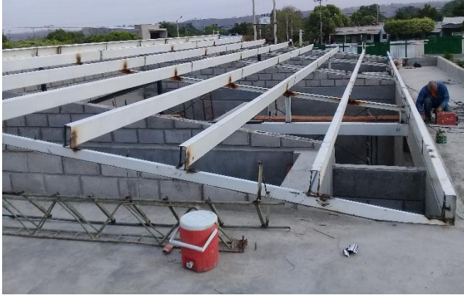
Imagen. 66. . Armado de perfiles metálicos para soporte de cubierta, modulo 2.
