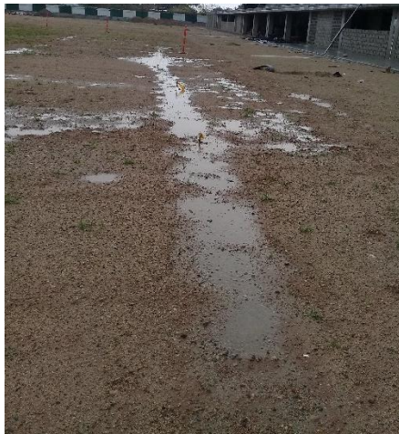
Imagen. 231. Comportamiento de sistema de drenaje.
