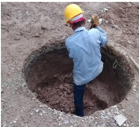
Imagen. 214. Excavación para cimentación de mástil de iluminación
