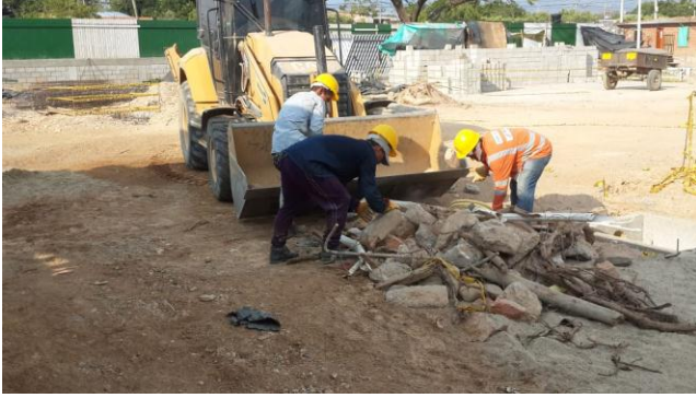
Imagen. 191. Conformación y nivelación de zonas de traslado.
