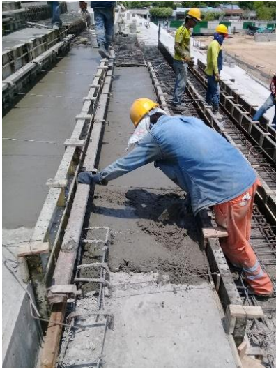
Imagen. 189. Vaciado de concreto de graderías del módulo central 2.
