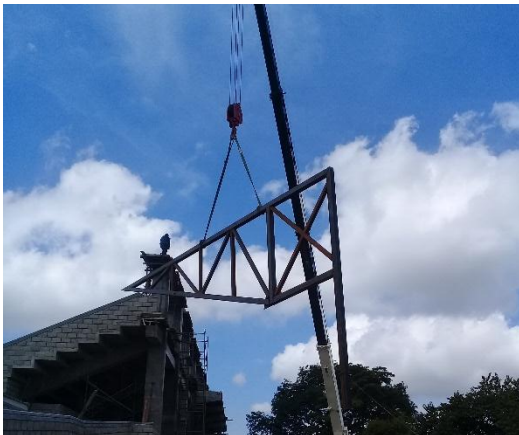
Imagen. 69. Instalación de estructura de soporte para cubierta.
