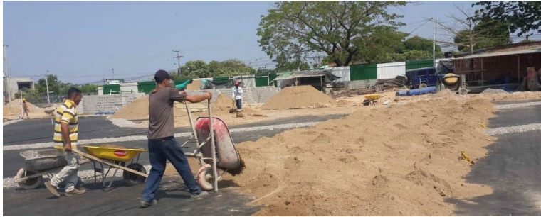
Imagen. 169. Riego de arena filtrante sobre campo de juego.
