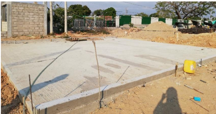
Imagen. 146. Tanque de almacenamiento.
