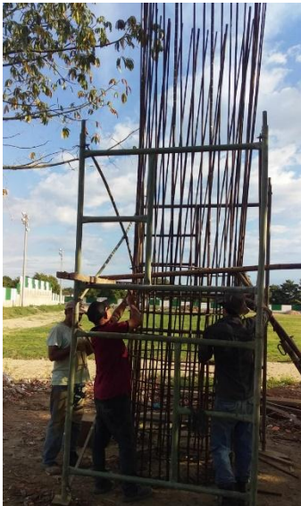
Imagen. 63. Armado de acero de refuerzo de cimentación de mástil.
