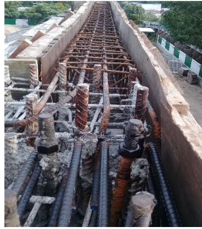
Imagen. 58. Verificación de nivel de pernos.
