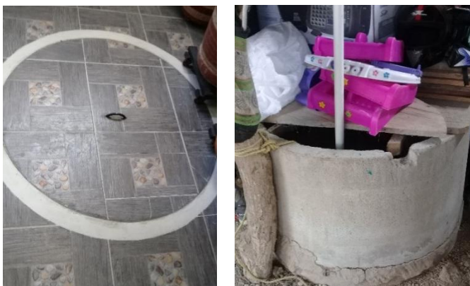
Imagen. 235. Pozos subterráneos anillados.
