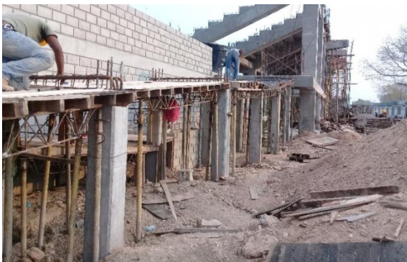
Imagen. 12. Armado de formaleta y obra falsa de rampa Norte
