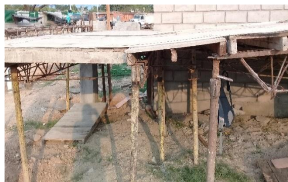
Imagen. 11. Armado de formaleta, rampa norte.
