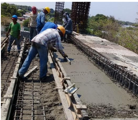
Imagen. 75. Vaciado de concreto en graderías, sección BC
