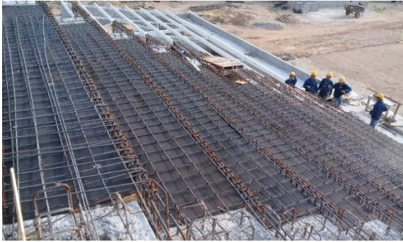
Imagen. 50. Armado de acero de refuerzo de graderías modulo lateral 2.
