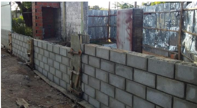
Imagen. 202. Levante de mampostería de cerramiento.
