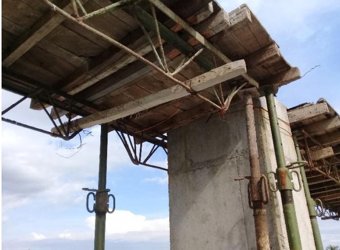
Imagen. 32. Armado de obra falsa de Viga del Eje 1 Nivel 4
