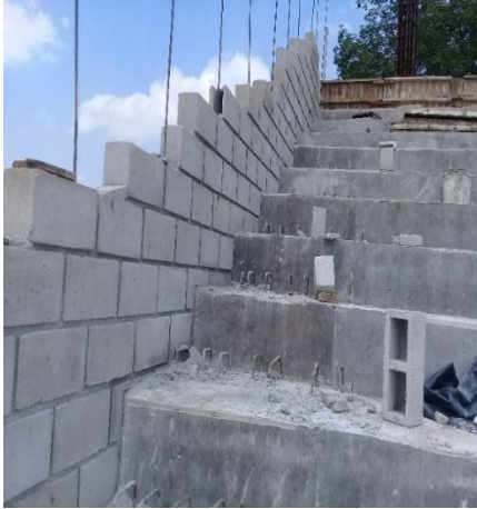
Imagen. 209. Levante de mampostería sobre graderías del módulo lateral.
