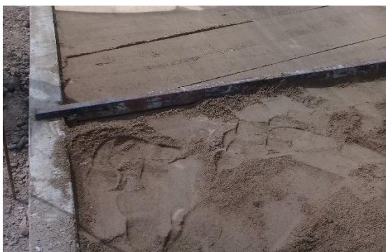
Imagen. 125. Riego y distribución de arena para capa base de losetas.
