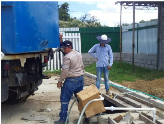
Imagen. 201. Abastecimiento de tanque de almacenamiento por medio de Carro tanques.
