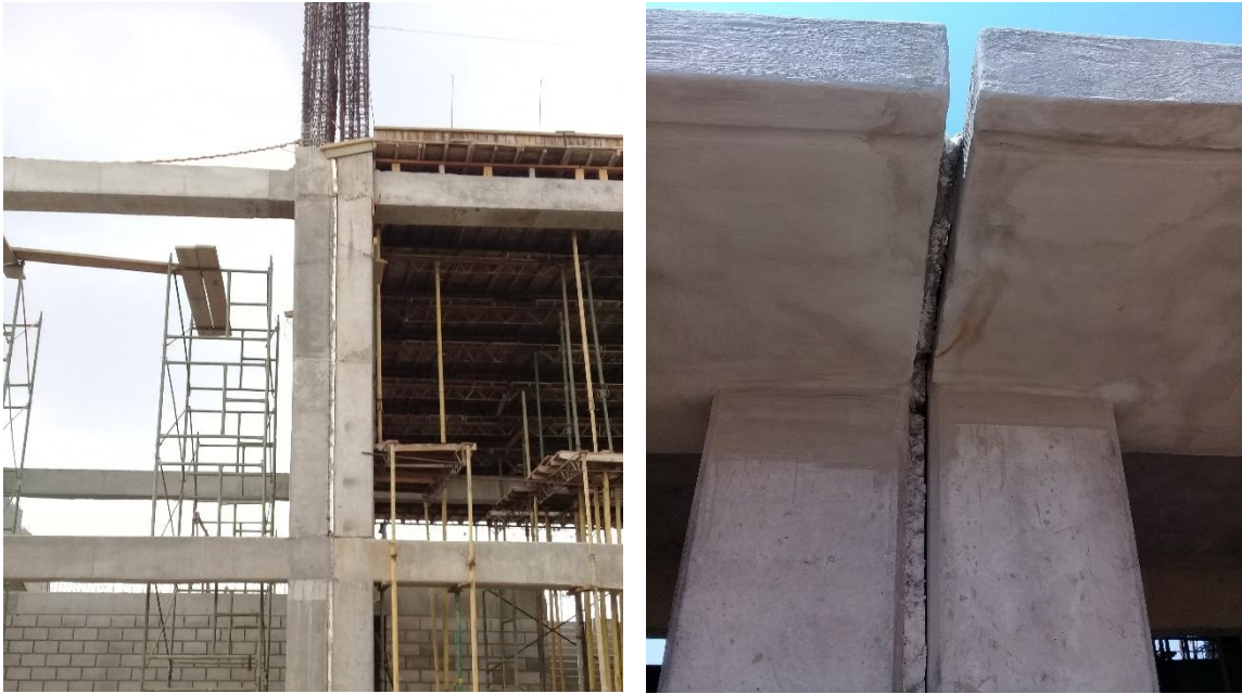
Imagen. 144. Junta de dilatación de módulos.
