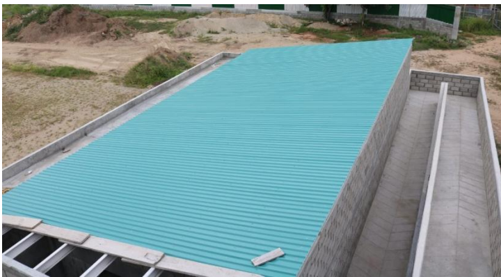
Imagen. 204. Cubierta de camerinos y sala de enfermería.
