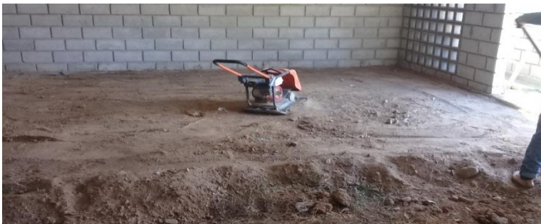
Imagen. 128. Conformación y nivelación de subestación eléctrica
