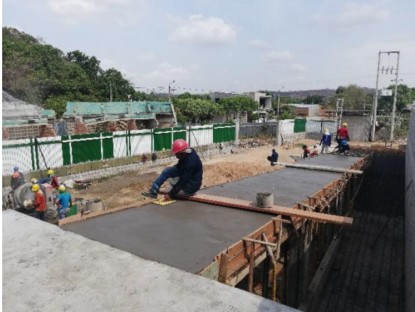
Imagen. 183. Vaciado de concreto de rampa norte.
