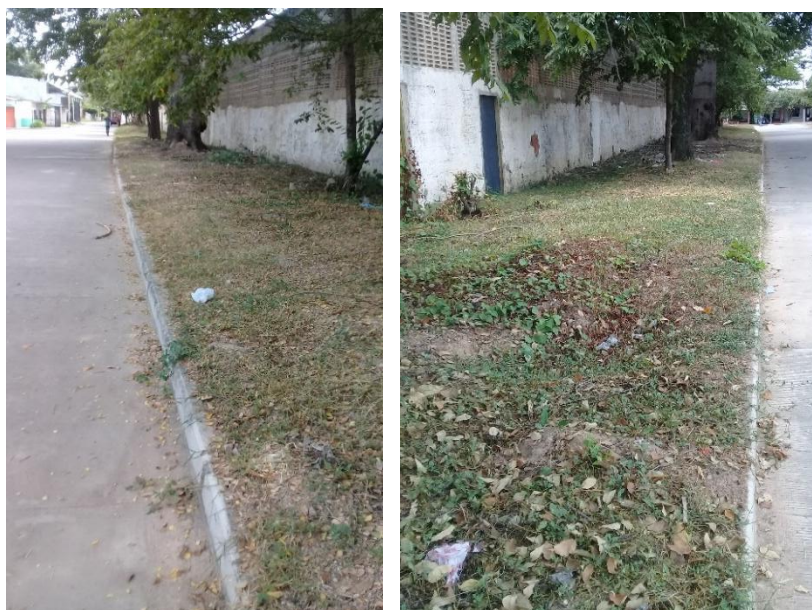
Imagen. 151. Estado del urbanismo anterior, lado occidental.
