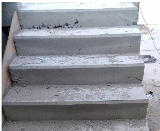
Imagen. 44. Desencofrado de escaleras de acceso a graderías
