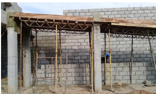
Imagen. 10. Armado de formaleta de rampa sur
