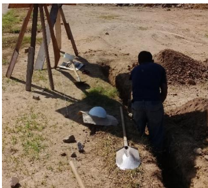
Imagen. 129. Excavación para instalación de cableado eléctrico
