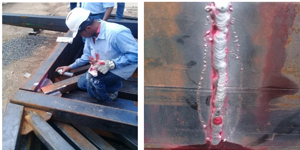
Imagen. 219. Ensayos de tinta penetrante para soldadura.
