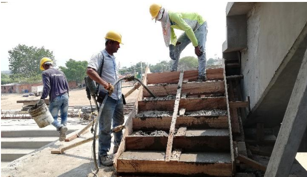
Imagen. 181. Fundida en concreto de escaleras de acceso a graderías.
