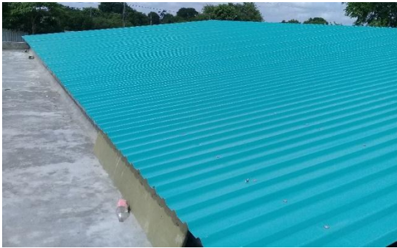
Imagen. 67. Instalación de cubierta standing seam, modulo 1, terminada.
