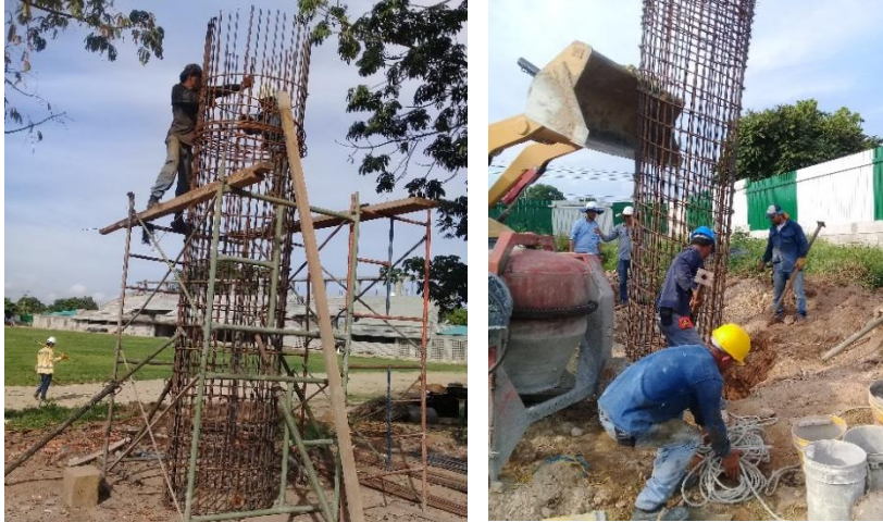
Imagen. 220. Armado e instalación de acero de refuerzo para cimentación de mástiles de iluminación.
