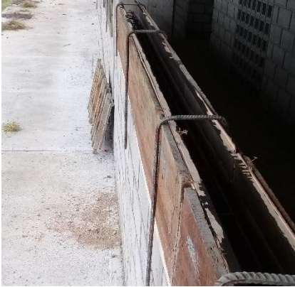
Imagen. 37. Encofrado de viga de ante pecho sobre mampostería.
