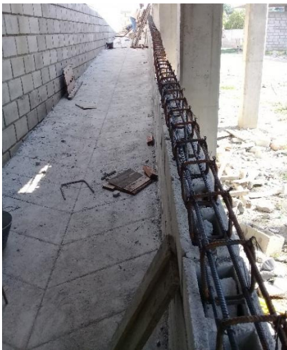
Imagen. 56. Instalación de acero de Viga de antepecho sobre mampostería, rampa sur
