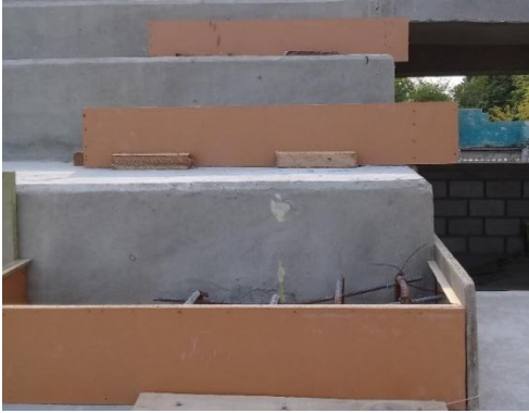
Imagen. 34. Encofrado de Escalinatas
