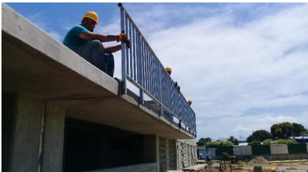
Imagen. 72. Instalación de barandas de seguridad para graderías.
