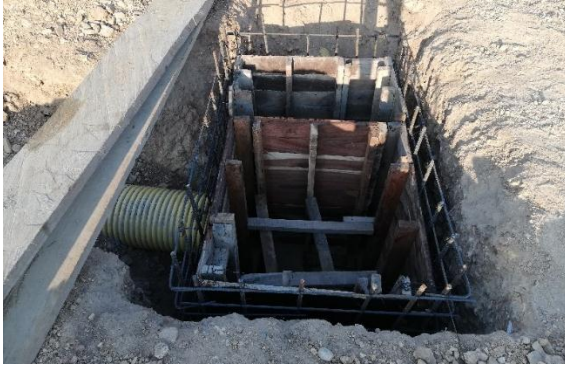
Imagen. 177. Formaletado de trampa de arena.
