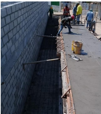
Imagen. 73. Vaciado de concreto en rampa sur
