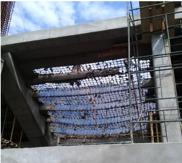
Imagen. 19. Demolición de graderías afectadas por hundimiento.
