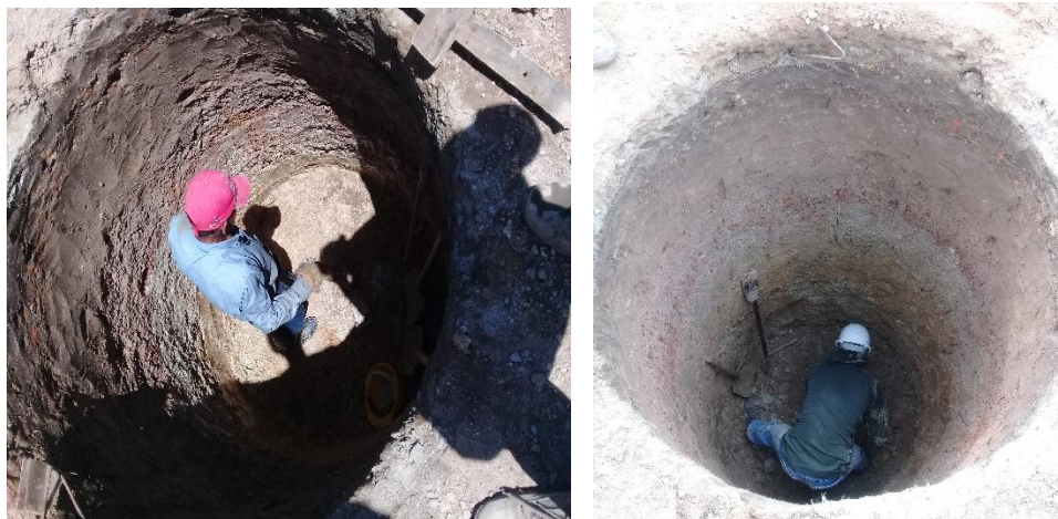
Imagen. 218. Excavación para cimentación de mástiles de iluminación.
