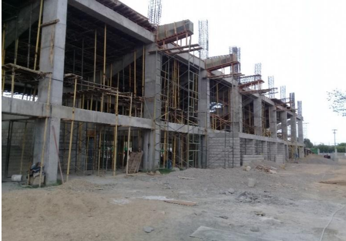
Imagen. 145. Vista inferior de estructura de Graderías
