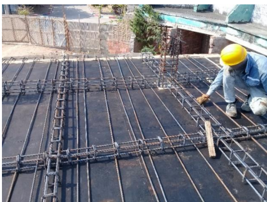
Imagen. 54. Armado de acero de refuerzo de Placa de taquilla Sur.
