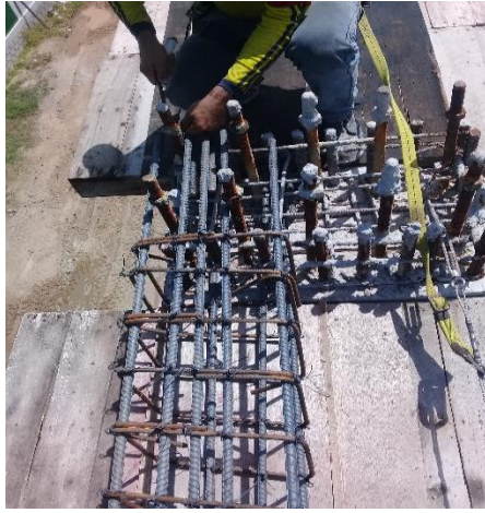
Imagen. 57. Armado de Acero Viga nivel 4 Eje 1
