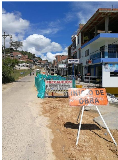
Fotografía 1 Sustitución de 325 m. lineales en tubería PVC
