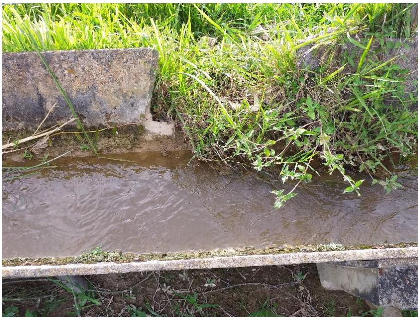
Figura 63 Daño en la pared del canal triangular en asbesto. Coordenadas 1384389.845N 1096497.915E. Punto 65.
