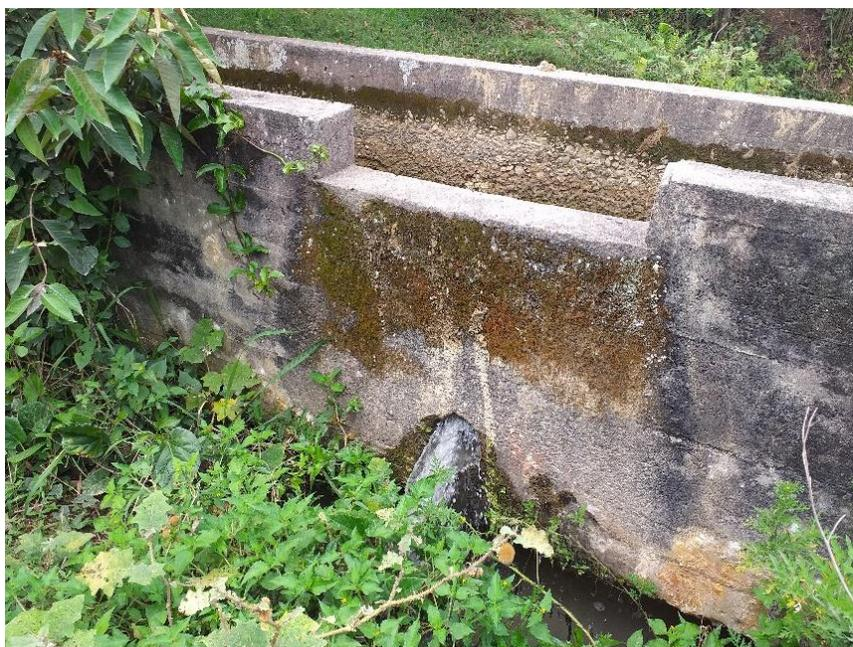
Figura 64 Daño en la pared del canal rectangular en concreto. Coordenadas 1384756.021N 1095356.415E. Punto 99.
