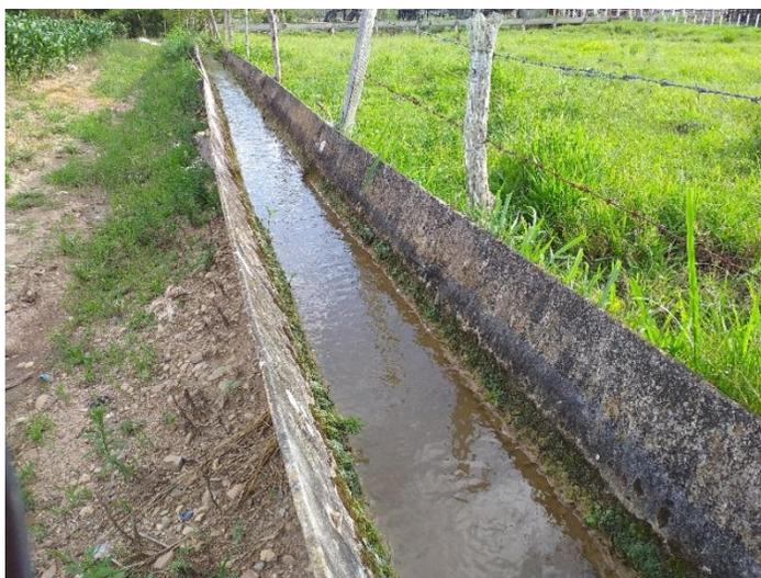
Figura 60 Canal triangular en asbesto. Coordenadas 1384435.032N 1096506.161E. Punto 66.
