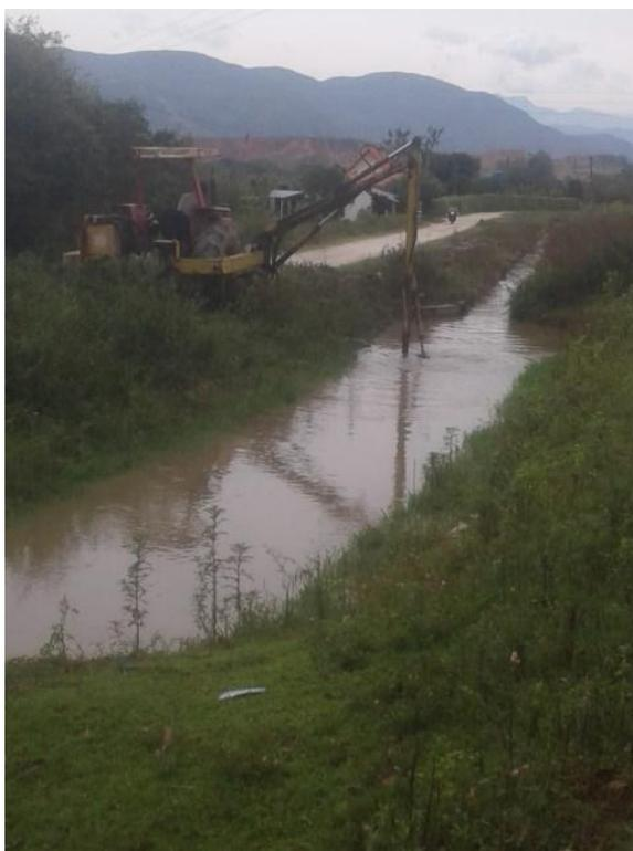
Figura 71 Limpieza para retiro de sedimentación y vegetación con equipo. Coordenadas 1384326.757N 1095559.559E. Punto 93.
