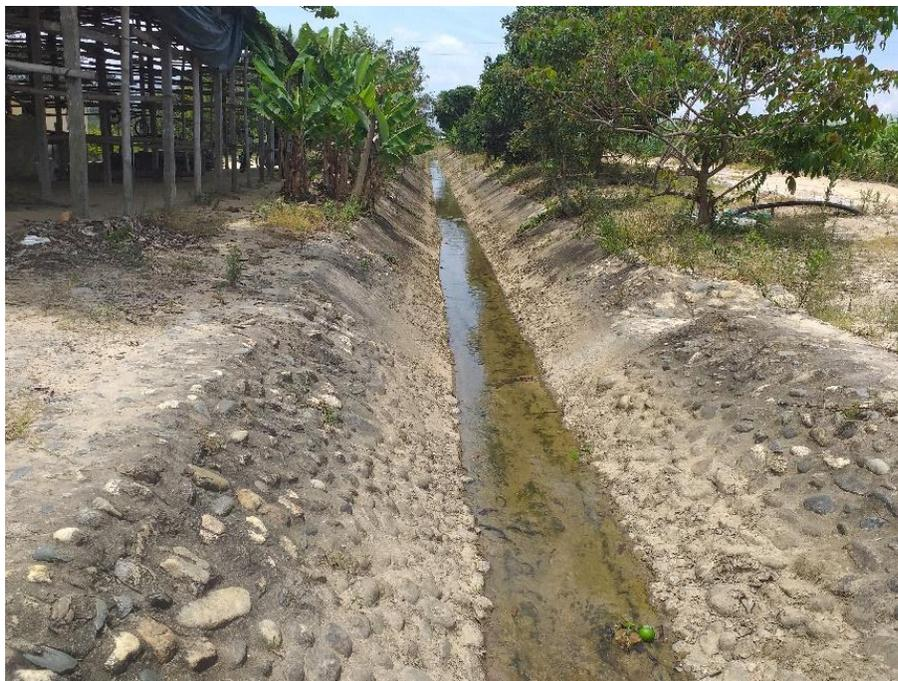
Figura 61 Canal trapezoidal en concreto ciclópeo. Coordenadas 1383955.647N 1093214.116E. Punto 52.
