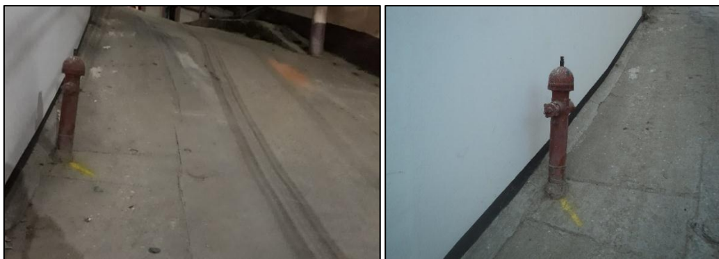
Figura 29. Hidrante del barrio San José sobre la calzada. Fuente. Autores
