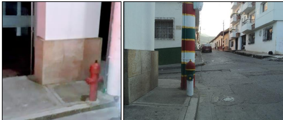
Figura 37. Hidrante de la calle 13 con carrera 12 Fuente. Autores
