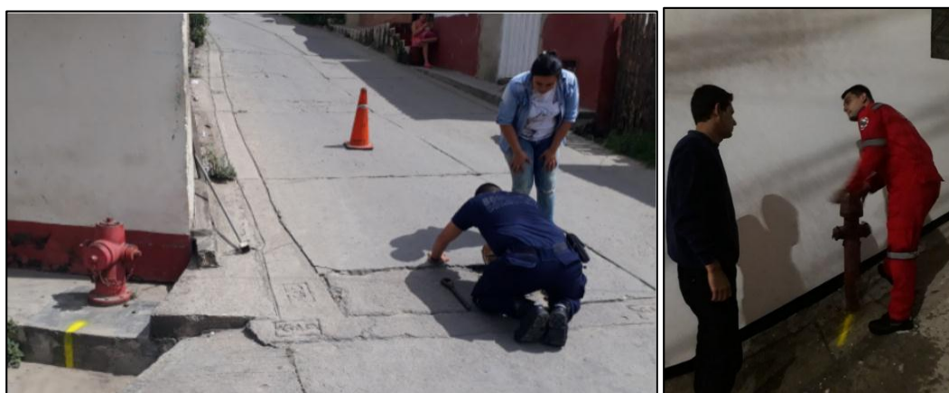
Figura 9. Inspección de hidrantes en la comuna I en compañía del cuerpo de bomberos Fuente. Autores
