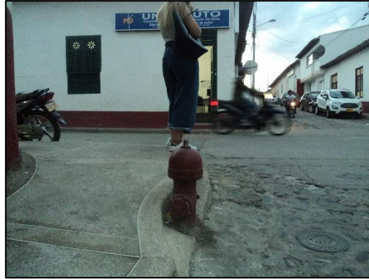
Figura 33. Hidrante de la Calle 11 con Carrera 7 Fuente. Autores
