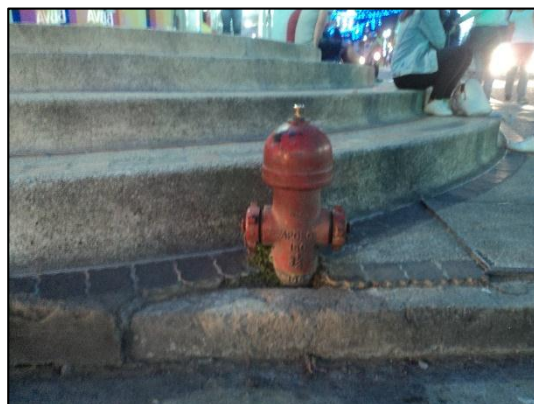
Figura 26. Hidrante en la calle 11 con carrera 13 Fuente. Autores
