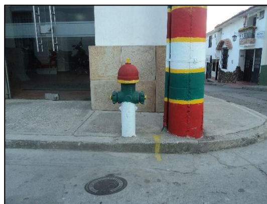
Figura 28. Hidrante en la calle 13 con carrera 12 Fuente. Autores
