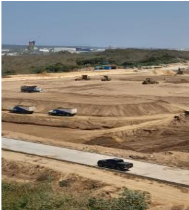
Figura 25 Conformación de terrazas
