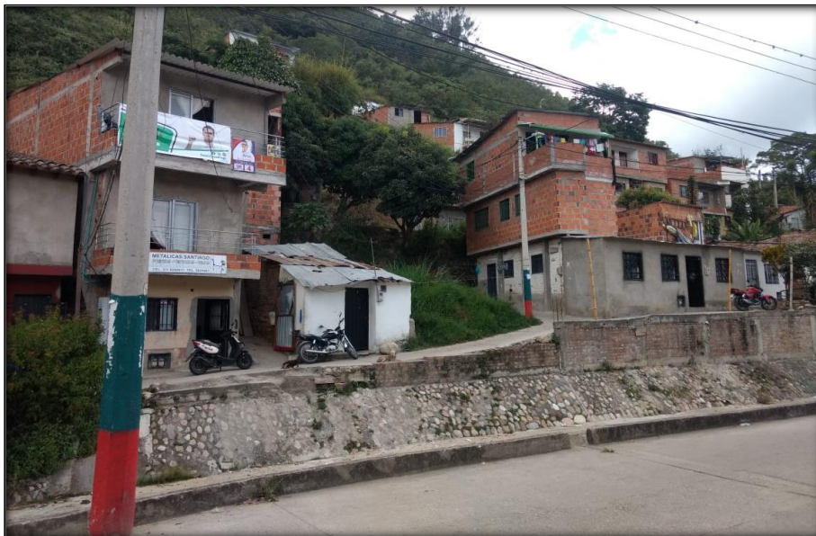
Figura 45. Golpeteo en las esquinas
