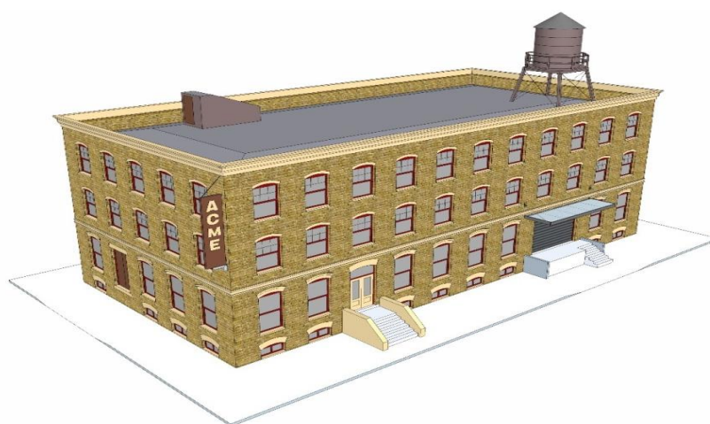
Figura 28. Edificación con potencial amenaza de caída de elementos no estructurales
