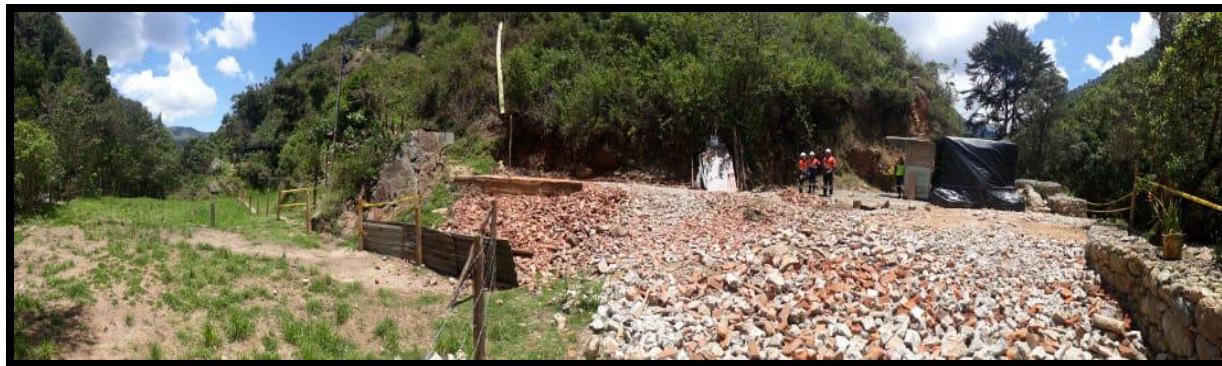
Figura 10. Recuperación Edificaciones de Servicios y Bodegas
