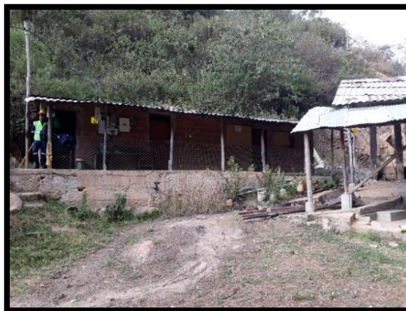
Figura 9. Edificaciones de Servicios y Bodegas
