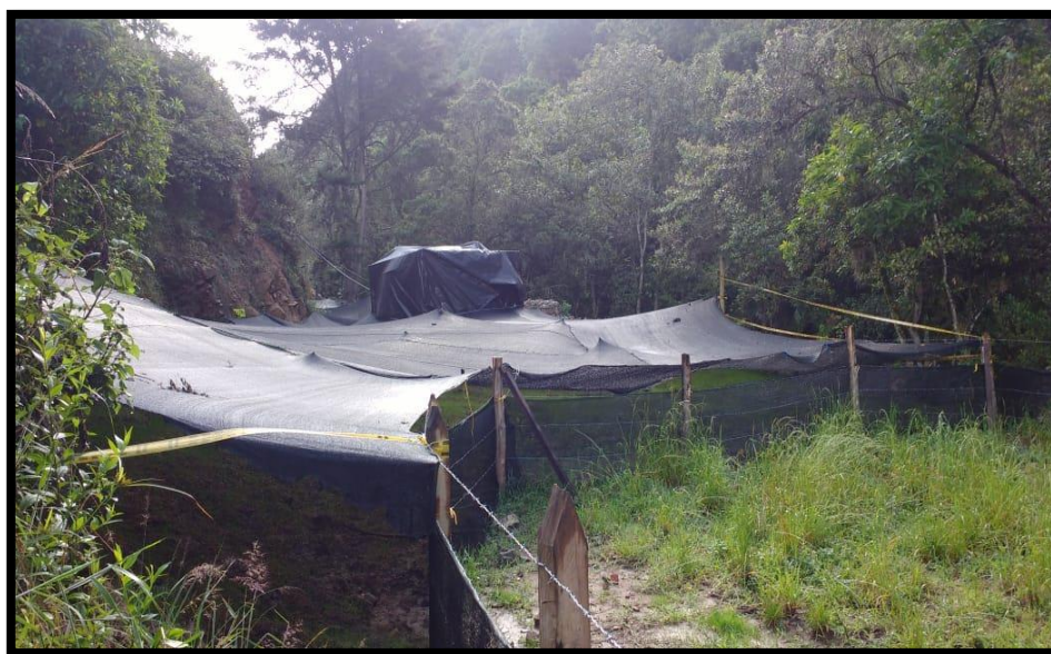
Figura 12. Recuperación Área de Trituración y Molienda
