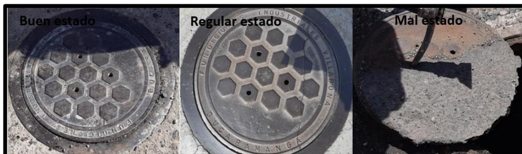
Figura 37. Clasificación del estado de las tapas de los pozos de inspección
