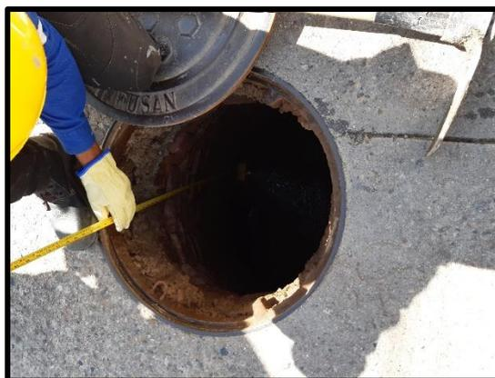
Figura 41. Medida de la profundidad de los pozos de inspección. Fuente. Autor
