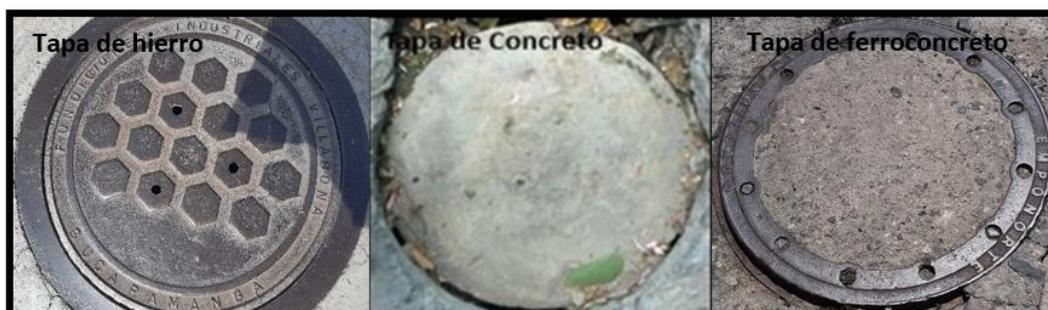
Figura 36. Tipo de material de las tapas de pozos de inspección. Fuente. Autor
