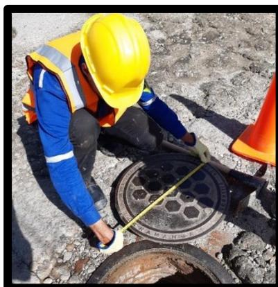
Figura 35. Medida del diámetro de las tapas de los pozos de inspección.
