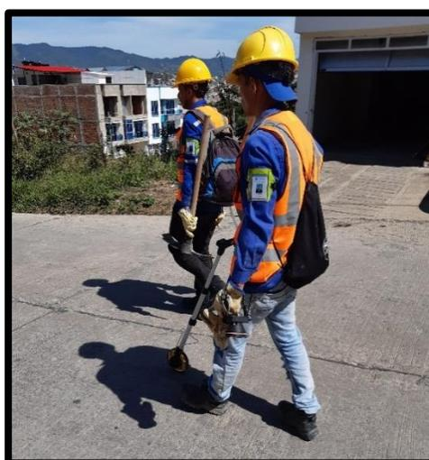
Figura 43. Medida de las longitudes de los tramos de tubería con el odómetro de distancia. Fuente. Autor
