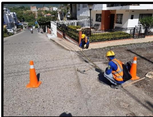
Figura 34. Medida de las distancias de referencias para la ubicación de los pozos de inspección.
