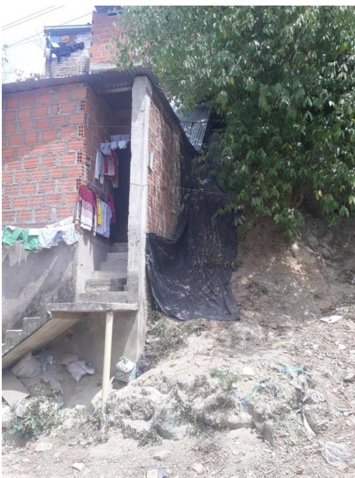
**Figura 41.** Talud cubierto con plástico santa cruz.
