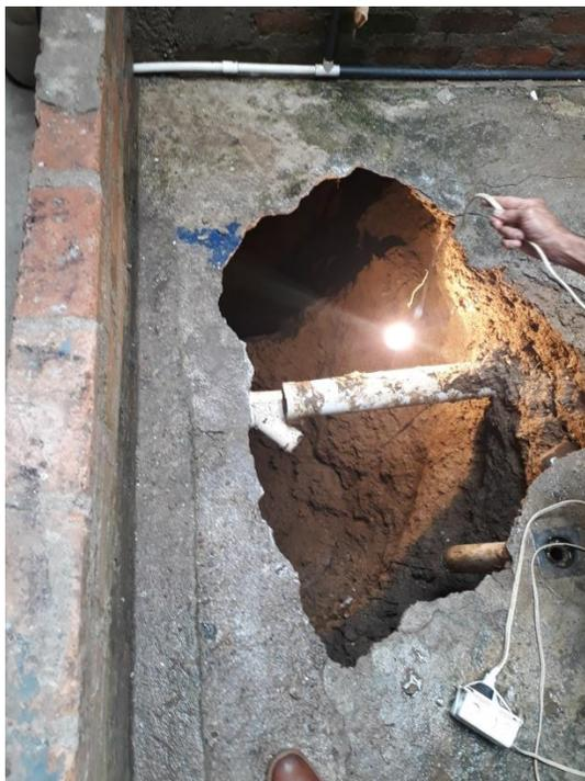
**Figura 13.** Socavación patio de la vivienda.
