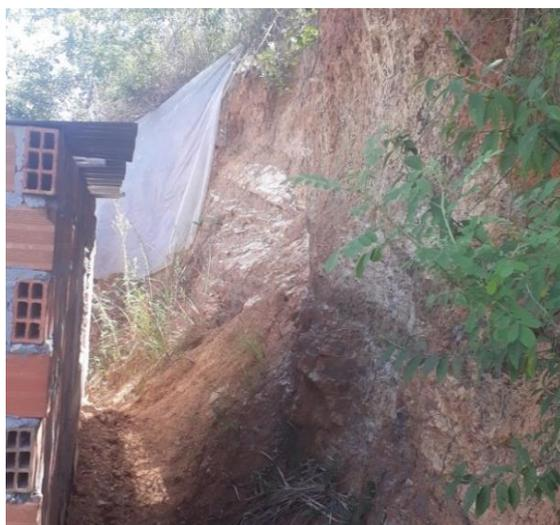
**Figura 33.** Deslizamiento de talud Betania.
