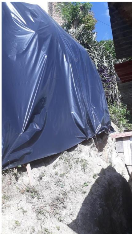
**Figura 35.** Talud cubierto con plástico Carmen.
