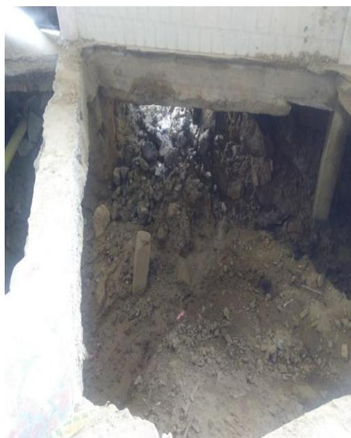
**Figura 20.** Profundidad aproximada de la socavación.
