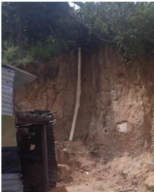
**Figura 31.** Deslizamiento de talud de tipo rotacional.
