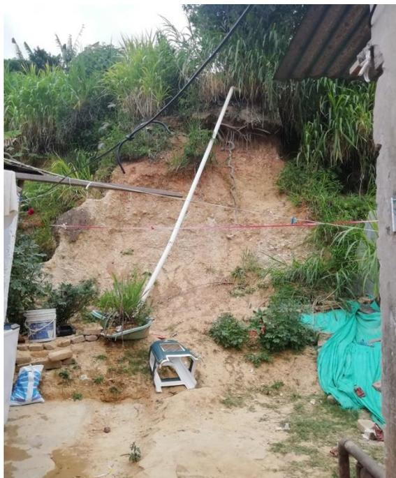
*Figura 45.* Talud propenso a deslizamiento.
