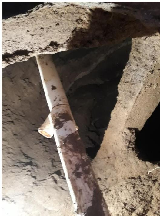
**Figura 14.** Tubería de alcantarillado sanitario.
