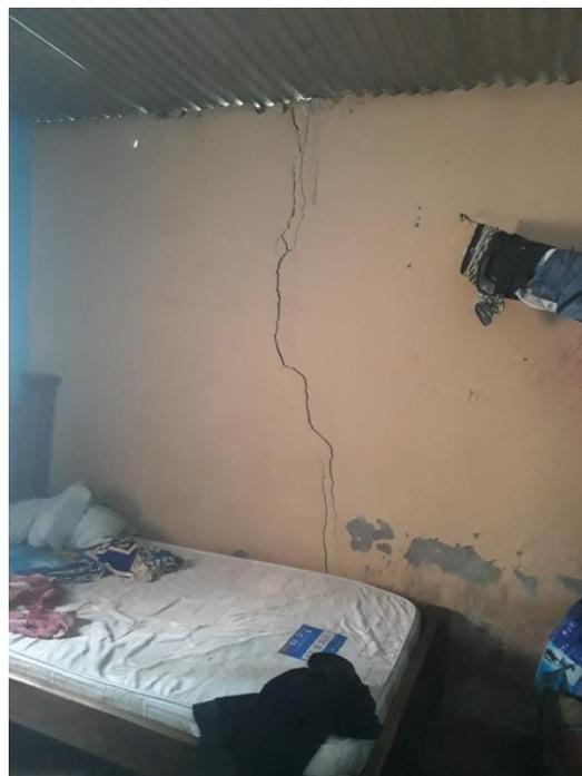
**Figura 40.** Agrietamiento en muro de vivienda Fundadores.
