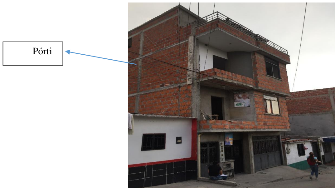
Figura 11 Tipo de construcción de viviendas RM1.
