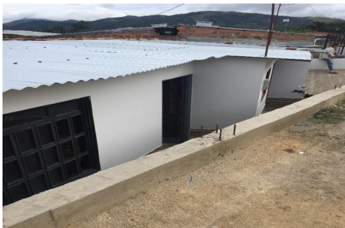
Figura 13 Vivienda bajo el nivel del terreno. Fuente: Autores.
