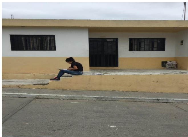
Figura 7 Irregularidad en planta, con retrocesos en las esquinas. Fuente: Autores
