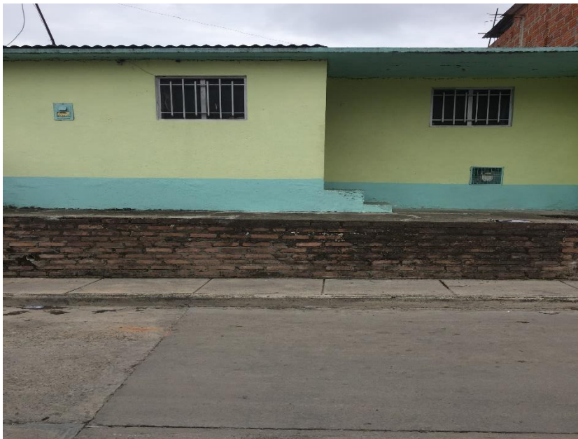
Figura 15 Irregularidad en planta con retrocesos en las esquinas Fuente: Autores.
