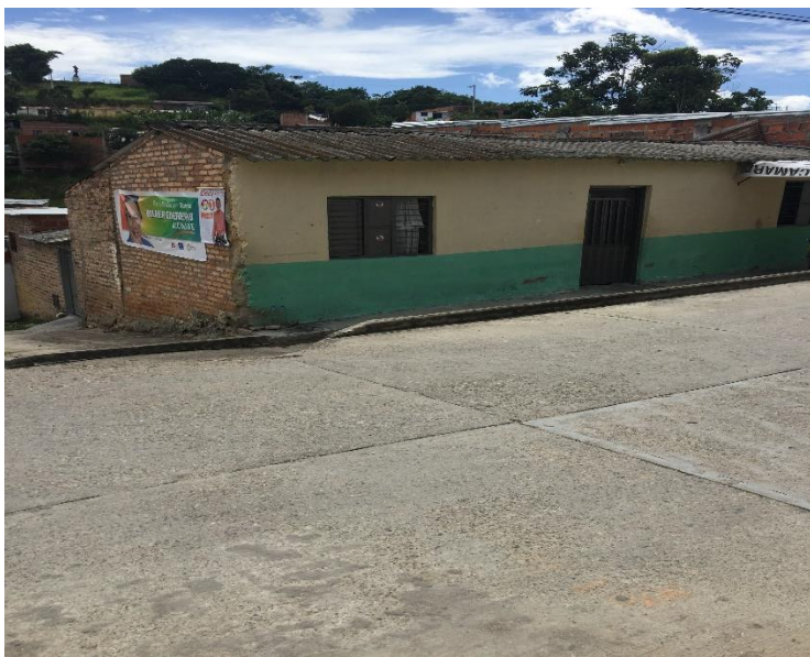
Figura 10 Vivienda con tipo de construcción URM
