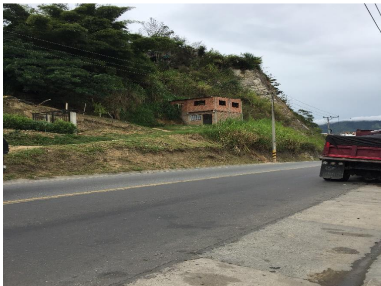
Figura 4 Vivienda con peligro de deslizamiento.
