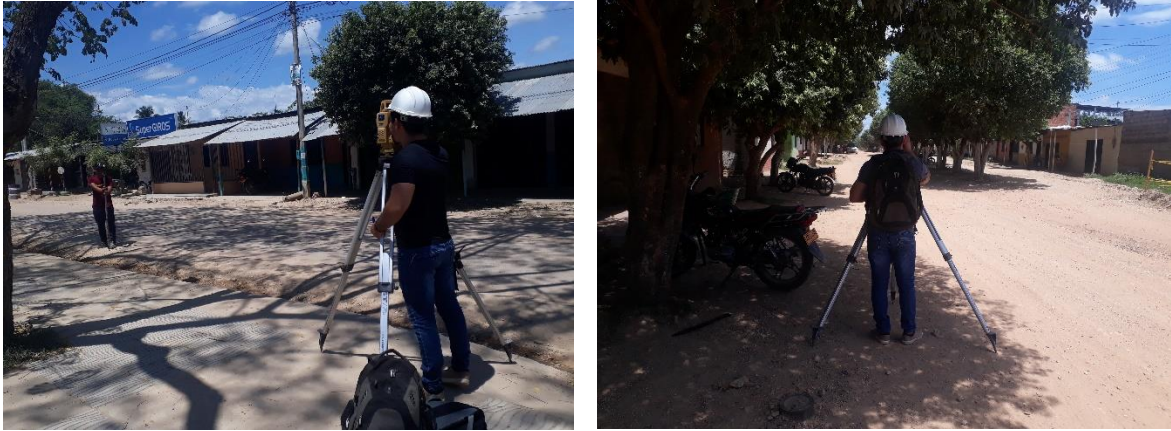
Fotografía 8. Elaboración del levantamiento topográfico Fuente: Autores del proyecto
