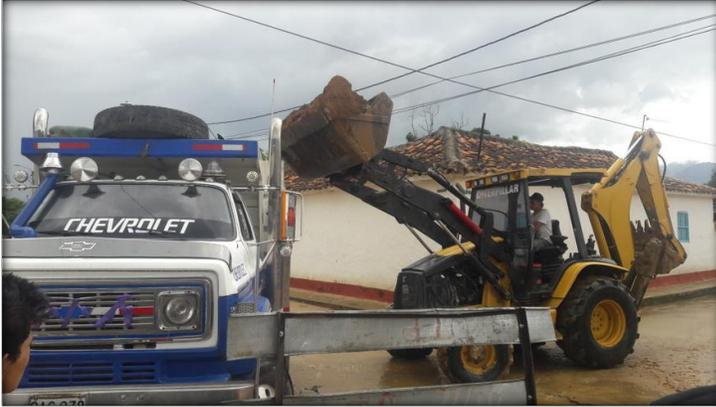
**Figura 60. Retiro de material sobrante de la sub-rasante.**
