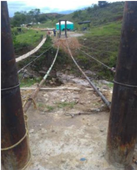
**Figura 16. Suministro e instalación de viga transversal en tubería de 3'' x 1/4.**
