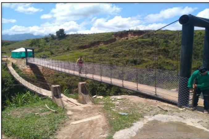
**Figura 21. Instalación de pasamanos de seguridad en lámina eslabonada.**
