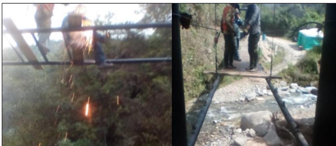
**Figura 19. Instalación de las péndolas y vigas transversales metálicas.**
