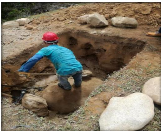
**Figura 11. Excavación Manual.**
