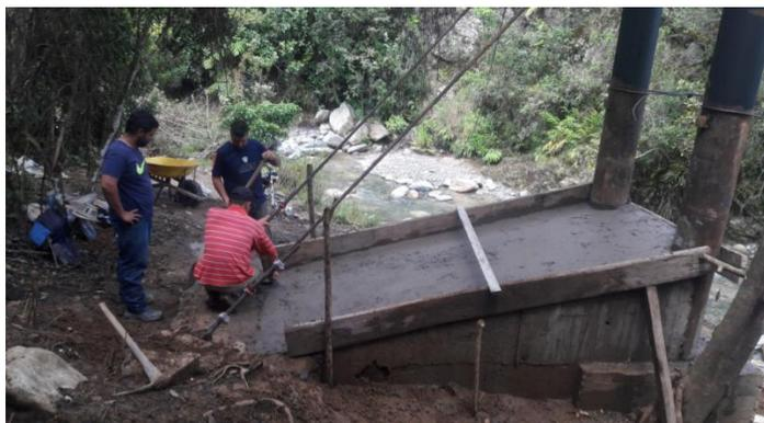
**Figura 26. Fundición de las rampas de acceso.**
