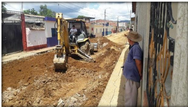
**Figura 59. Nivelación de la calzada existente.**
