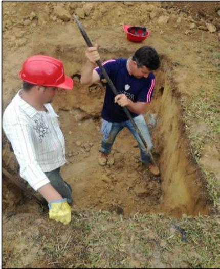
**Figura 10. Excavación Manual.**
