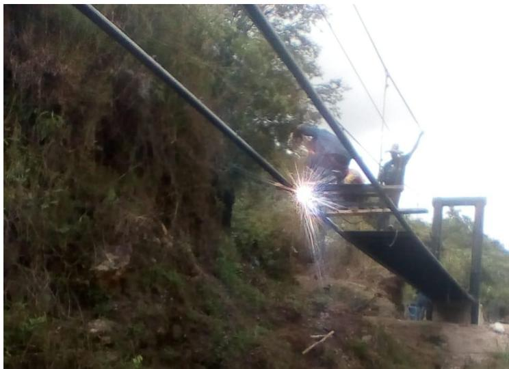
**Figura 27. Instalación de vigas transversales, ángulo de refuerzo y piso en lamina alfajor.**
