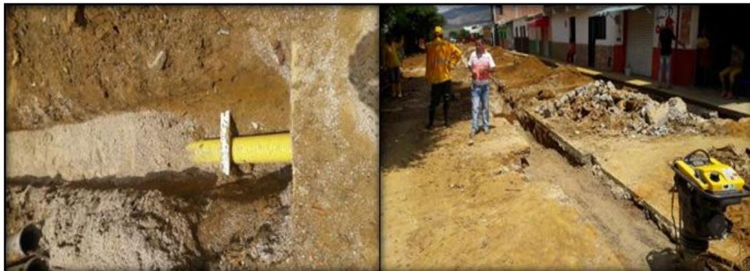
**Figura 47. Cama de arena en las acometidas y tubería principal.**
