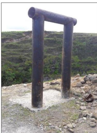
**Figura 15. Columnas y vigas de la estructura del puente.**
