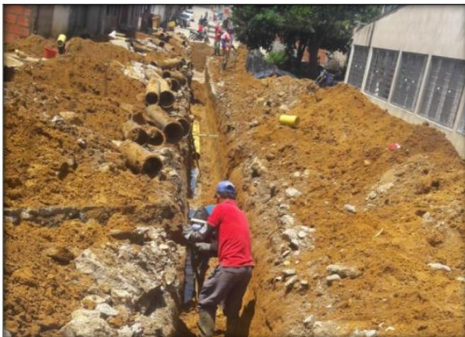
**Figura 43. Cambio de tubería vieja a tubería PAVCO Novafort de 8”.**
