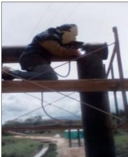
**Figura 14. Soldadura de la viga transversal metálica en tubería 12"x 5/16 Sch 40.**
