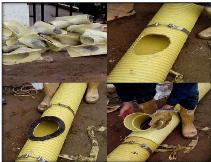
**Figura 44. Proceso de Instalación de Sillas Yee.**
