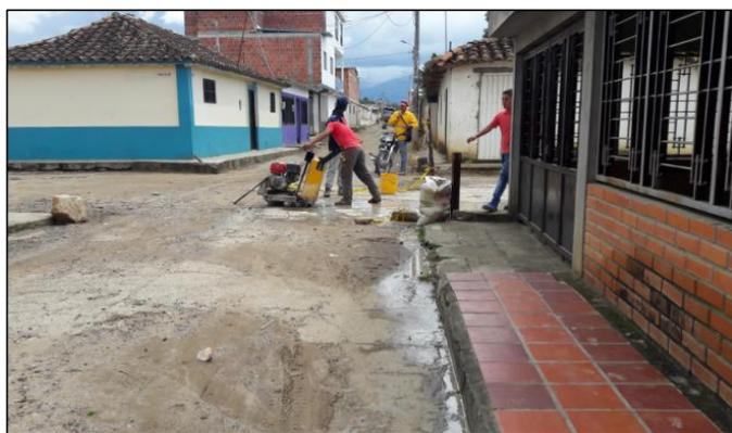
**Figura 38. Realización de cortes al pavimento existente.**
