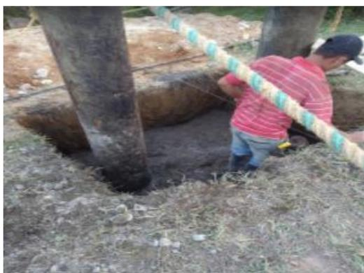
**Figura 24. Fundición de las columnas en concreto de 3000 Psi.**
