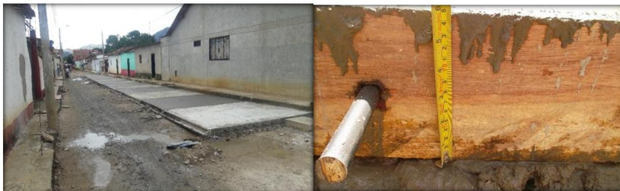
**Figura 64. Instalación barras de unión y verificación del espesor del concreto.**
