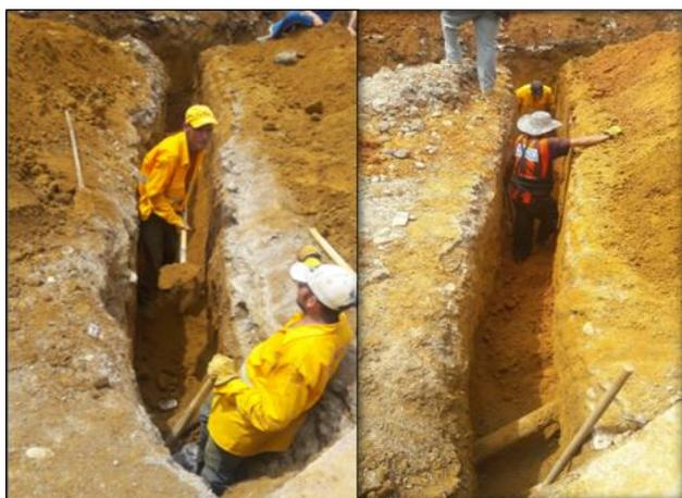
**Figura 42. Excavación Manual red principal y acometidas de Alcantarillado.**
