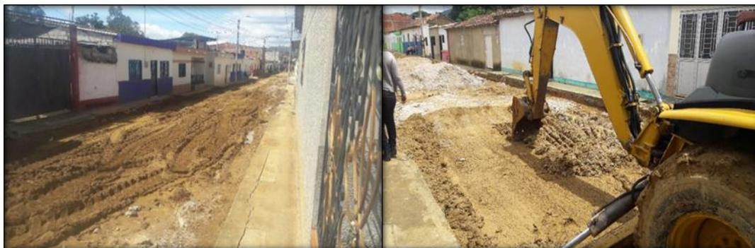
**Figura 69. Secado de la sub-rasante.**
