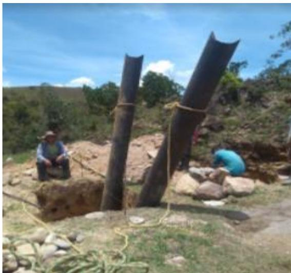
**Figura 23. Instalación de la tubería de 12" x 5/16 para las columnas.**
