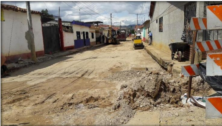
**Figura 61. Instalación y suministro de sub-base granular.**
