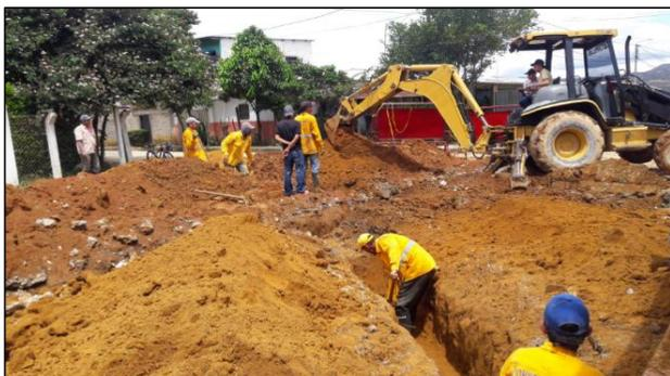
**Figura 41. Excavación mecánica acometidas red de alcantarillado.**
