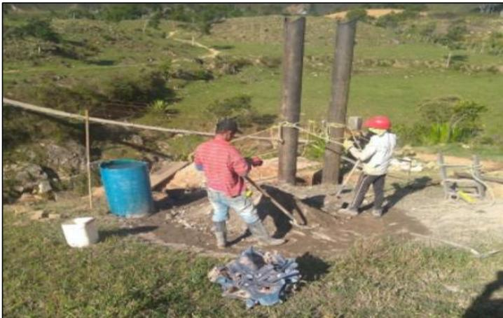
**Figura 13. Alineación de los ejes de la columna Metálica para fundir.**
