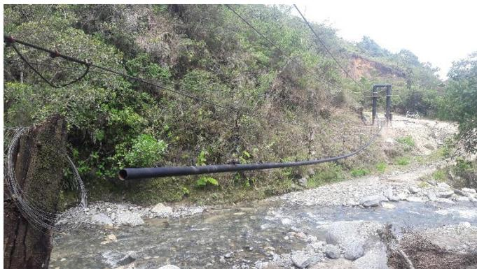
**Figura 25. Instalación de vigas longitudinales en tubería de 3" x 1/4.**
