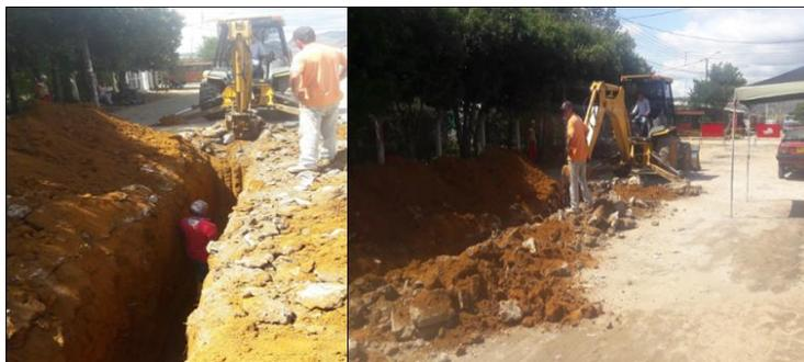
**Figura 39. Excavación mecánica red principal de Alcantarillado.**
