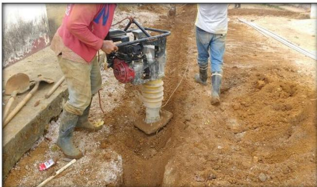
**Figura 52. Compactación con material de excavación.**
