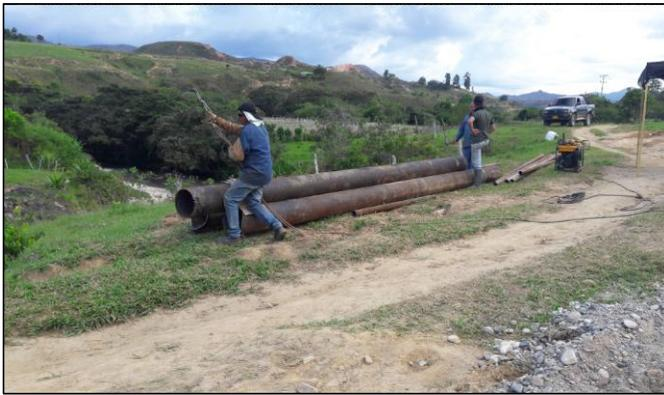
**Figura 12. Cortes de la tubería de 12"x 5/16 Sch 40.**
