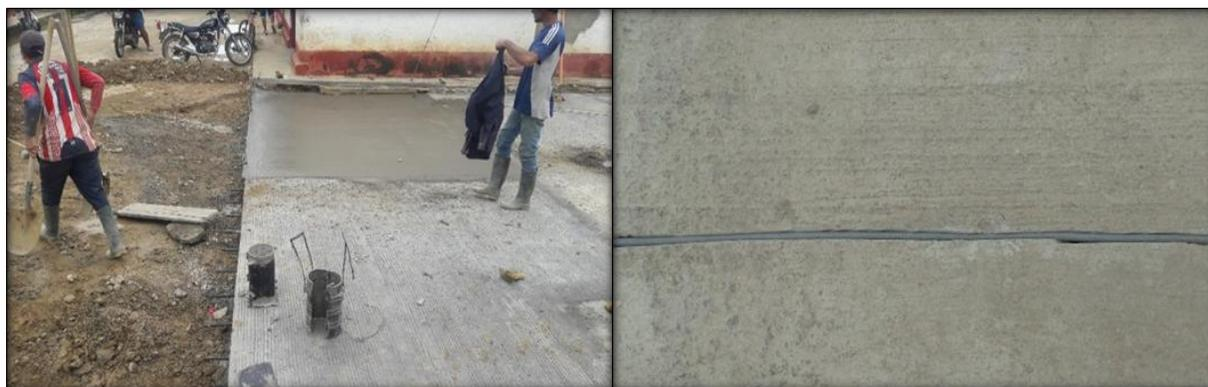
**Figura 65. Toma de cilindros e instalación cordón de espuma en juntas de dilatación.**
