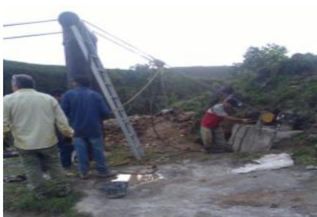
**Figura 17. Instalación de la Guaya principal 3/4" en acero a los anclajes.**
