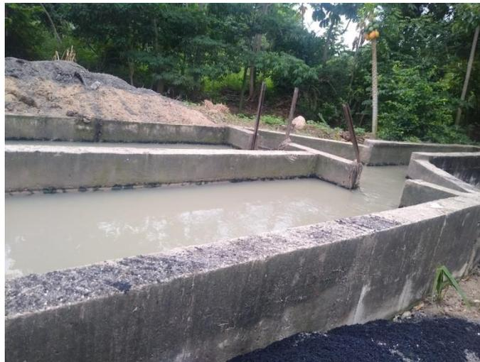
*Figura 56. Desarenadores sin compuertas.*
