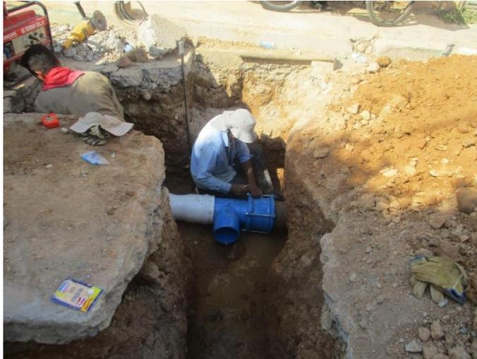
*Figura 107. Instalación de accesorios en tubería existente*
