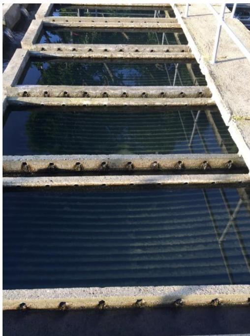
*Figura 22. Sedimentador en funcionamiento.*
