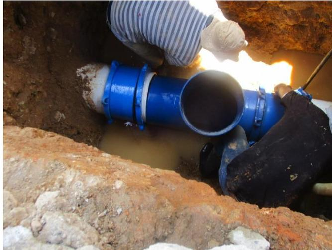
*Figura 91. Instalación de accesorios en tubería nueva*
