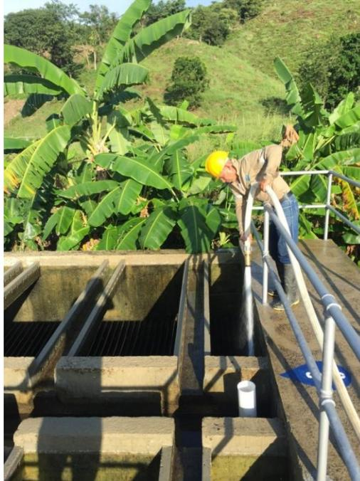
*Figura 24. Lavado de Sedimentador con manguera a presión.*
