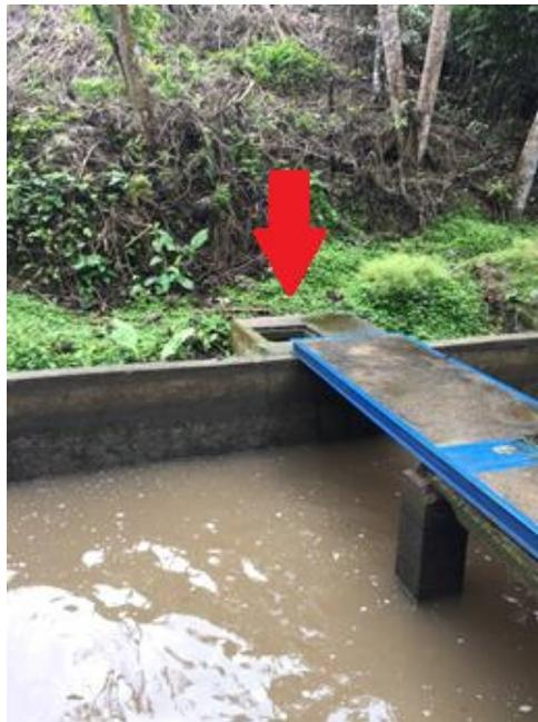
*Figura 4. Sistema de recolección de agua de rebose en el desarenador 1.*
