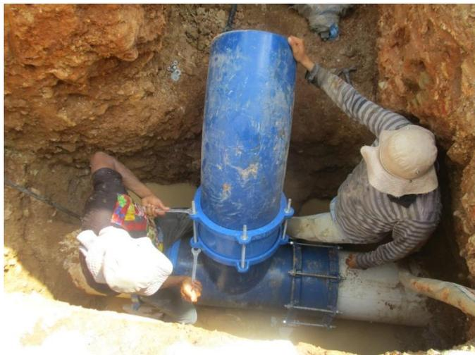
*Figura 92. Instalación de accesorios en tubería nueva de empalme H*
