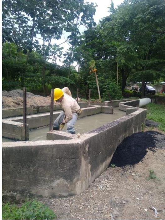
*Figura 57. Mantenimiento realizado a los desarenadores.*
