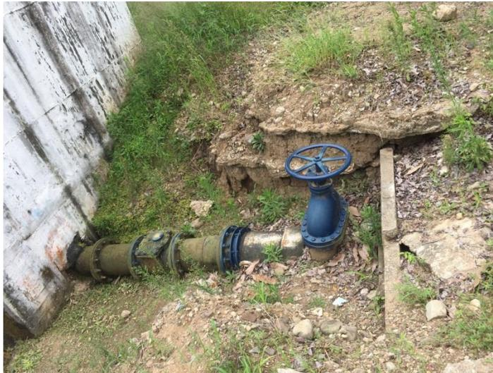
*Figura 7. Macro medidor existente 1 fuera del funcionamiento.*
