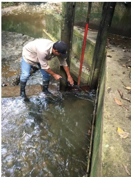
*Figura 10: limpieza a rejilla de bocatoma.*
