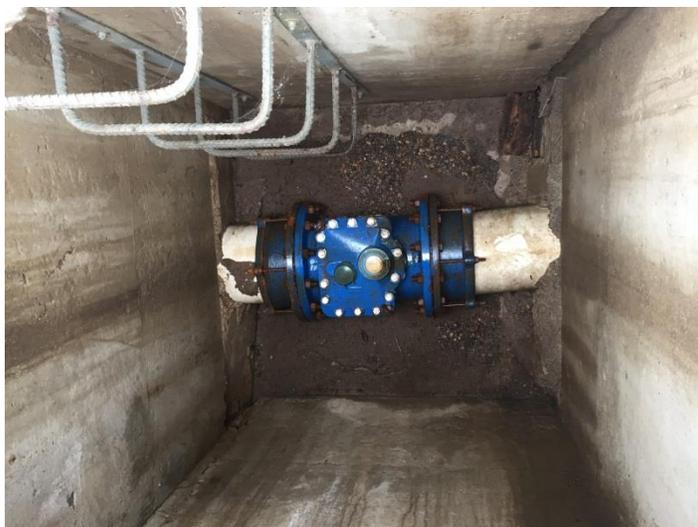
*Figura 8. Macro medidor existente 2 fuera de funcionamiento.*
