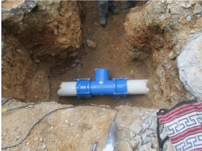
*Figura 113. Corte e instalación de accesorios en tubería nueva*
