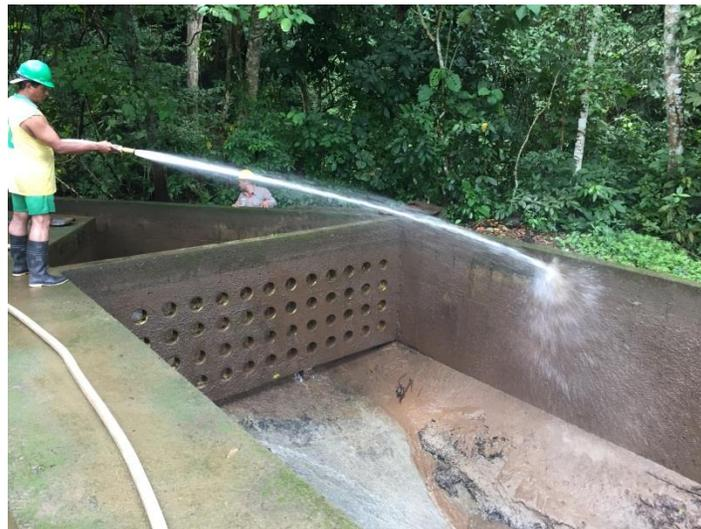
*Figura 15. Lavado de desarenador con manguera a presión.*
