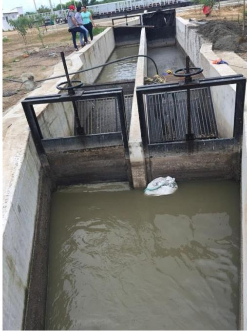
*Figura 64. entrada al desarenador con rejillas de cribado.*
