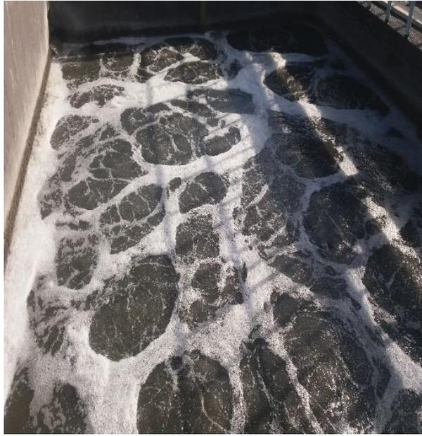
*Figura 69. Tanque de aireación.*
