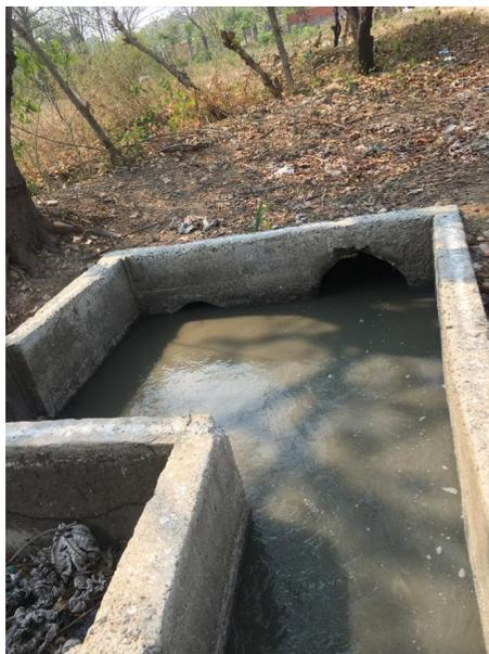
*Figura 37. Tubería de llegada de aguas residuales.*
