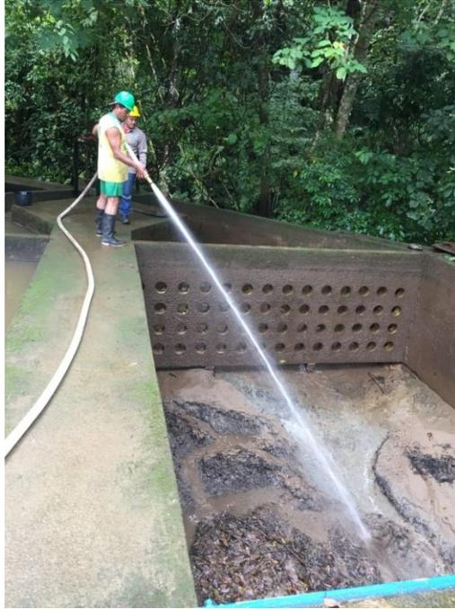
*Figura 16. Lavado de desarenador con manguera a presión.*
