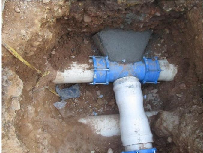
*Figura 102. Anclaje de seguridad en accesorios.*
