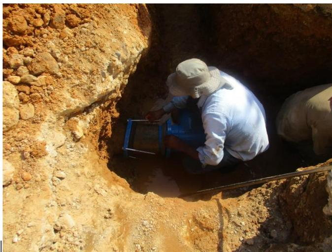
Figura 106. Corte de tubería de asbesto cemento e instalación de accesorios
