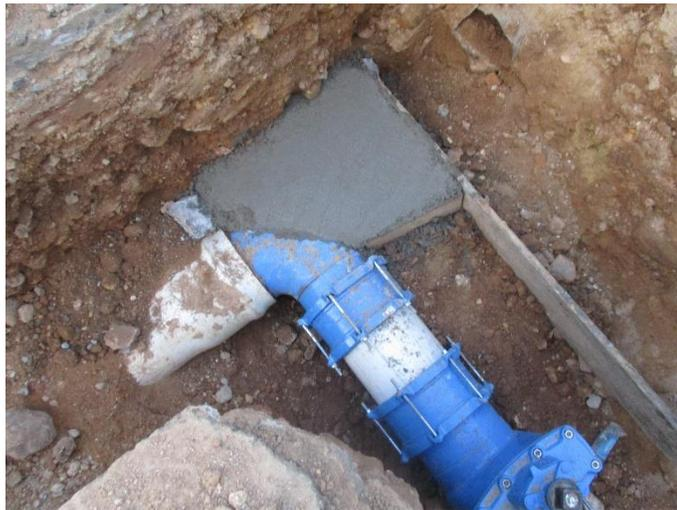
*Figura 103. Accesorios de empalme #5 con anclaje de seguridad.*
