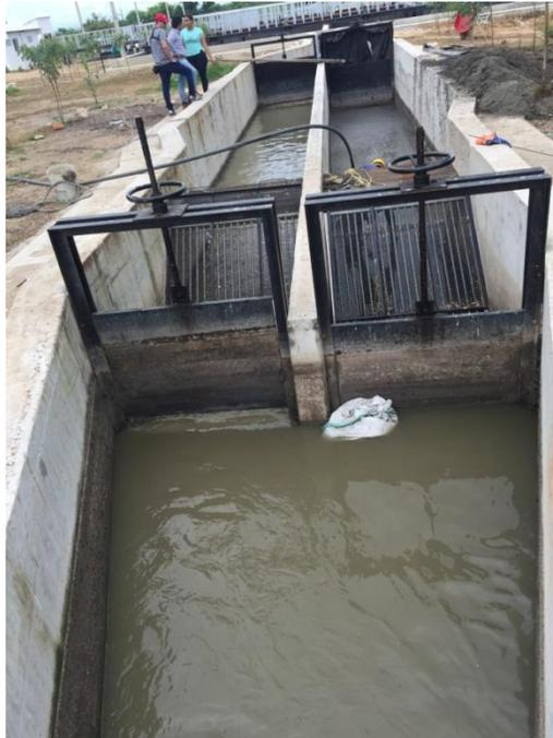
*Figura 44. Compuertas de entrada a los desarenadores.*
