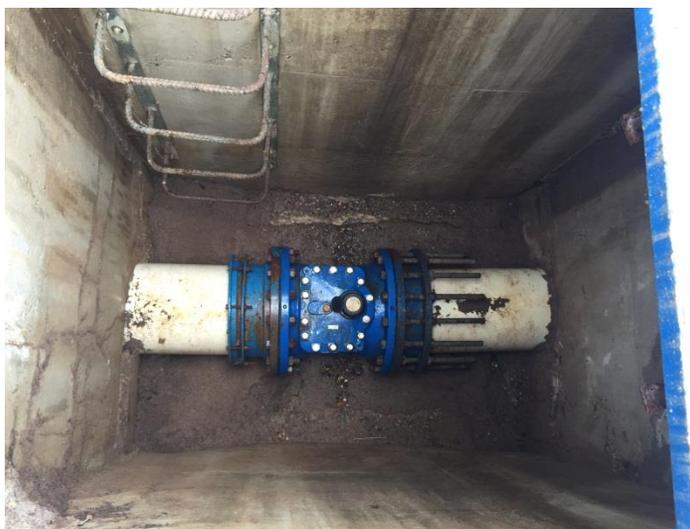
*Figura 9. Macro medidor existente 3 fuera de funcionamiento.*
