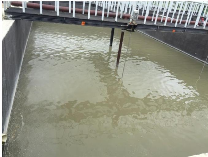
*Figura 47. Tanque de homogeneización.*
