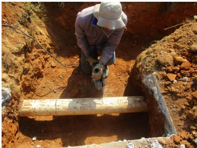
*Figura 78. Corte con sierra de tubería existente*
