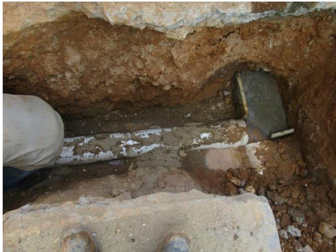
*Figura 112. Anclaje de seguridad en cambio de dirección*
