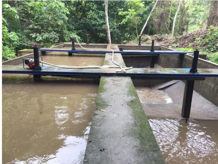
*Figura 14. Desagüe de desarenador.*
