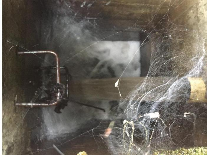
*Figura 5. Llegada de agua en sistema de rebose sin inclinación.*
