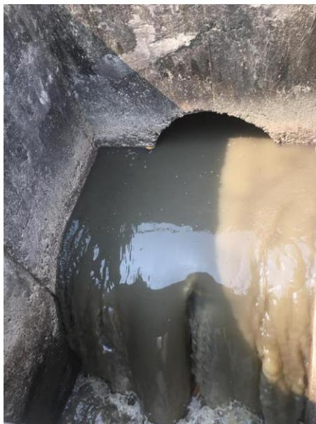
*Figura 39. Caja de mezcla de homogeneización.*
