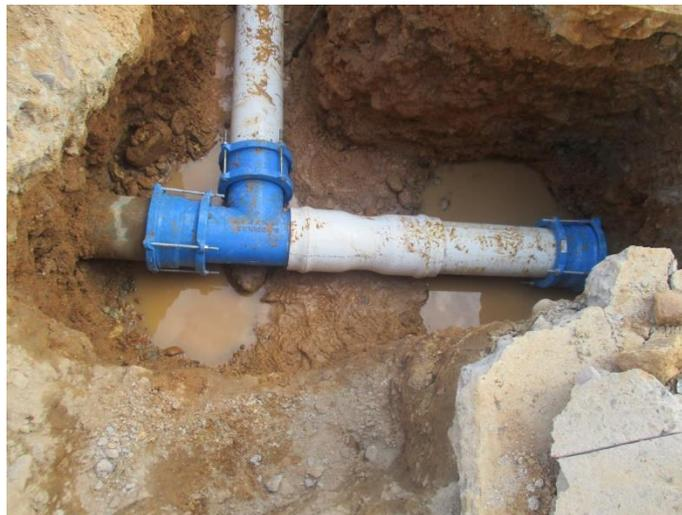
*Figura 110. Accesorios conectados en tubería existente*
