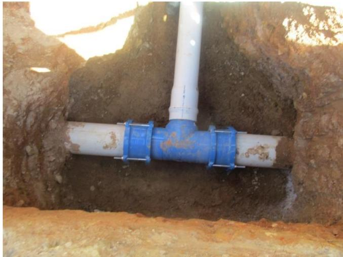
*Figura 82. Accesorios instalados en tubería nueva para empalme N° 1*
