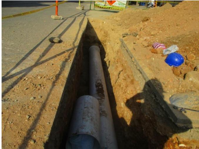
*Figura 87. Continuación de tubería de empalme H*
