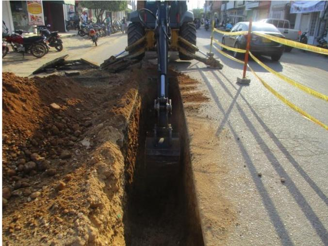
*Figura 85. Excavación de zanja para instalación de accesorios de empalme H*
