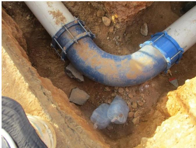
*Figura 96. Accesorios en tubería nueva de empalme H*
