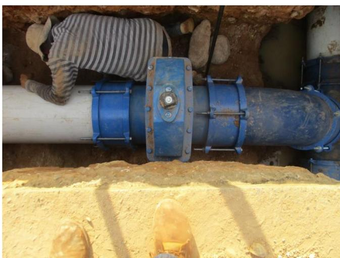
*Figura 94. Accesorios en tubería nueva de empalme H*
