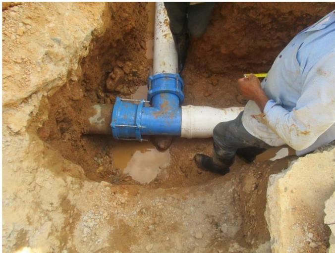
*Figura 108. Accesorios conectados a tubería existente*
