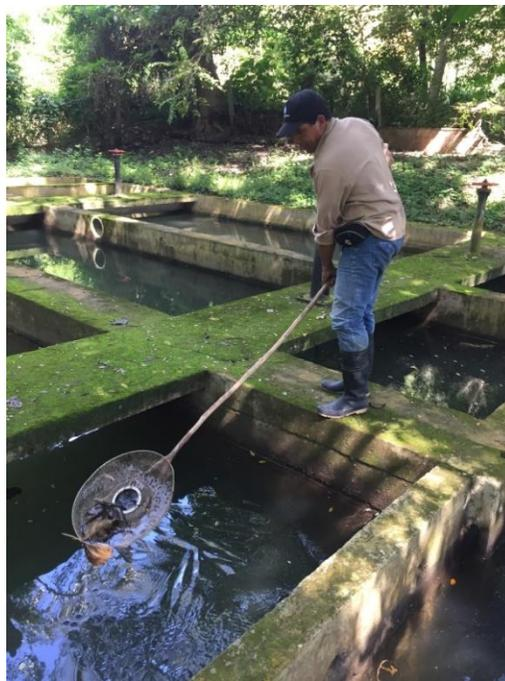
*Figura 12. Retiro de material superficial en los desarenadores.*
