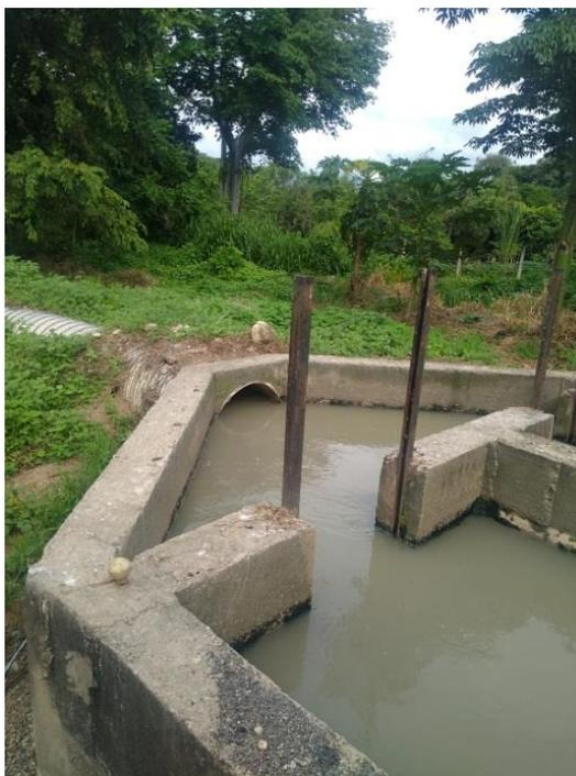
*Figura 53. Salida del caudal de los desarenadores.*
