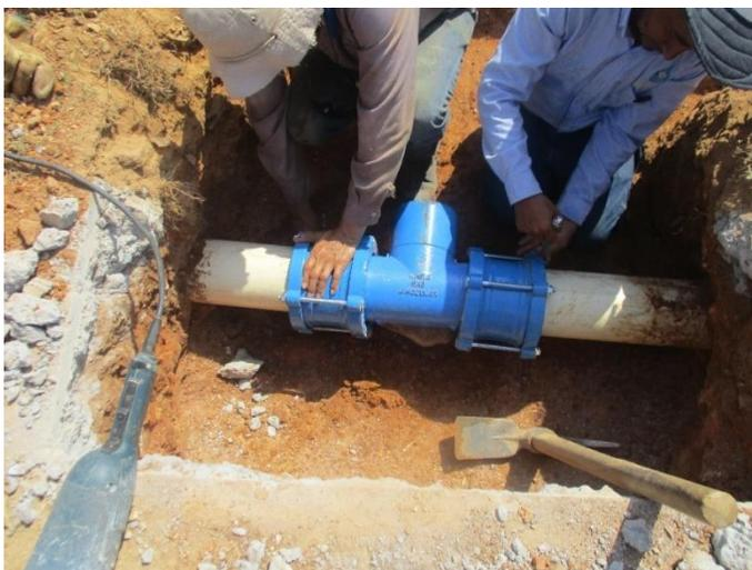
*Figura 79. Instalación de accesorios en tubería existente*
