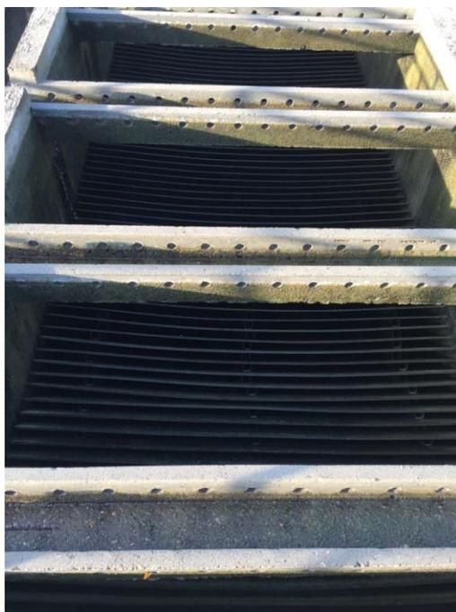
*Figura 23. Sedimentador desocupado.*
