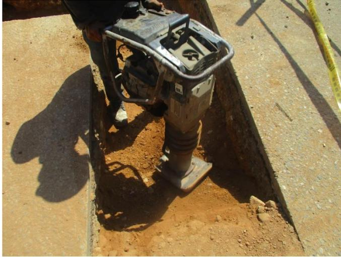
*Figura 99. Compactación de material de relleno de empalme H*
