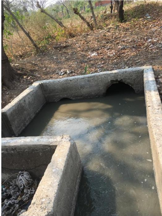
*Figura 51. Tubería de llegada de caudal de aguas residuales.*
