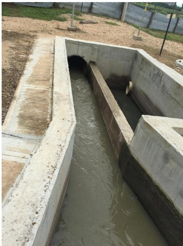
*Figura 42. Tubería de entrada de agua residual.*
