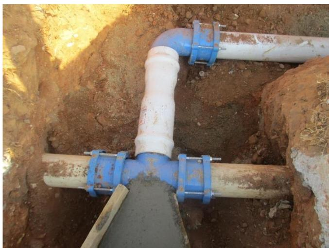
*Figura 80. Accesorios instalados en nueva tubería para empalme N°1 con tubería existente*
