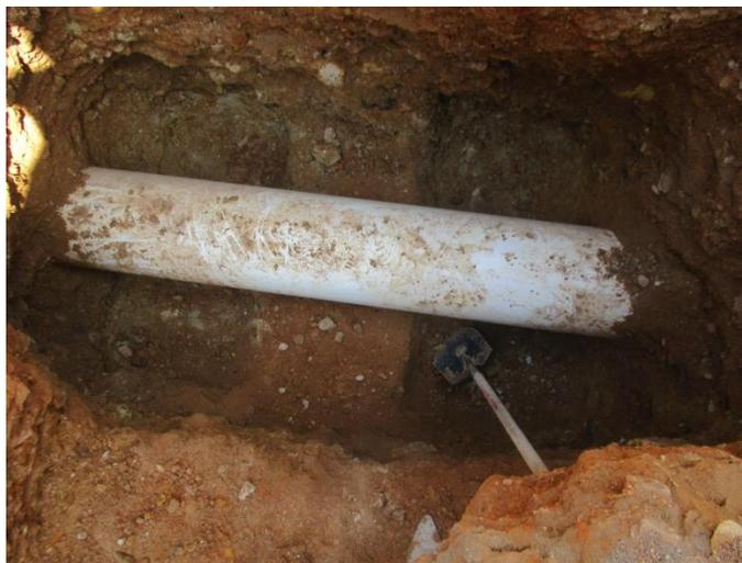
*Figura 90. Tubería nueva donde se conecta el empalme H*
