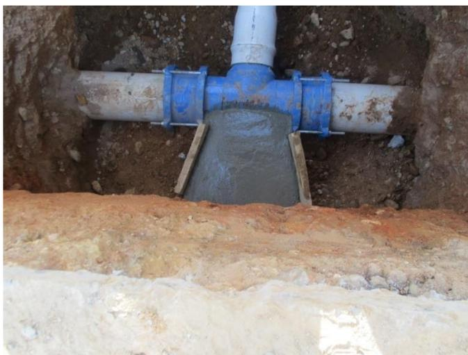
Figura 83. Anclaje de seguridad en ubicación de accesorios
