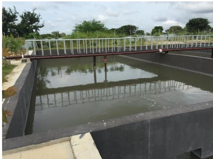
*Figura 48. Sedimentador primario.*
