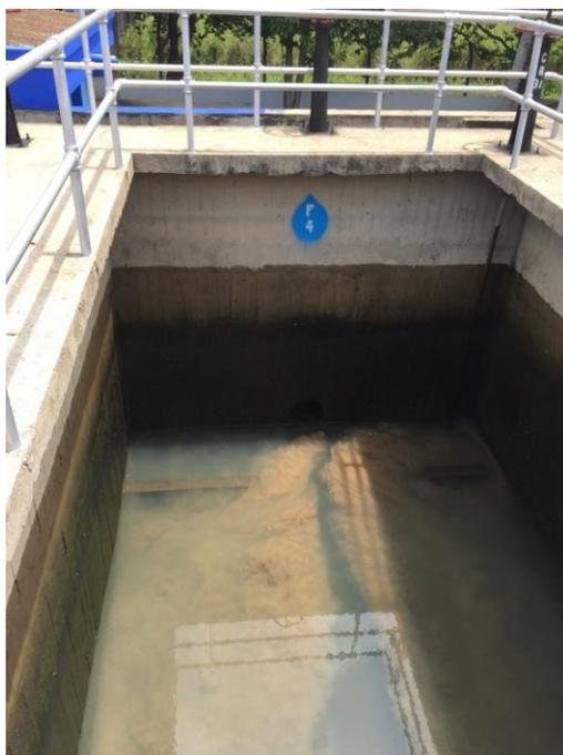
*Figura 26. Filtro con bajo nivel de agua.*
