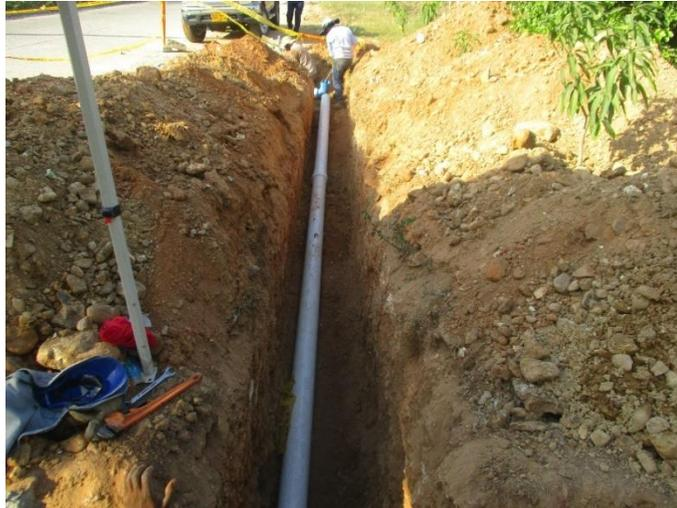
*Figura 81. Instalación de accesorios para empalme N° 1*
