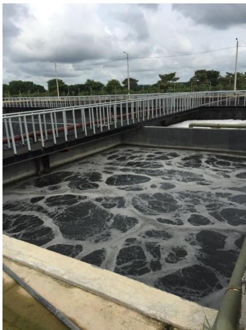
*Figura 49. Tanque de aireación.*
