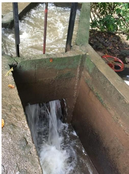
*Figura 3. Filtración de agua en compuerta del desarenador 1.*
