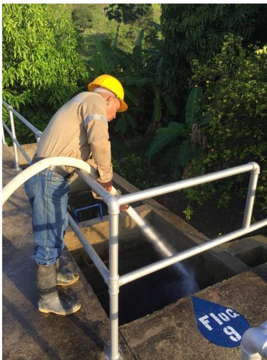
*Figura 20. Lavado de floculador con manguera a presión.*
