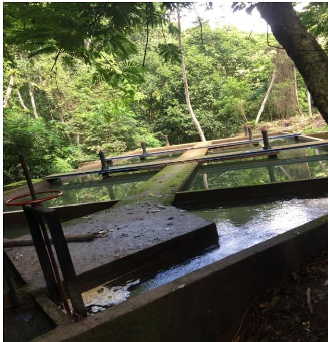
*Figura 13. Desarenadores en funcionamiento.*
