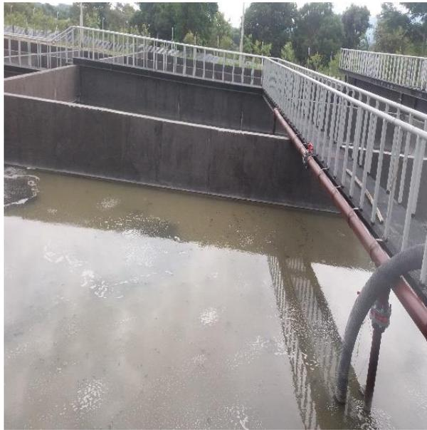
*Figura 68. Sedimentador primario.*
