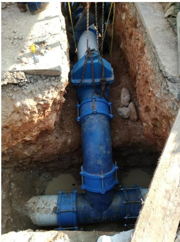
*Figura 93. Accesorios en tubería nueva de empalme H*
