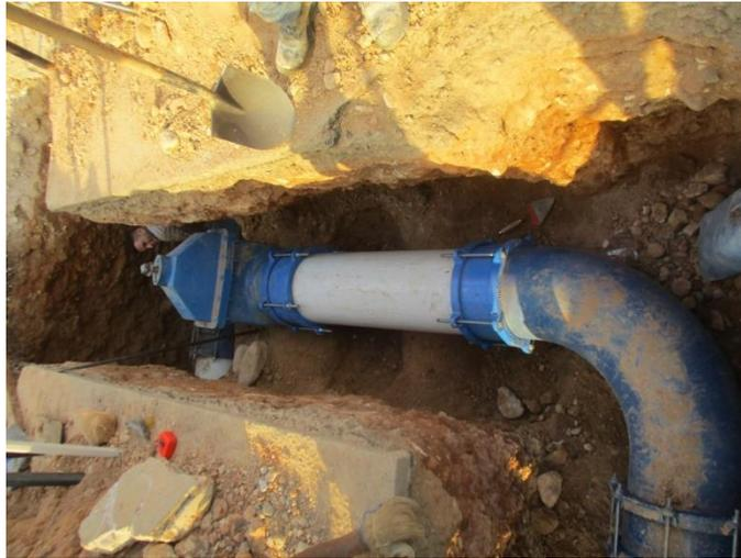
*Figura 95. Accesorios en tubería nueva de empalme H*
