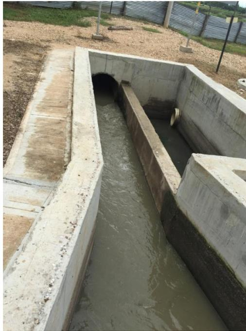
*Figura 63. Tubería de entrada agua residual.*
