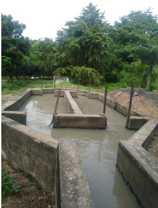
*Figura 52. Desarenador en funcionamiento.*
