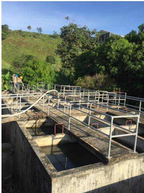
*Figura 18. Floculadores de pantalla en funcionamiento.*
