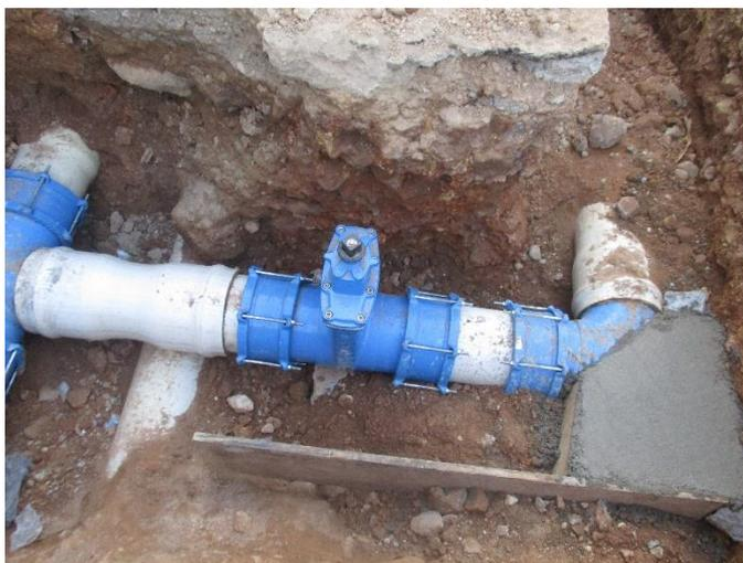
Figura 101. Accesorios instalados de empalme #5.
