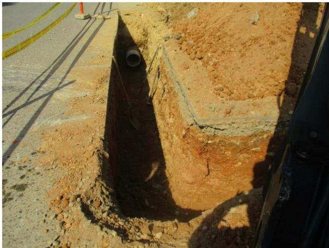
*Figura 86. Zanja para continuación de empalme H con tubería instalada*
