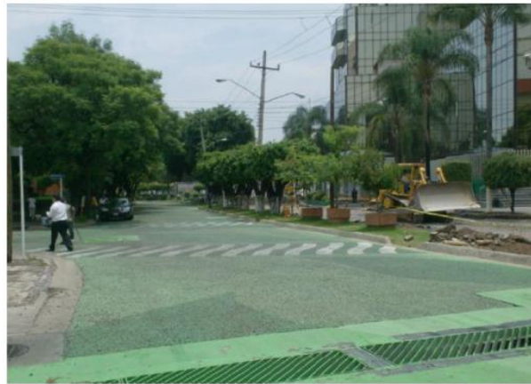
Figura 31. Pavimento poroso en el hotel Intercontinental de Zapopan en Jalisco, México Fuente: Castro, 2011. Pavimentos permeables como alternativa de drenaje urbano . p. 72
