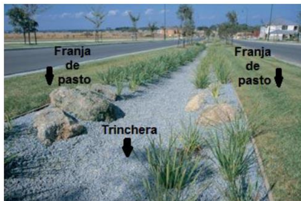
Figura 24. Uso conjunto de trincheras y franjas de pasto
