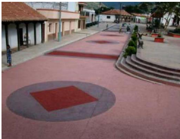
Figura 29. Pavimento poroso en la ciudad de Soslayo, Chiapas, México Fuente: Castro, 2011. Pavimentos permeables como alternativa de drenaje urbano . p. 71
