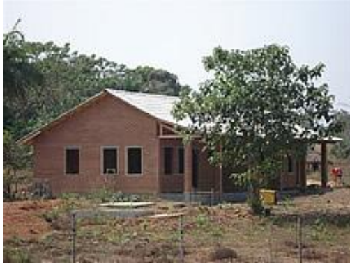
Figura 39. Casa construida en BTC sin estructuras de hormigón. Obtenido de: https://www.oskam-vf.com/
