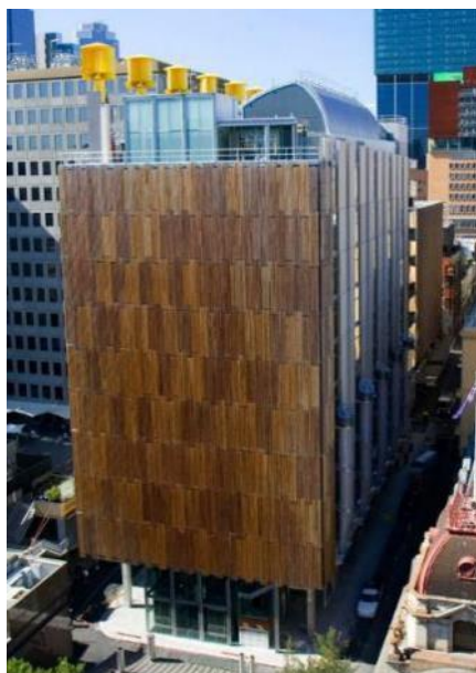
Figura 2. Fachada occidental en madera, fachada norte con turbinas eólicas, fachada sur con conductos verticales. Obtenido: https://www.melbourne.vic.gov.au
