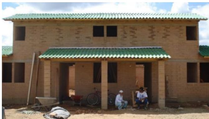
Figura 35. VIS construida con BTC. Obtenido de: proyecto CASA VIVA.
