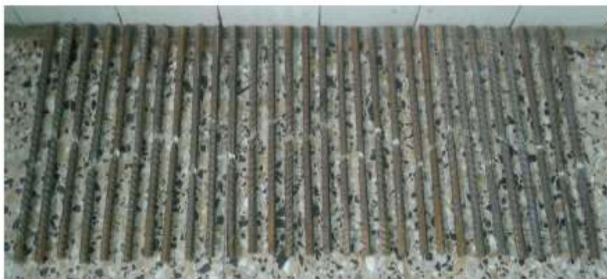
Figura 24. Probetas sin empalme después de la falla a tracción Fuente: Alvis Fonseca & Guerra Bejarano. Análisis técnico, económico y constructivo del uso de empalmes mecánicos roscados en edificaciones. 2017, p.37.
