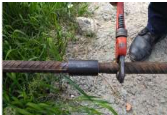
Figura 19. Acoplamiento de la segunda barra de acero al conector
