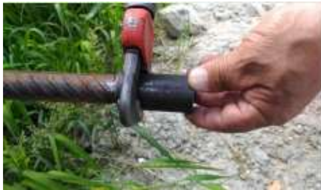
Figura 18. Acoplamiento del conector en la barra de acero
