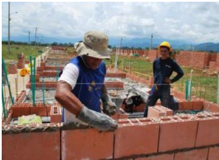
Ilustración 9. Proceso de construcción de muros.
