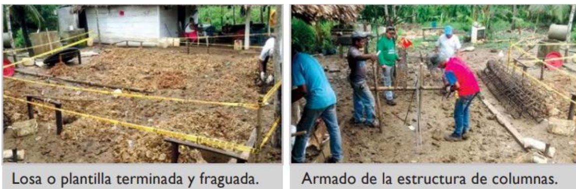
Figura 4. Cimentación base en palafitos
