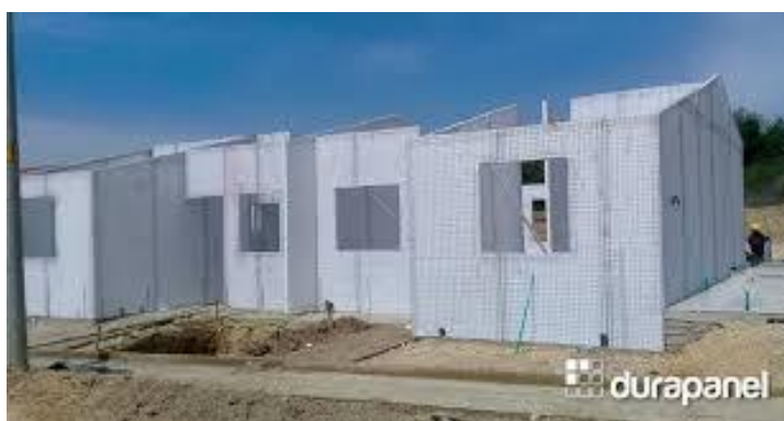
Ilustración 17. Construcción modular en Durapanel.
