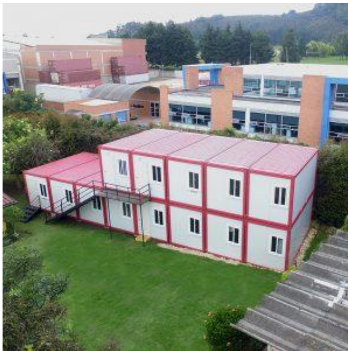
Ilustración 23. Construcción en contenedores desarmables.
