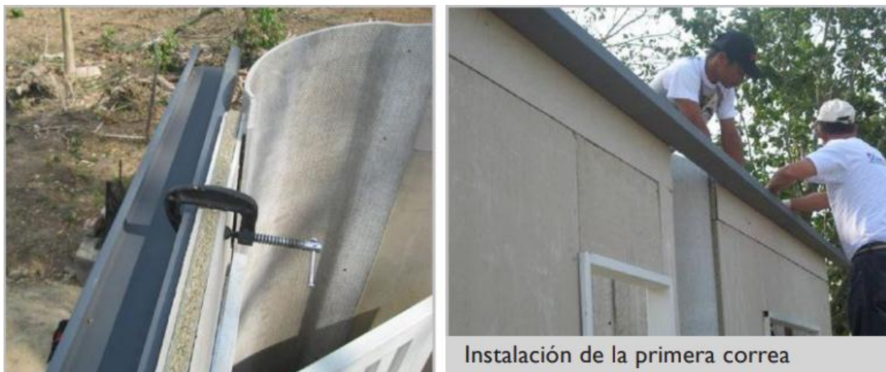
Figura 10. Instalación de cubierta.
