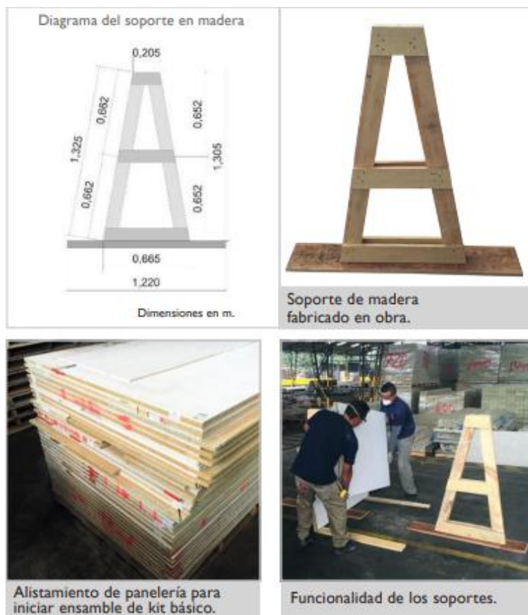
Figura 8. Alistamiento de paneles
