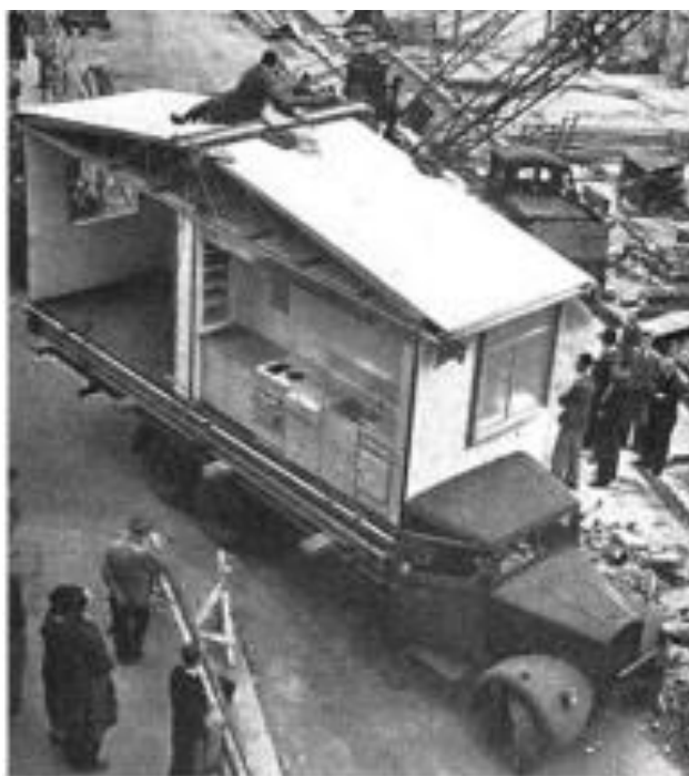
Ilustración 11. Construcción tridimensional en modulos ligeros 1945.
