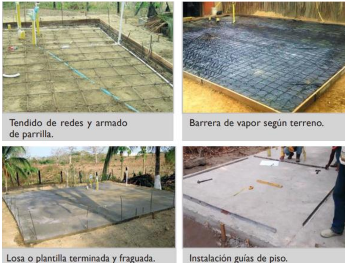
Figura 3. Fundición losa en concreto.
