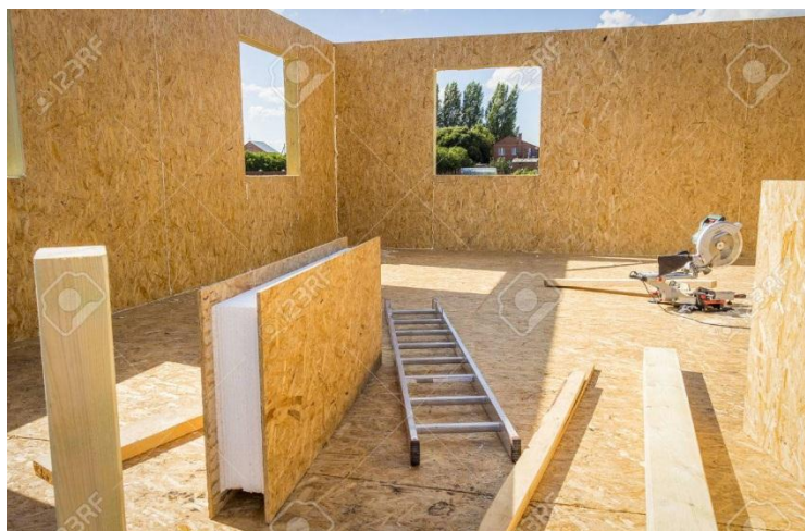
Ilustración 15. Construcción en sip panel
