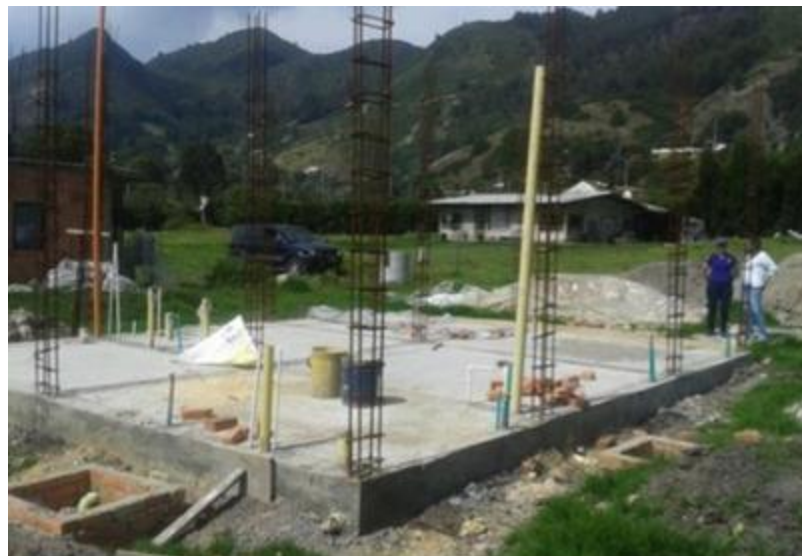
Ilustración 8. Losa de base de vivienda de interés social.
