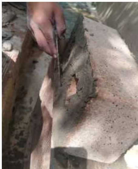
Figura 17. Conformación de capa de mortero en los bloques de tierra comprimida
