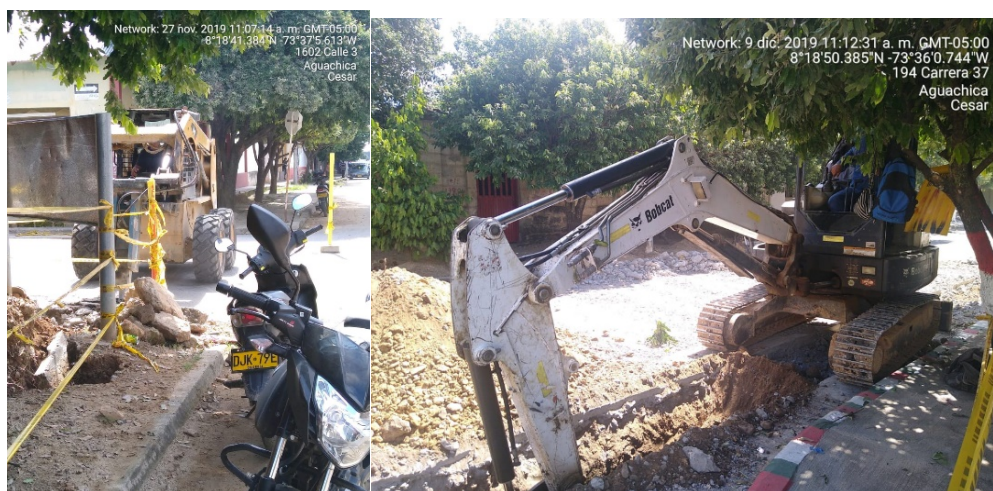
Remoción de pavimento
