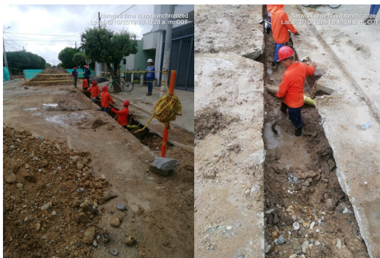
Figura 18. Remoción del material de relleno saturado.
