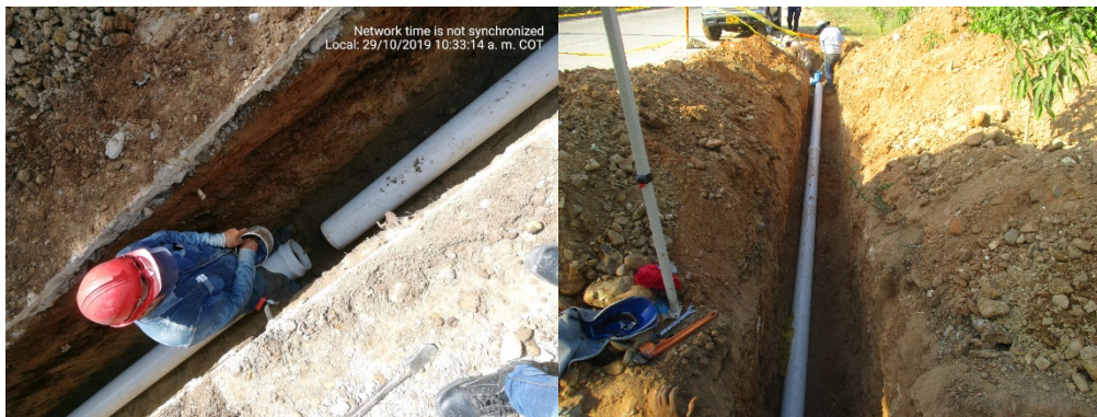
Instalación de tubería de acueducto
