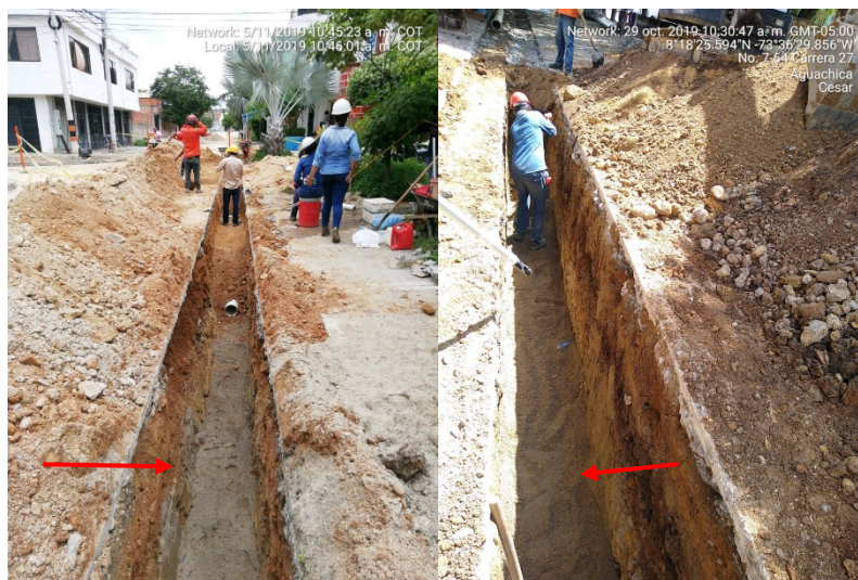
Instalación de la cama de arena
