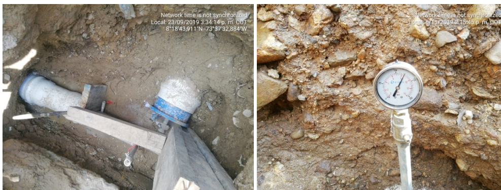
Atraques y manómetros instalados
