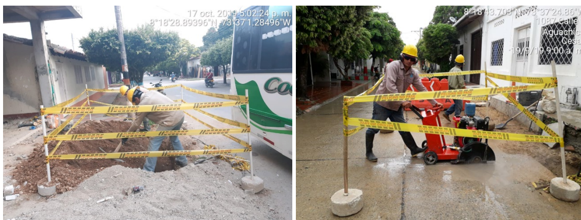
Figura 6. Apique, Corte y demolición de pavimento
