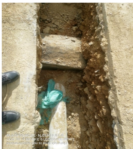
Figura 22. Recubrimiento en concreto a la tubería de acueducto
