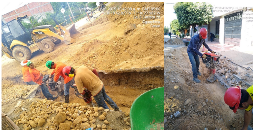
Relleno y compactación de la zanja
