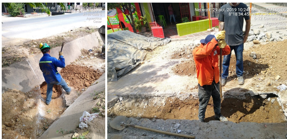
Excavación manual para instalación de tubería
