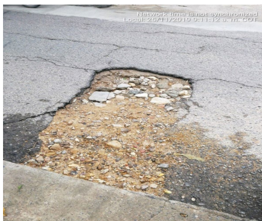
Figura 27. Demolición de pavimento pendiente por reparación.
