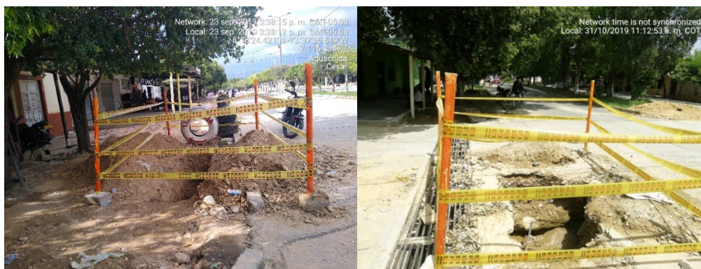
Señalización implementada en los lugares de trabajo
