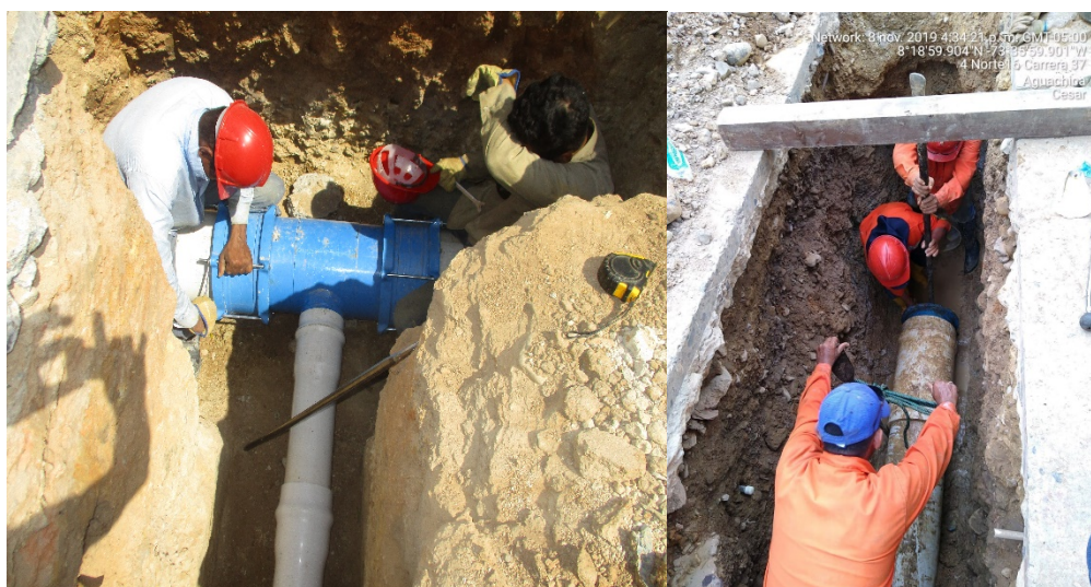
Suministro e instalación de accesorios
