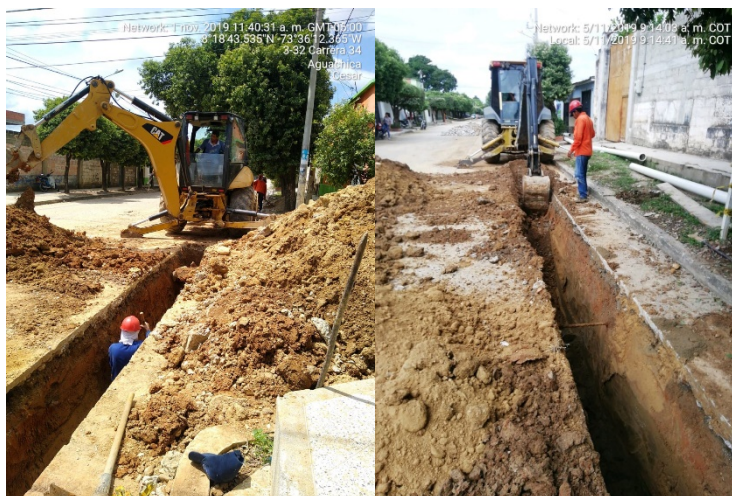
Excavación mecánica para instalación de tubería
