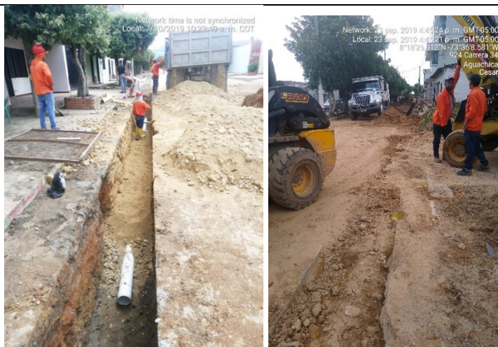
Disposición y transporte de material de sobrante
