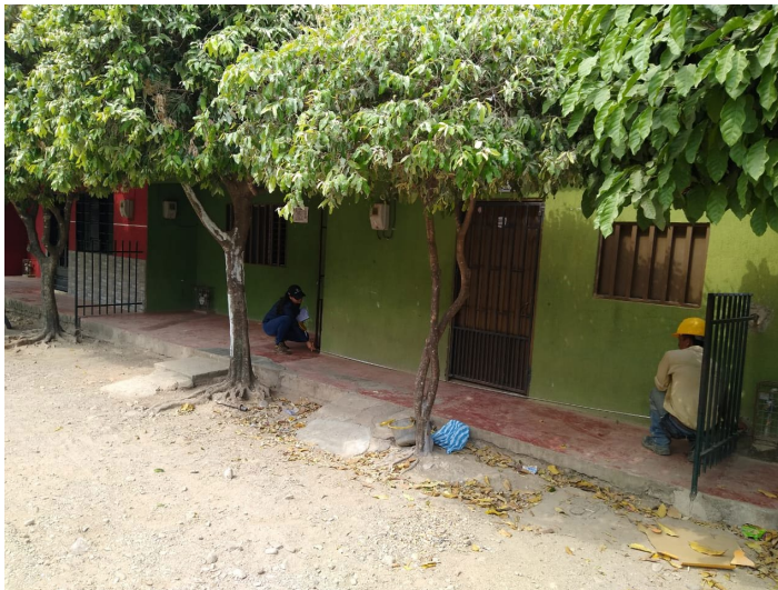
Figura 32. Toma de medidas de frentes de vivienda
