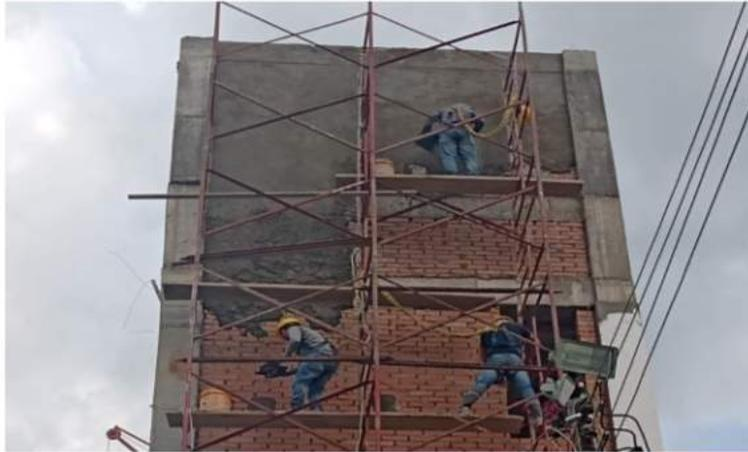
Nota: Aplicación de pañete sobre muro de la fachada del edificio de ingeniería de sistemas y telecomunicaciones. Fuente: autor (2021).
