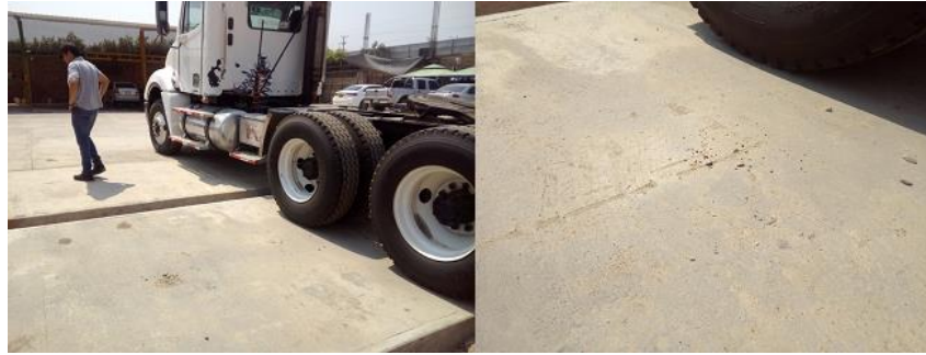
Figura 30. Losas en concreto auto lavado CARS WASH, MallaPET 3D.
