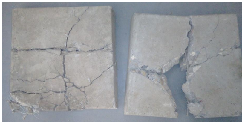
Figura 31. Losas en concreto auto lavado CARS WASH, MallaPET 3D.
