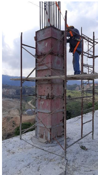
Figura 6. Instalación de formaletas metálicas para columnas del quinto piso
