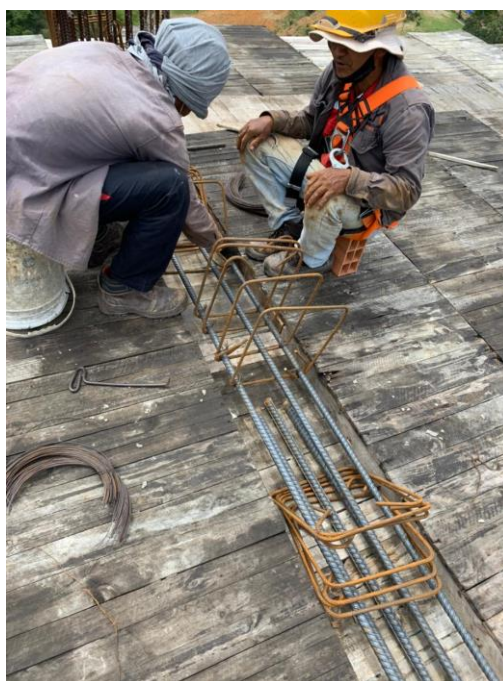
Figura 24. Figurado de acero de vigas para la losa sexta
