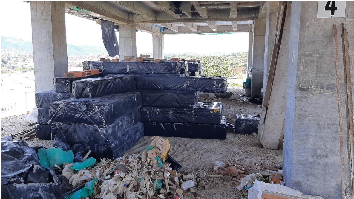
Figura 29. Armado de casetones
