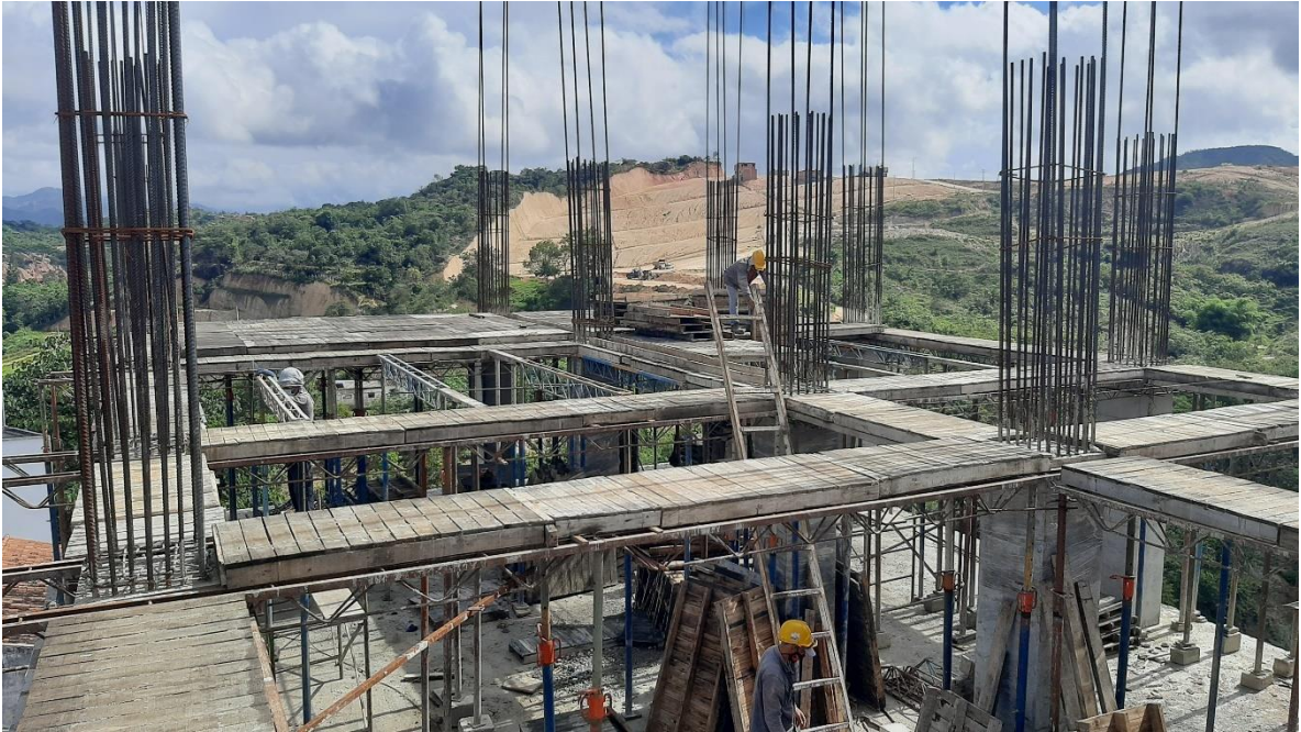
Figura 19. Instalación de estibas para losa sexta
