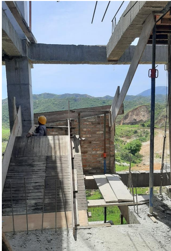
Figura 21. Montaje de obra falsa para escaleras del cuarto piso
