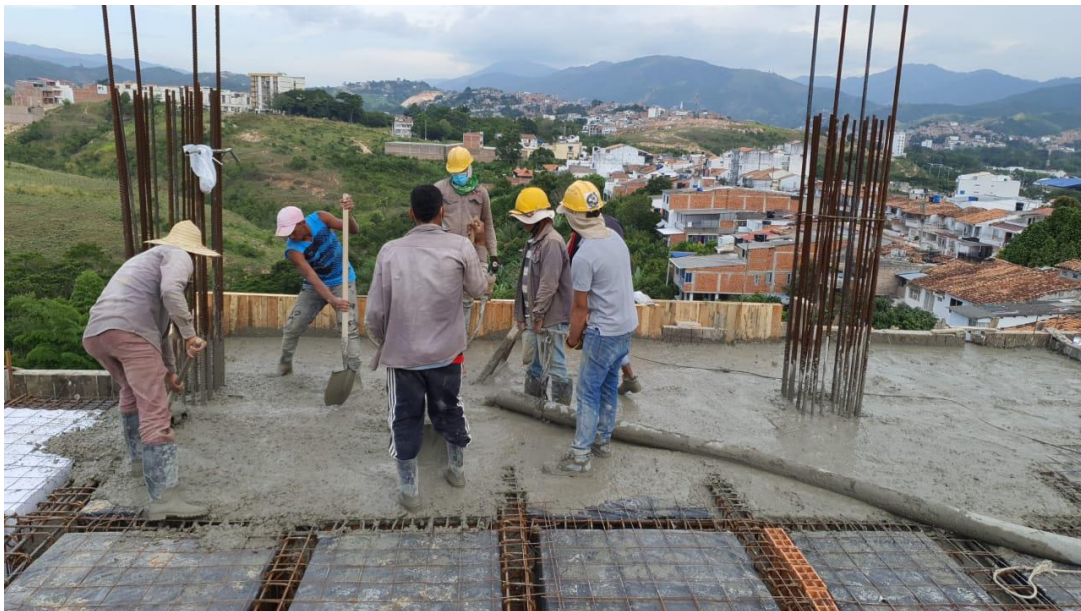
Figura 32. Vaciado de concreto para la losa del sexto piso
