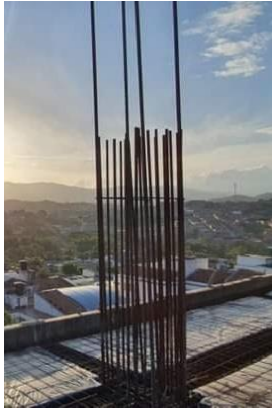
Figura 31. Instalación de casetones y malla electro soldada para losa del sexto piso
