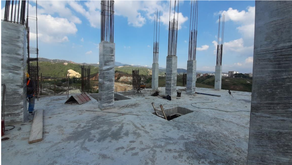
Figura 11. Fraguado de columnas del quinto piso
