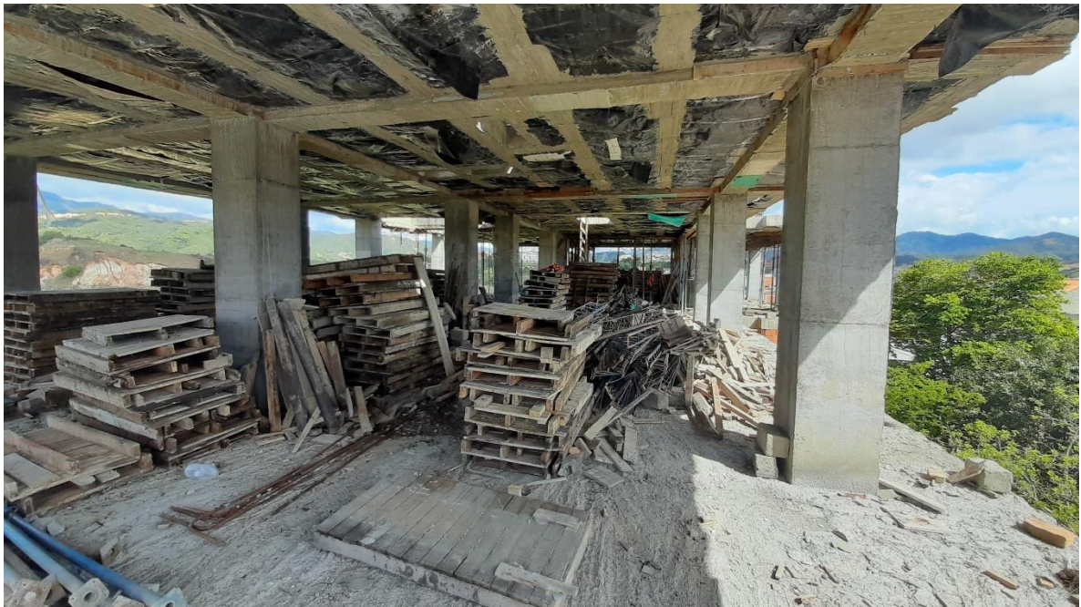
Figura 16. Desmonte de obra falsa losa quinta
