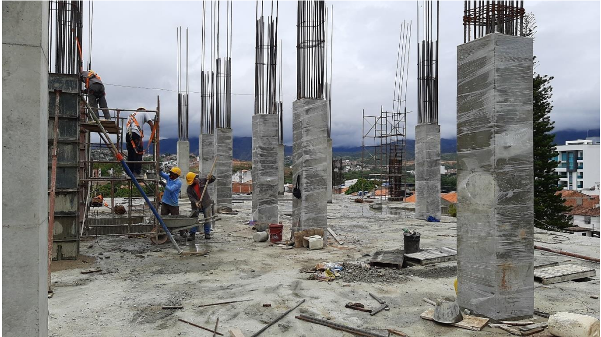
Figura 7. Fundición de columnas del quinto piso
