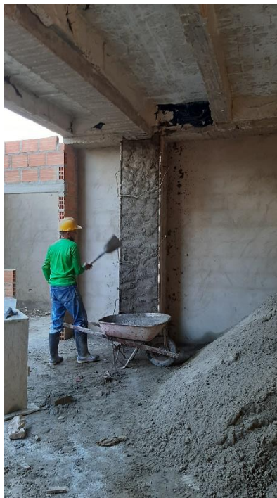
Figura 14. Instalación de pañete
