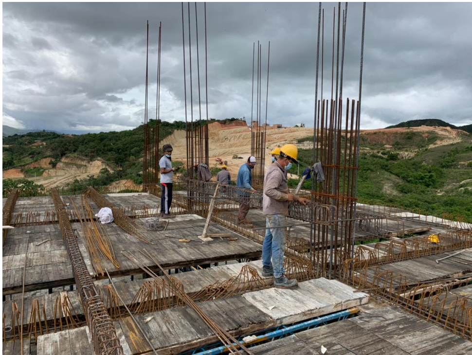
Figura 26. Figurado de acero de viguetas para la losa sexta
