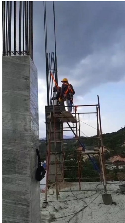
Figura 8. Vibrado de concreto de columnas del quinto piso
