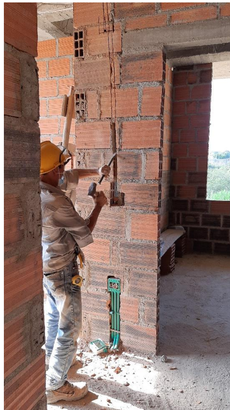
Figura 12. Abertura de regatas e instalación de tubería para sistema eléctrico
