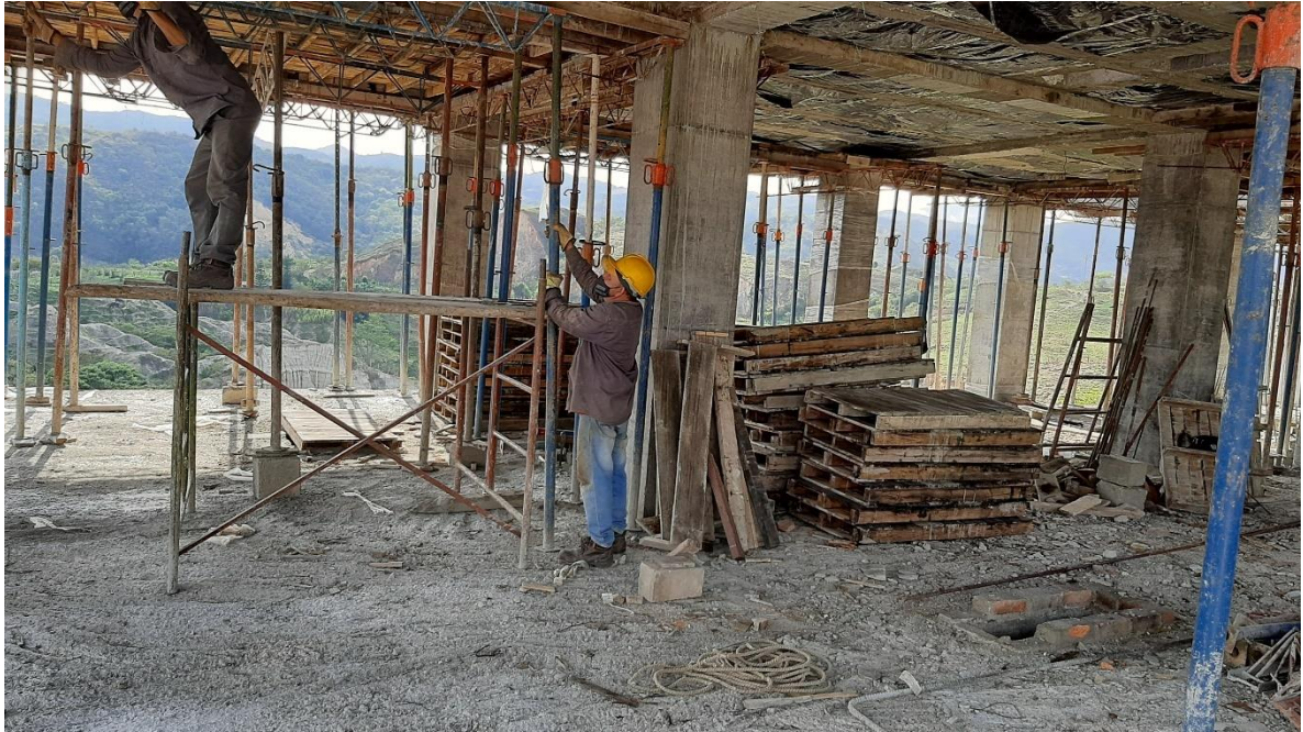
Figura 15. Desmonte de obra falsa losa quinta
