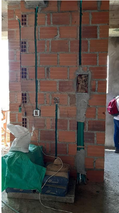
Figura 13. Abertura de regatas e instalación de tubería para sistema eléctrico
