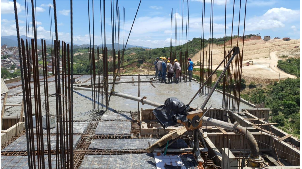
Figura 33. Vaciado de concreto para la losa del sexto piso
