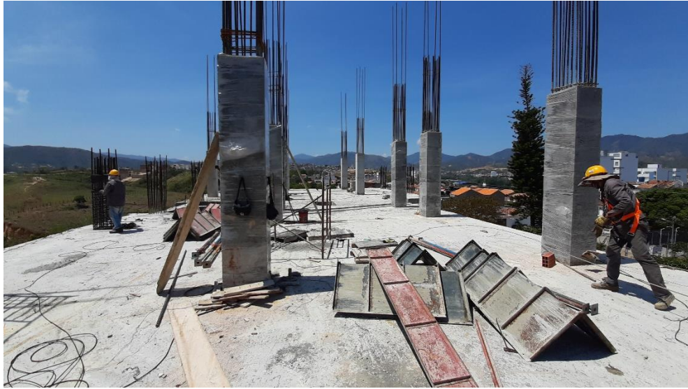
Figura 9. Retiro de formaletas metálicas de columnas del quito piso
