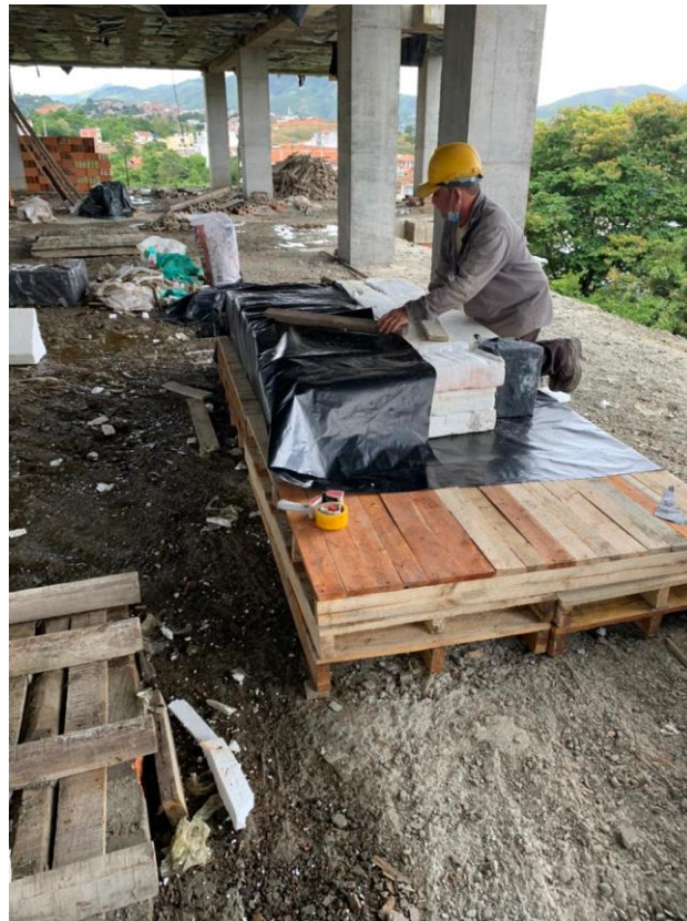
Figura 28. Armado de casetones
