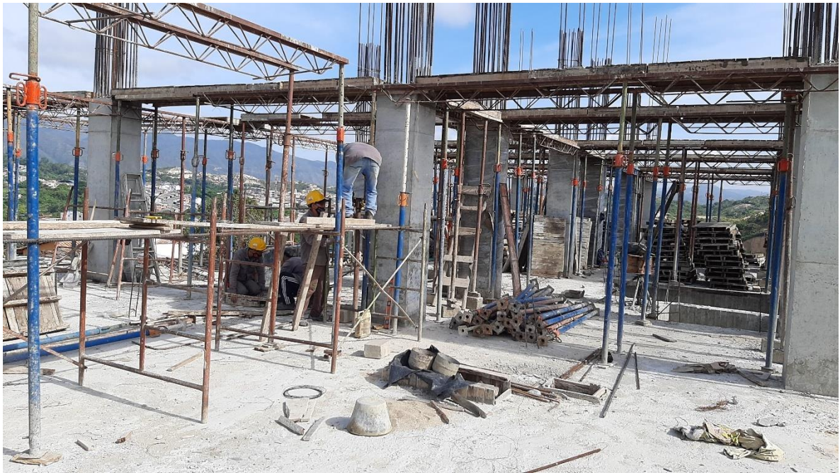
Figura 18. Instalación de cerchas y parales para losa sexta
