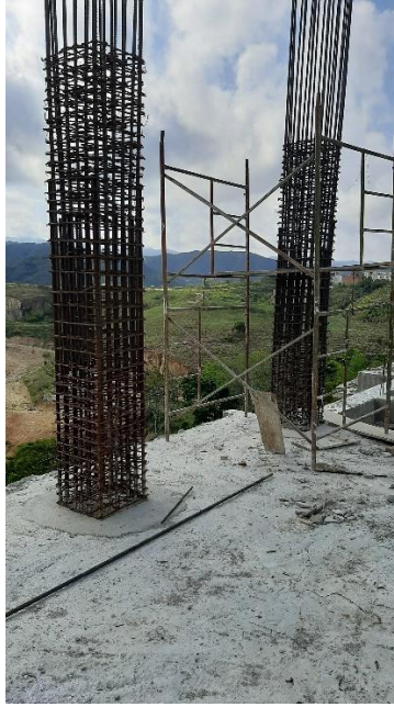
Figura 5. Figurado de acero para columnas del quinto piso
