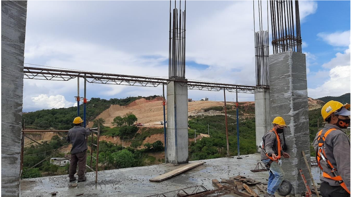
Figura 17. Instalación de cerchas y parales para losa sexta
