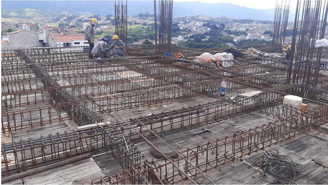
Figura 27. Figurado de acero de vigas y viguetas para la losa sexta
