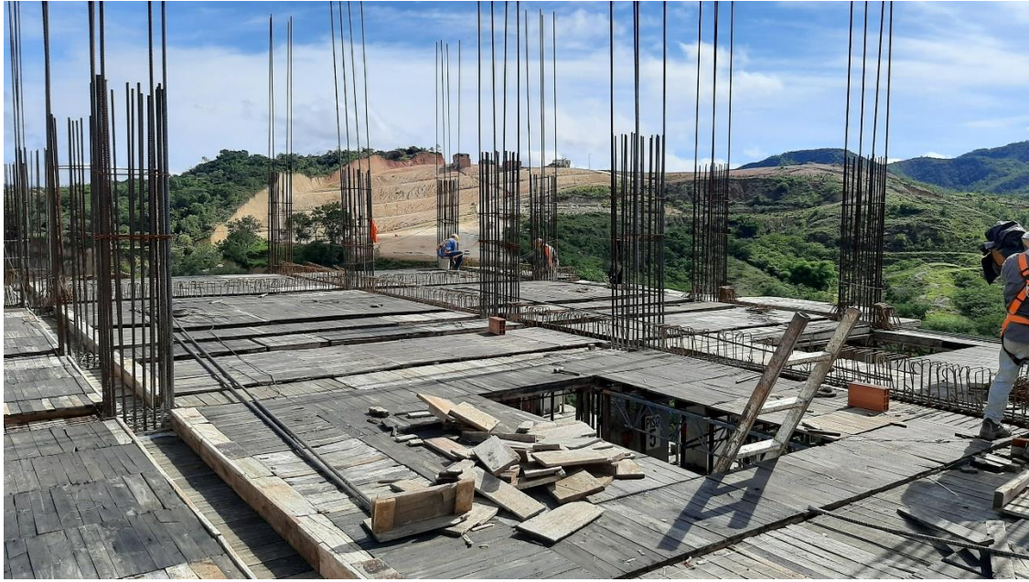
Figura 25. Figurado de acero de vigas para la losa sexta
