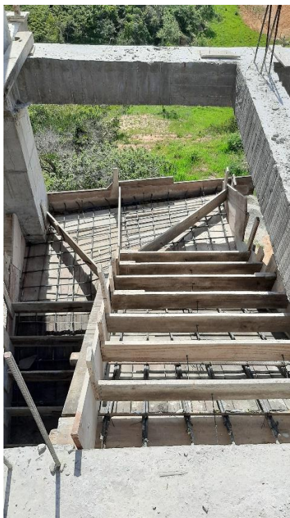
Figura 23. Armado de huellas para escaleras del cuarto piso
