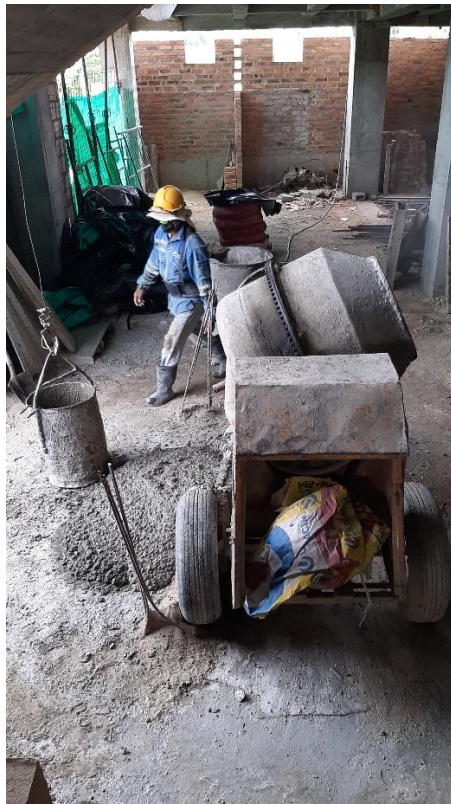
Figura 10. Preparación de mortero para columnas del quito piso
