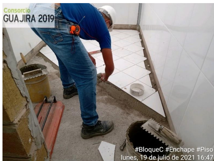
Figura 29. Enchape piso baños. Fuente: pasante
