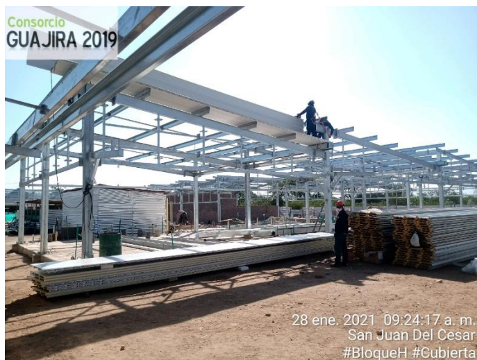
Figura 10 y 11. Instalación de cubierta monorooft. Fuente: pasante
