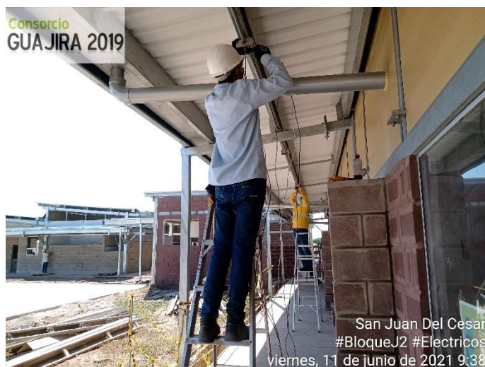
Figura 17. Instalación salidas tomacorrientes. Fuente: pasante
