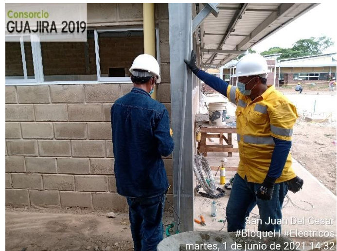
Figura 20. Apantallamiento. Fuente: pasante
