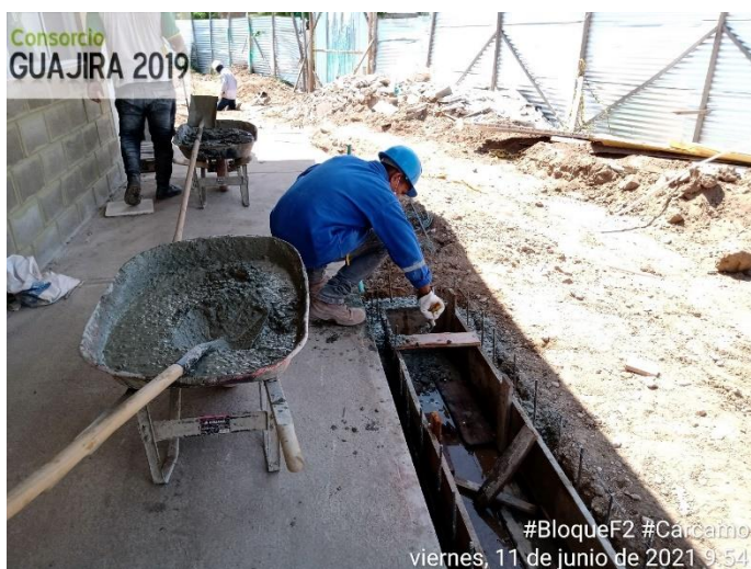
Figura 44. Vaciado concreto cárcamo aguas lluvias. Fuente: pasante
