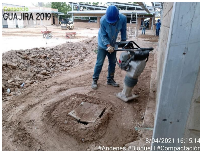
Figura 6. Compactación mecánica terreno. Fuente: pasante
