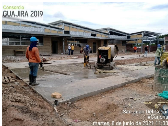
Figura 46. Vaciado concreto cimentación cancha múltiple y malla de impacto. Fuente: pasante
