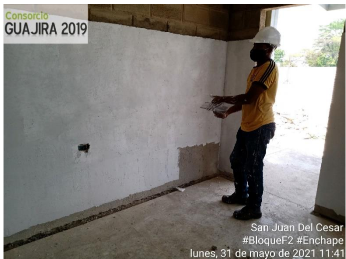
Figura 22. Estuco de muros. Fuente: pasante
