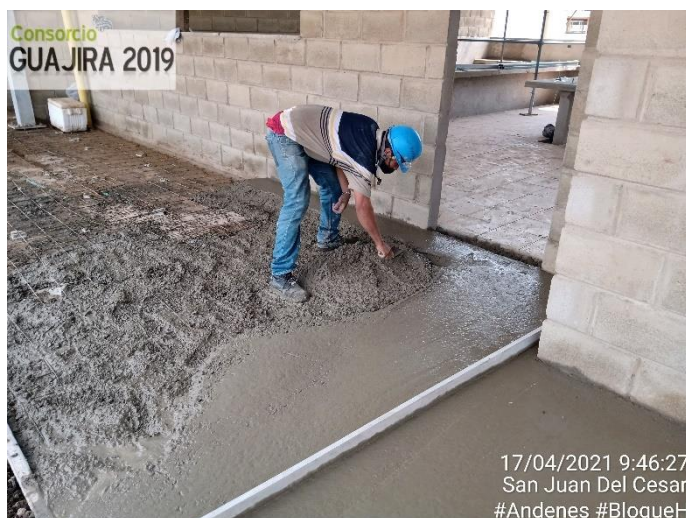
Figura 8. Vaciado concreto andenes. Fuente: pasante
