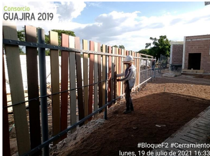
Figura 35. Instalación WPC cerramiento exterior. Fuente: pasante
