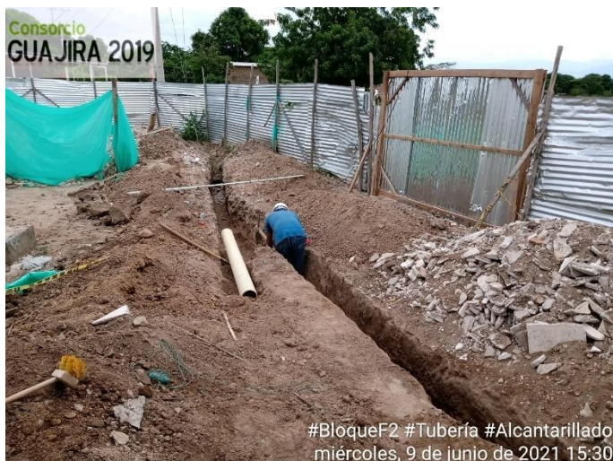
Figura 45. Instalación tubería alcantarillado sanitario. Fuente: pasante
