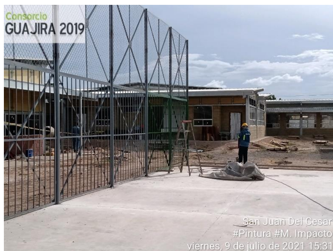
Figura 40. Instalación y pintura malla de impacto cancha múltiple. Fuente: pasante
