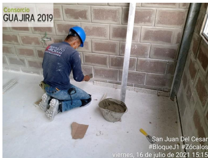
Figura 32. Instalación zócalos baldosa granito. Fuente: pasante
