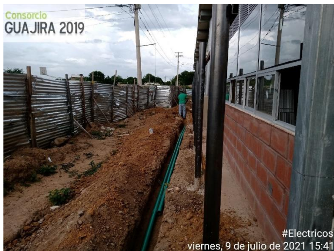
Figura 39. Instalación tubería eléctrica media tensión. Fuente: pasante
