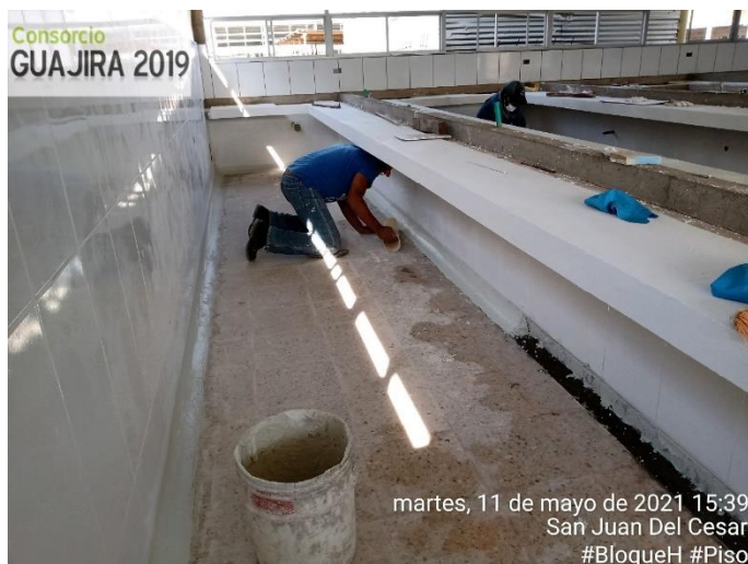
Figura 25. Instalación granito mesones laboratorio. Fuente: pasante
