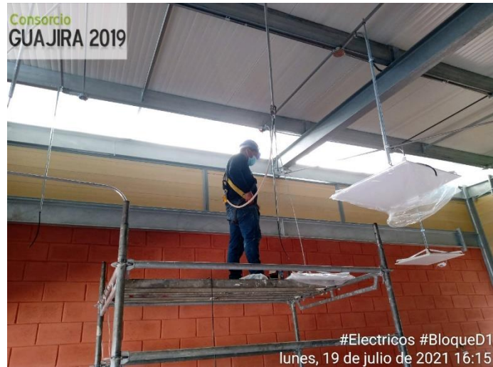
Figura 19. Instalación lámparas. Fuente: pasante
