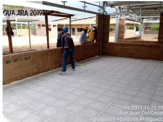
Figura 15. Fraguado o emboquillado baldosa granito. Fuente: pasante
