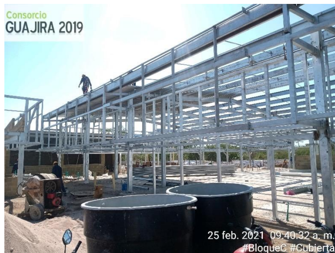
Figura 10 y 11. Instalación de cubierta monorooft. Fuente: pasante
