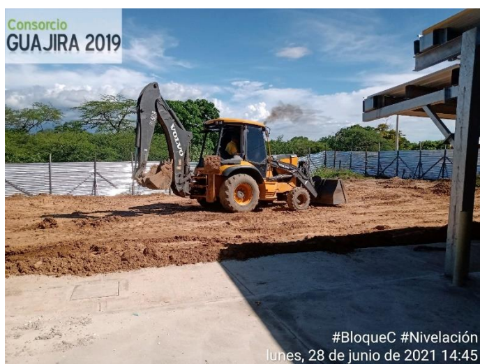
Figura 41. Nivelación mecánica de terreno. Fuente: pasante
