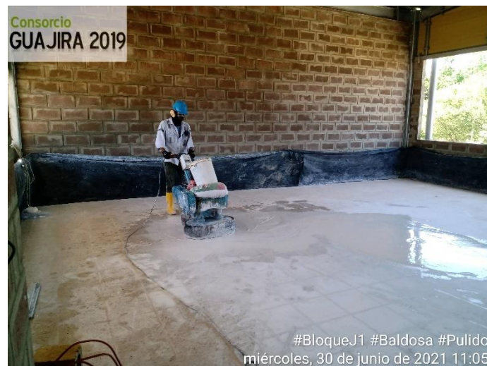
Figura 16. Destronque baldosa granito. Fuente: pasante
