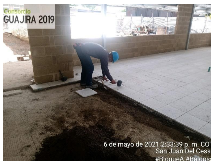
Figura 14. Instalación baldosa granito. Fuente: pasante
