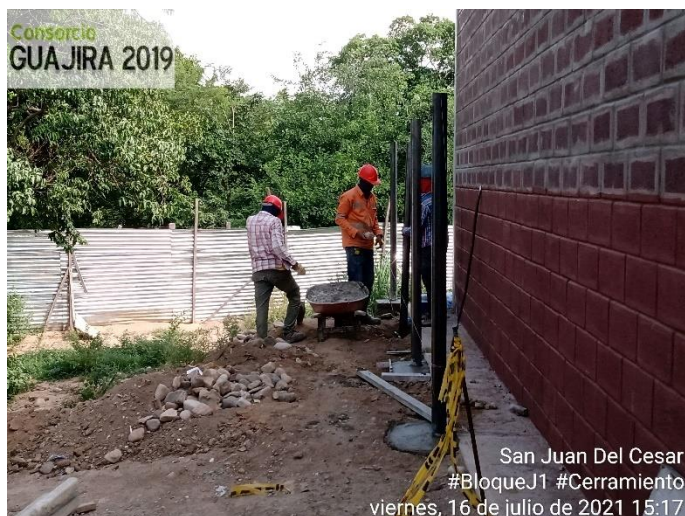
Figura 43. Instalación estructura cerramiento general. Fuente: pasante
