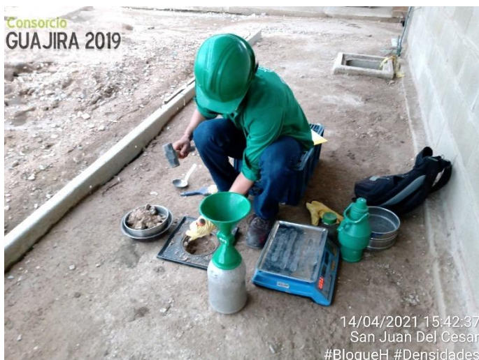
Figura 7. Toma ensayo densidad de compactación. Fuente: pasante
