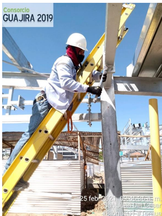
Figura 12 y 13. Torque tornillería estructura metálica. Fuente: pasante
