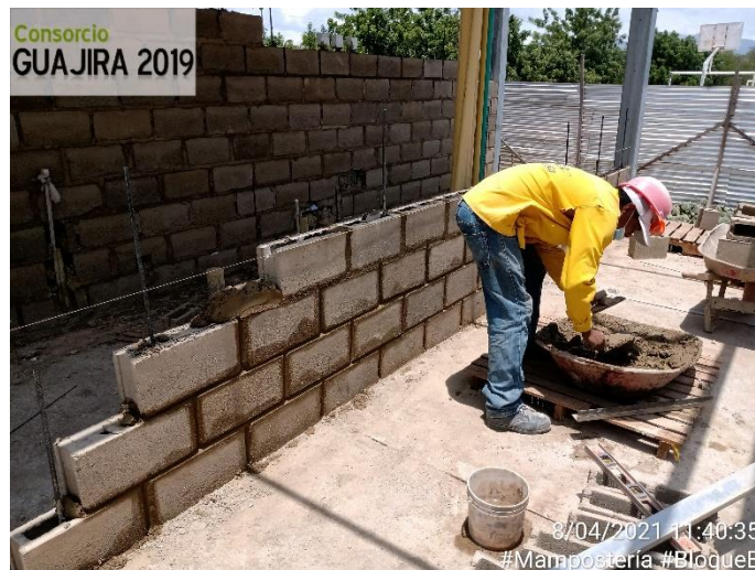
Figura 5. Actividad de mampostería estructural. Fuente: pasante
