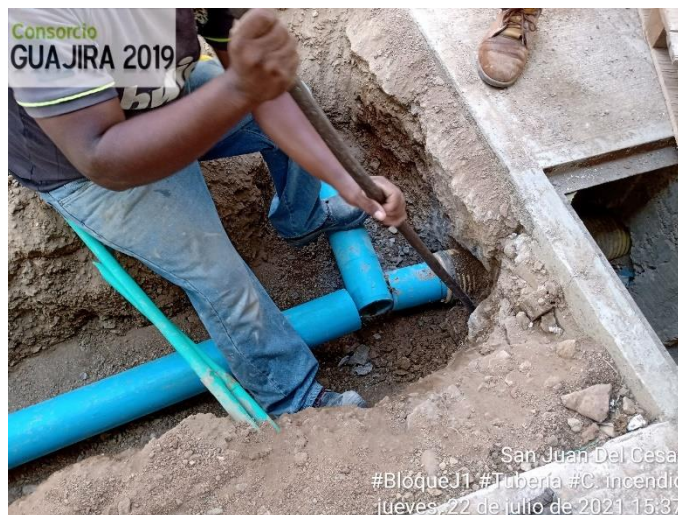
Figura 33. Instalación red tubería contra incendio. Fuente: pasante
