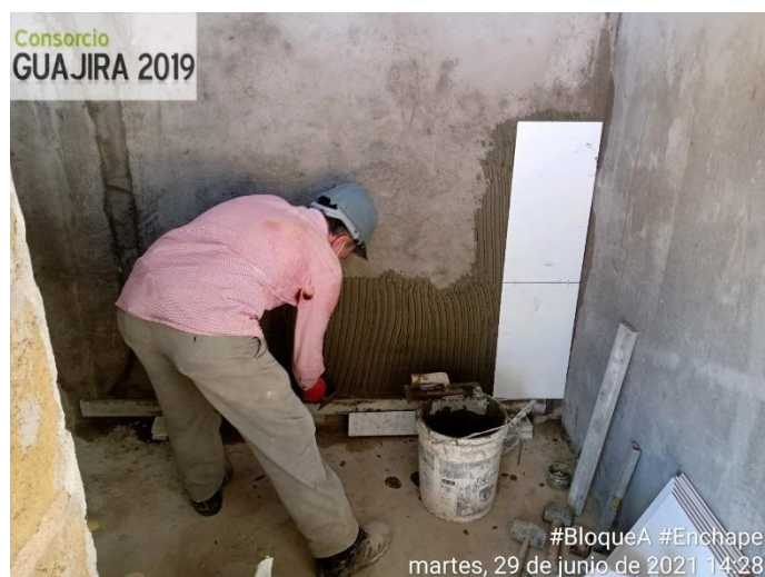
Figura 28. Enchape muros baños. Fuente: pasante
