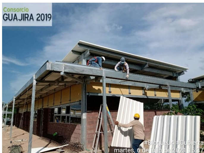
Figura 38. Instalación cubierta termoacústica aleros. Fuente: pasante
