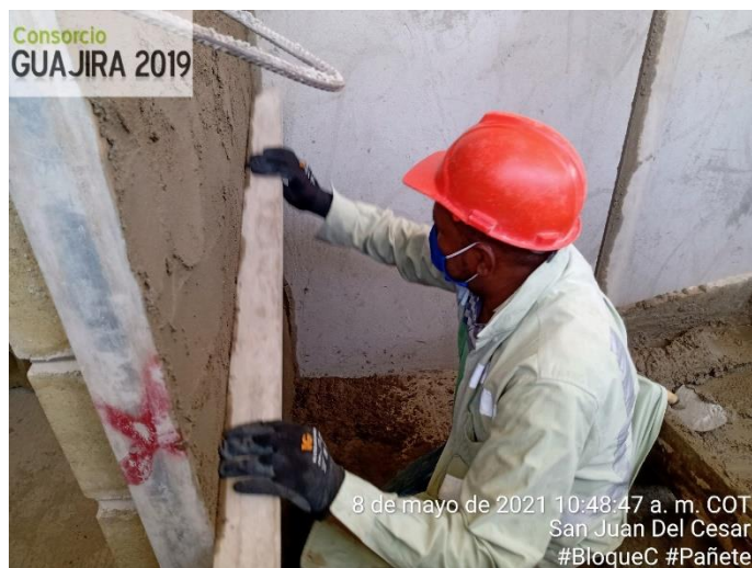
Figura 27. Pañete muros baños. Fuente pasante
