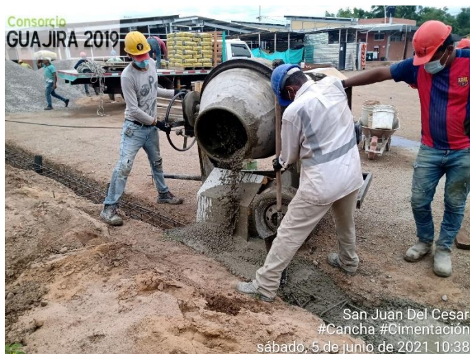
Figura 46. Vaciado concreto cimentación cancha múltiple y malla de impacto. Fuente: pasante
