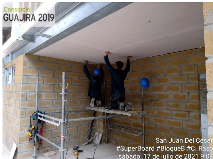
Figura 31. Instalación cielo raso en superboard. Fuente: pasante
