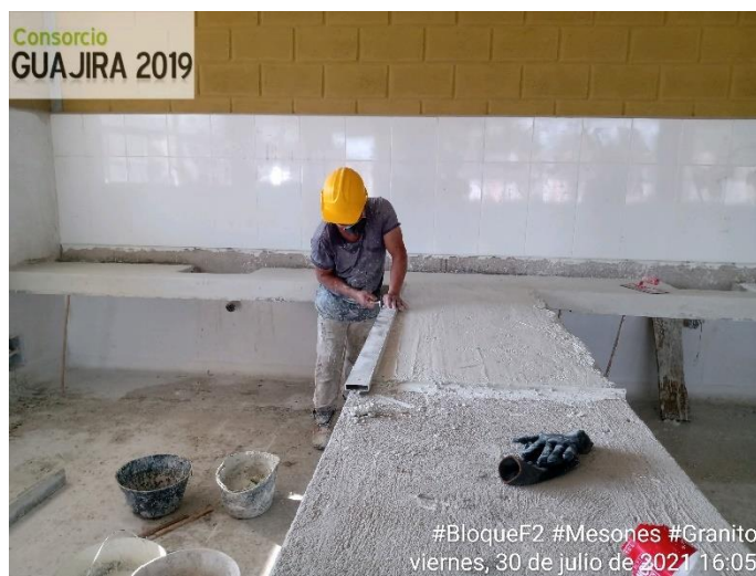
Figura 25. Instalación granito mesones laboratorio. Fuente: pasante
