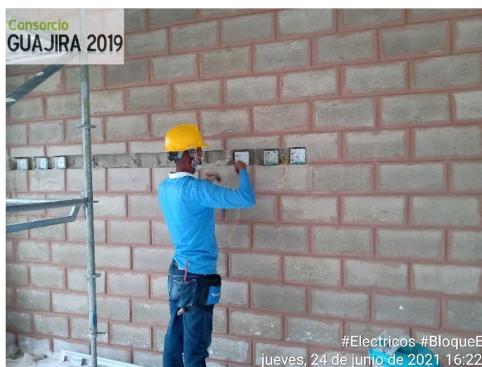
Figura 17. Instalación salidas tomacorrientes. Fuente: pasante
