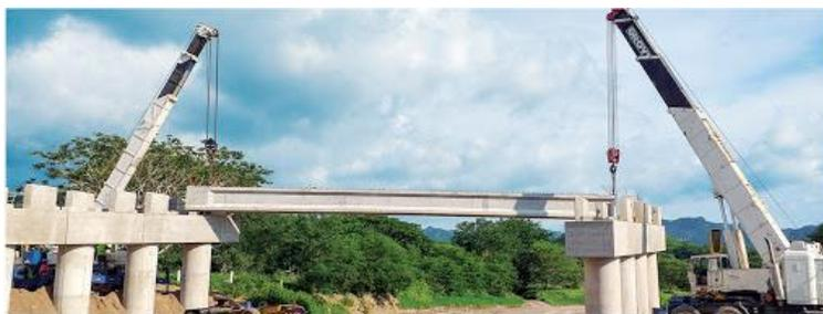
*Figura 49.* Puente con sección en I Simétrica presforzada en el estado de Toluca, México. Freyssinet.com, 2021. Obtenido en: [http://www.freyssinet.com/freyssinet/wfreyssinet\\_mx.nsf](http://www.freyssinet.com/freyssinet/wfreyssinet_mx.nsf)
