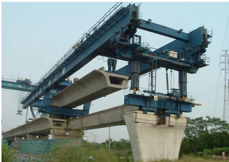
*Figura 48.* Puente con sección en caja presforzada en la región de Guangzhou, China. Wowjoint.com, 2015. Obtenido en: <https://wowjoint.com/index.php?c=article&id=2311>
