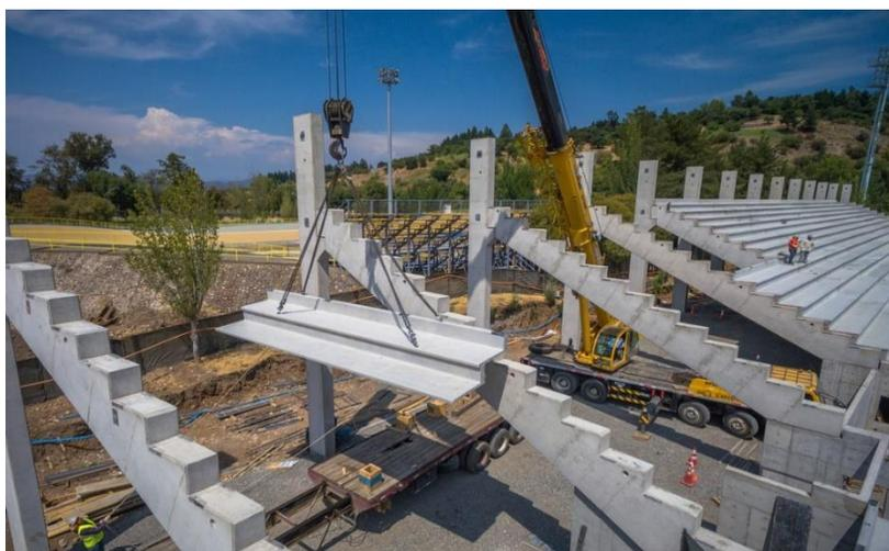
*Figura 50.* Construcción de un estadio en concreto presforzado. Plataformaarquitectura.cl., 2021. Obtenido en: <https://www.plataformaarquitectura.cl/catalog/cl/products/9944/graderias-y-estadios-prefabricados-sistema-tensocret/92065>
