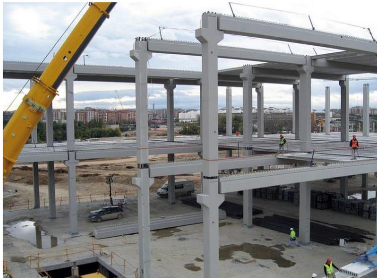
*Figura 51.* Construcción de un edificio con concreto postensado. Tecnyconta.es., 2021. Obtenido en: <https://www.tecnyconta.es/pilares-prefabricados/>
