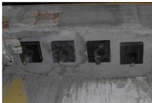
Reforzamiento del Centro Comercial Vizcaya - Postensado exterior con barras Sistemas DYWIDAG 36mm
