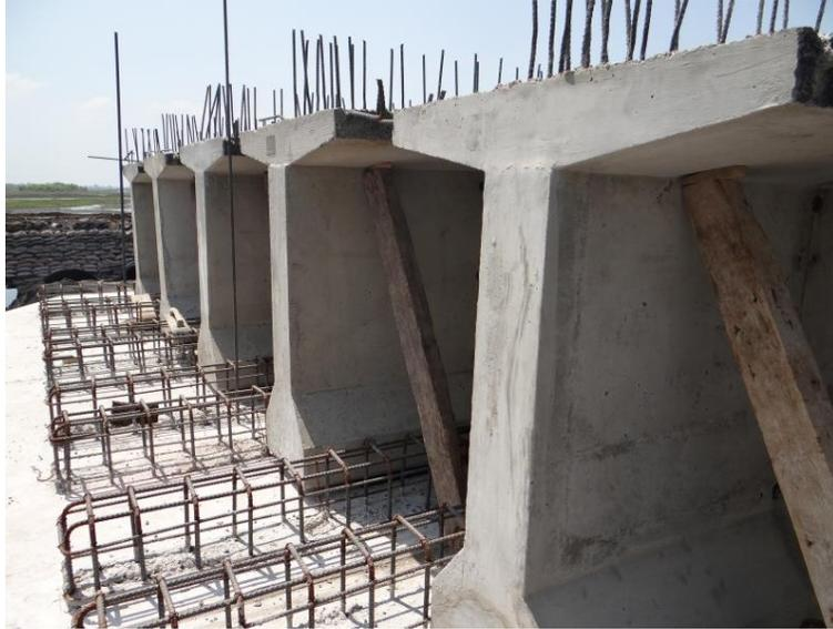
*Figura 42.* Sección I asimétrica común para concreto preesforzado y postensado. Precon.com, 2021. Obtenido en: <https://precon.com.gt/producto-especial/infraestructura-vial/viga-pretensada/>
