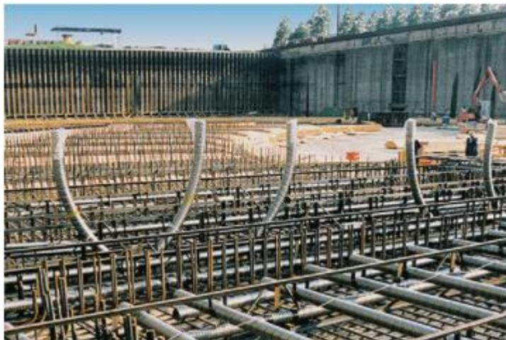
*Figura 14.* Anclaje en U fabricado por la empresa DYWIDAG. Obtenido en: <https://www.dywidag-sistemas.com/productos/sistemas-de-postesado-sistemas-de-pretensado/sistemas-de-postesado-de-cable-adherente/tipos-de-anclaje/>
