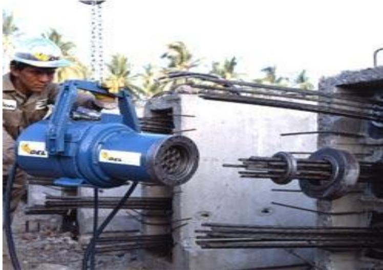
*Figura 8.* Gato multitorón comúnmente empleado para el tensado del acero en el concreto preesforzado y postensado. Mexpresa.com, 2021. Obtenido en: <http://mexpresa.net/productos/presfuerzo.php>.
