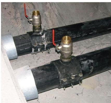
Toma de inyección sobre conducto en PEAD
