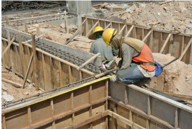
*Figura 22.* Armado y encofrado de elementos estructurales para el posterior vaciado de concreto. Cementosinka.com, 2021. Obtenido en: <http://www.cementosinka.com.pe/blog/ventajas-y-desventajas-del-concreto-armado/>
