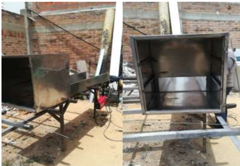
Figura 5. Construcción del secador. Fuente: Autores del proyecto
