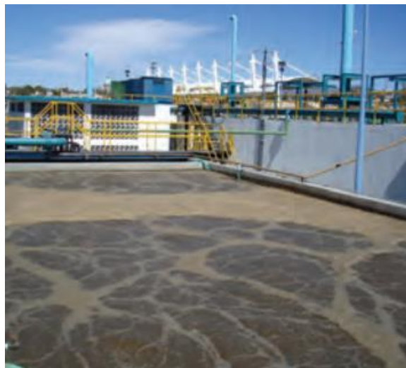
Figura 19. Figura 18. Lodos activados. (2003) Obtenido de: http://www.pronaturasur.org/web/docs/Tecnologia_Aguas_Residuales.pdf
