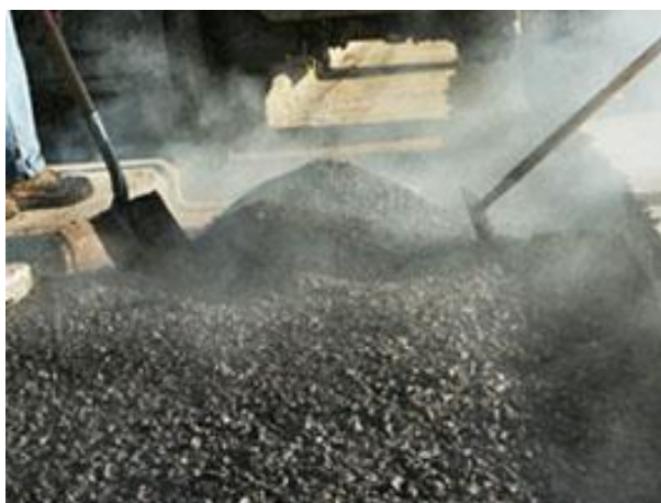
Figura 28. Fabricación de mezcla asfáltica en caliente. Obtenido en: https://empaquestemperatura.blogspot.com/2014/10/mezcla-asfaltica-en-frio-para-bacheo.html
